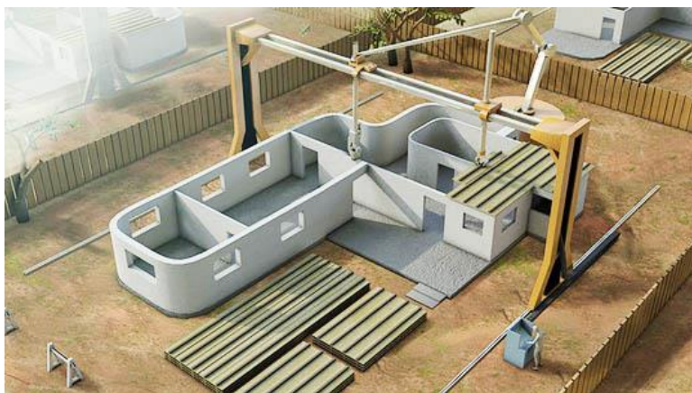
Joonis 1.3 Contour crafting tehnoloogia illustratsioon [17]
