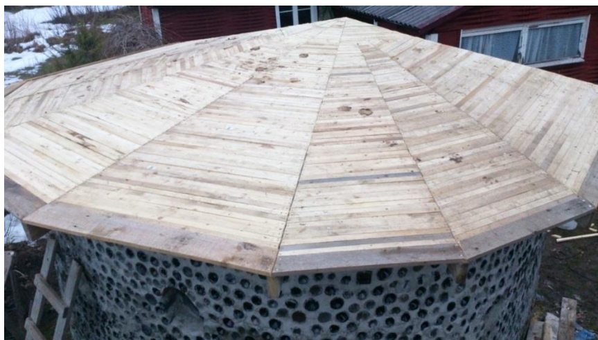
Joonis 3.5 Katuse roovitise osa (Foto: Triin Tõnisson)
