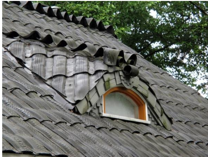
Joonis 1.3 Rehvi ribadest paigaldatud katus [49]
