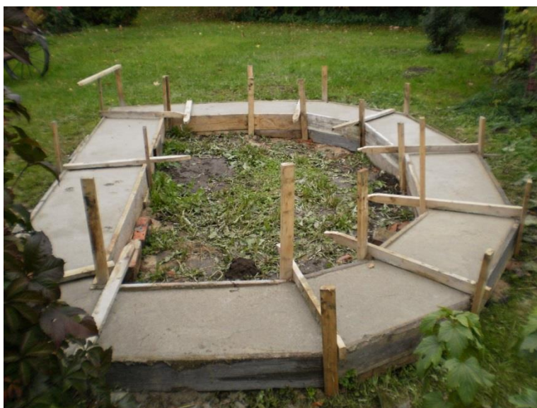
Joonis 3.1 Raketiste vahele rajatud vundament (Foto: Triin Tõnisson)
