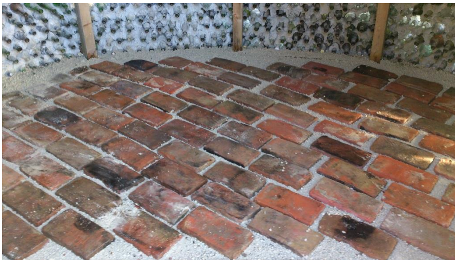
Joonis 3.7 Põranda rajamisel kasutati punaseid telliseid (Foto: Triin Tõnisson)
