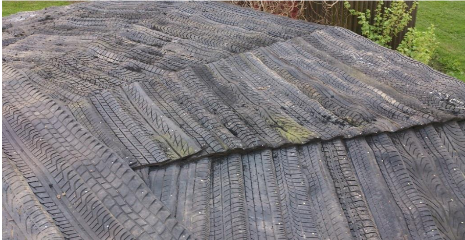
Joonis 3.6 Rehviribade paigutus katusel (Foto: Triin Tõnisson)
