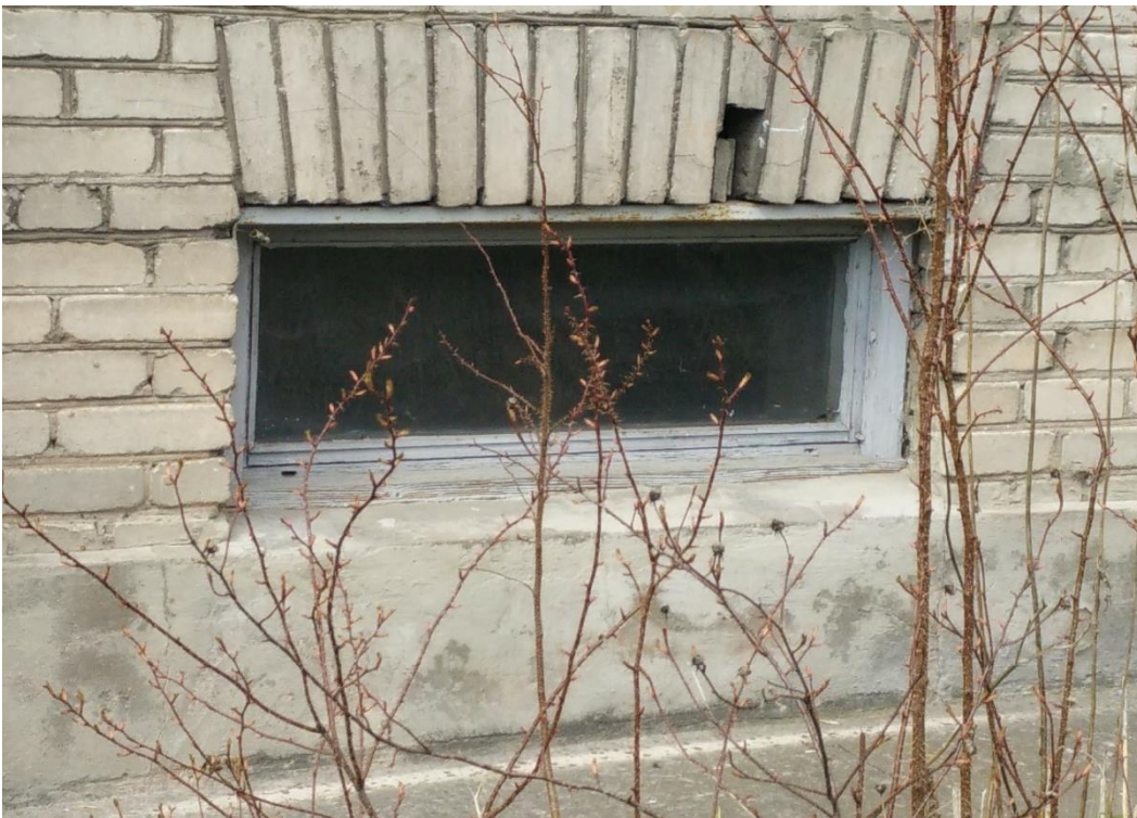
Joonis 3.5 Vahetamata keldriaken, lagunev sille
