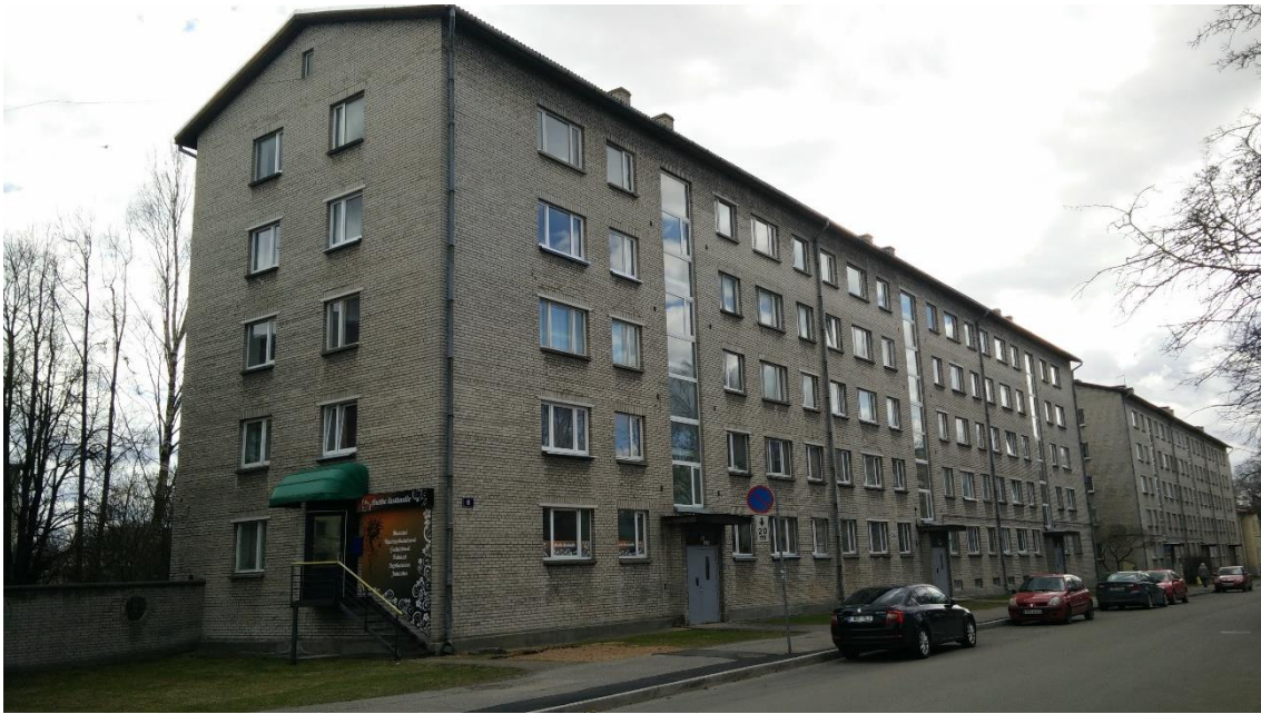
Joonis 3.2 Vaade olemasolevale hoonele põhjast (autori foto)
