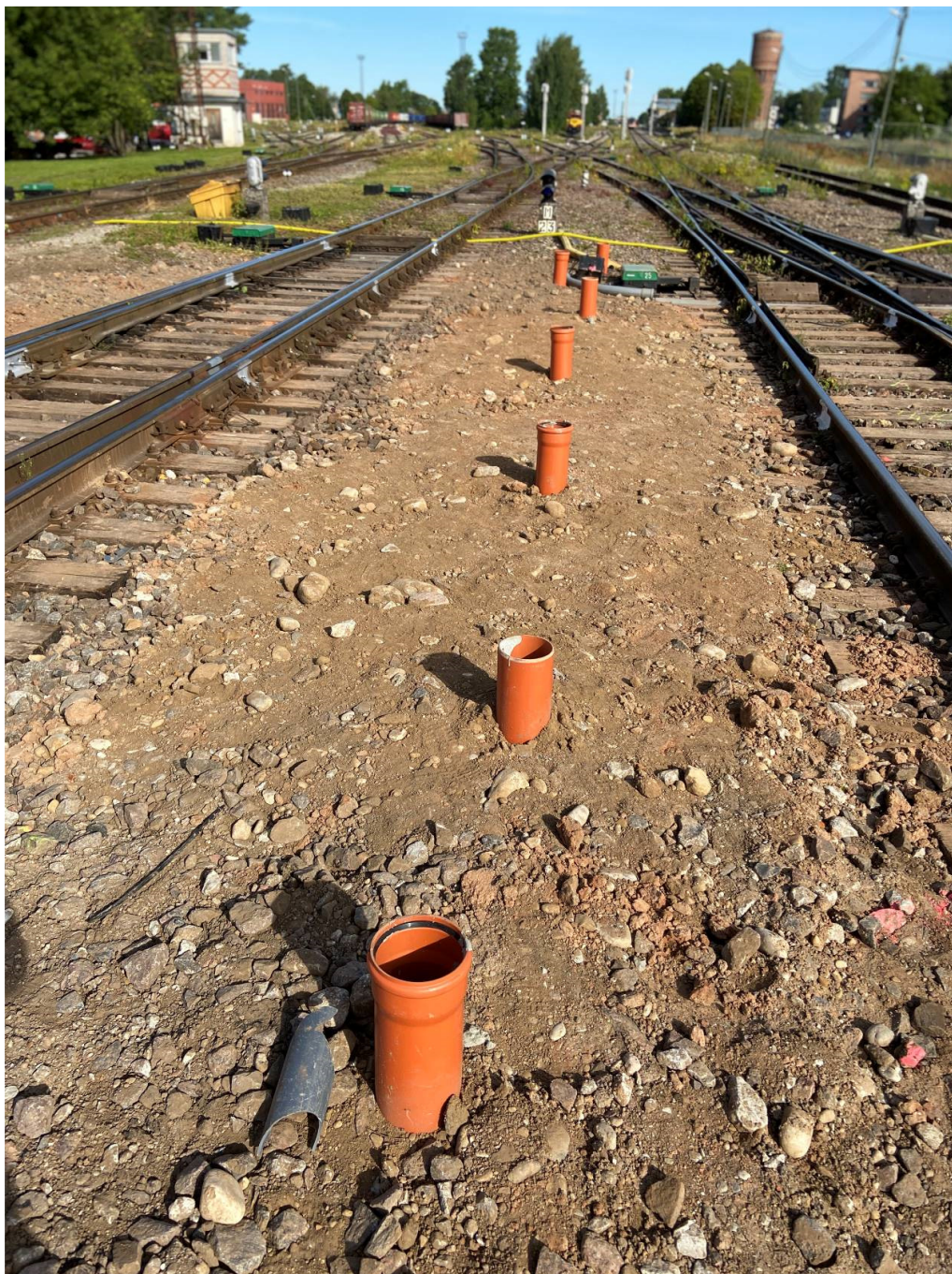
Foto 21: PVC torud rostvärgi betoneerimiseks (Foto autor: Ildar Sagetdinov)
