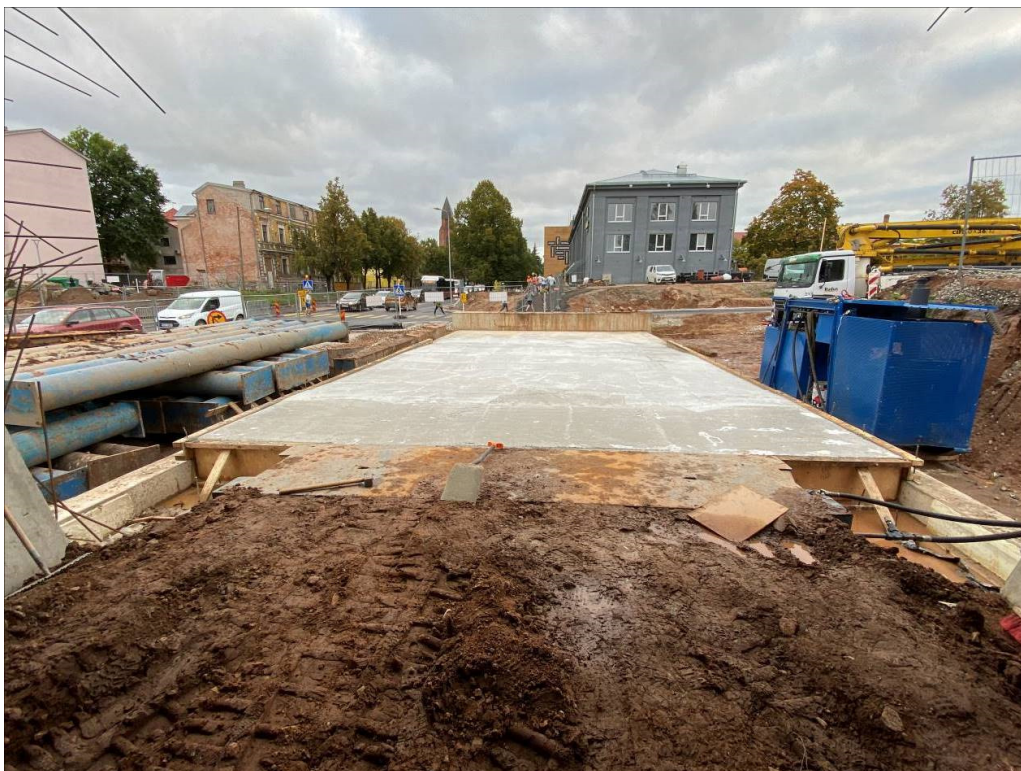
Foto 41: Betoneeritud vaheplaat (Foto autor: Ildar Sagetdinov)
