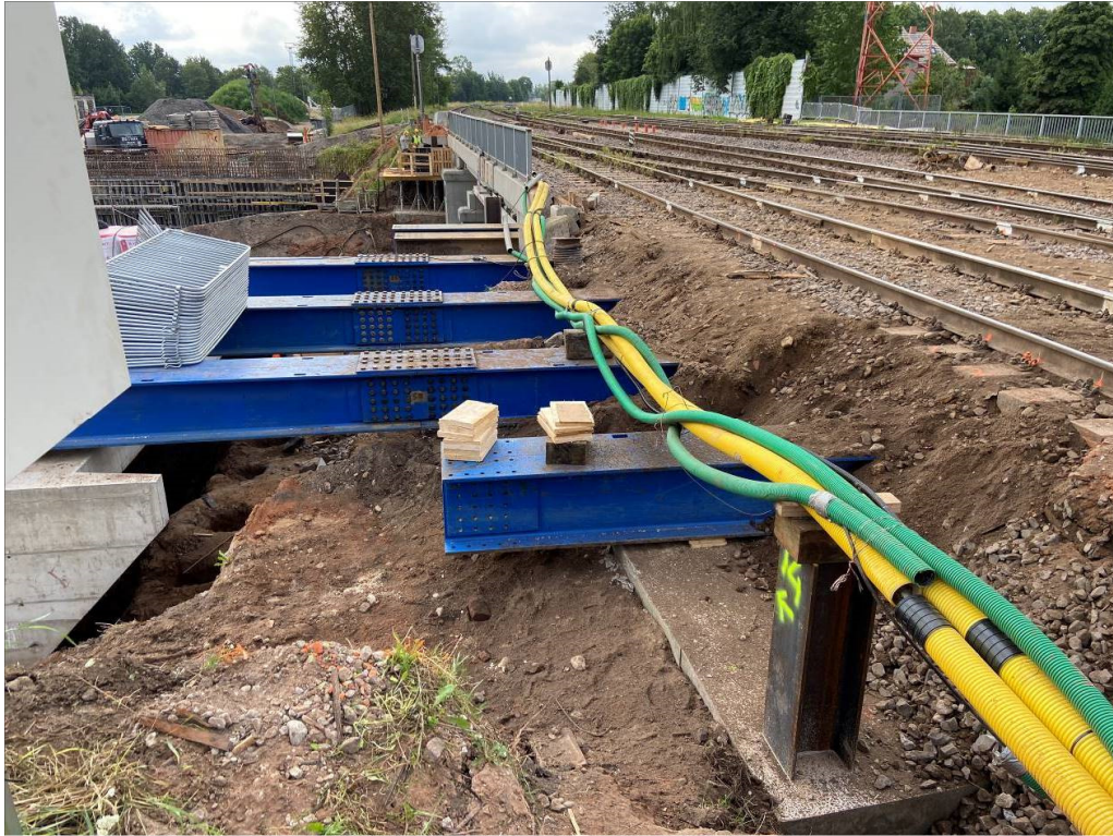
Foto 35: Ümbertõstetud raudtee kaablid (Foto autor: Ildar Sagetdinov)
