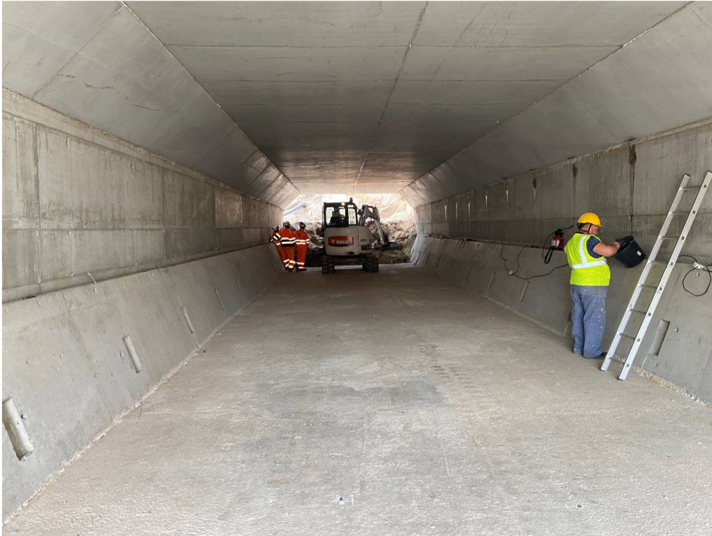
Foto 16: Tunneli vaade seestpoolt (Foto autor: Ildar Sagetdinov)
