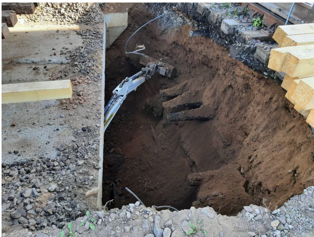
Foto 40: Tunneli kaevamise pealtvaade
