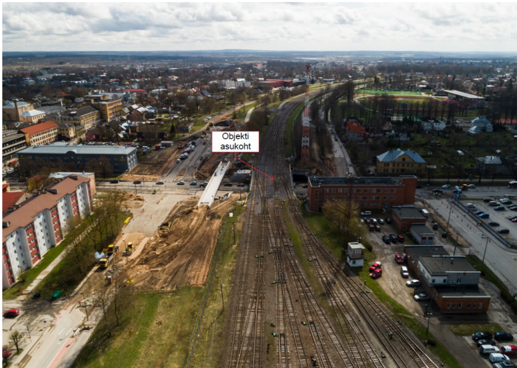
Foto 3: Rööbasteed projekti olemasoleval Riia mnt viaduktil 1 [32]
