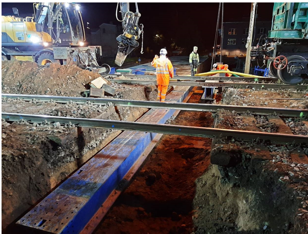
Foto 24: HEB 550 tala paigaldus (Foto autor: Ildar Sagetdinov)
