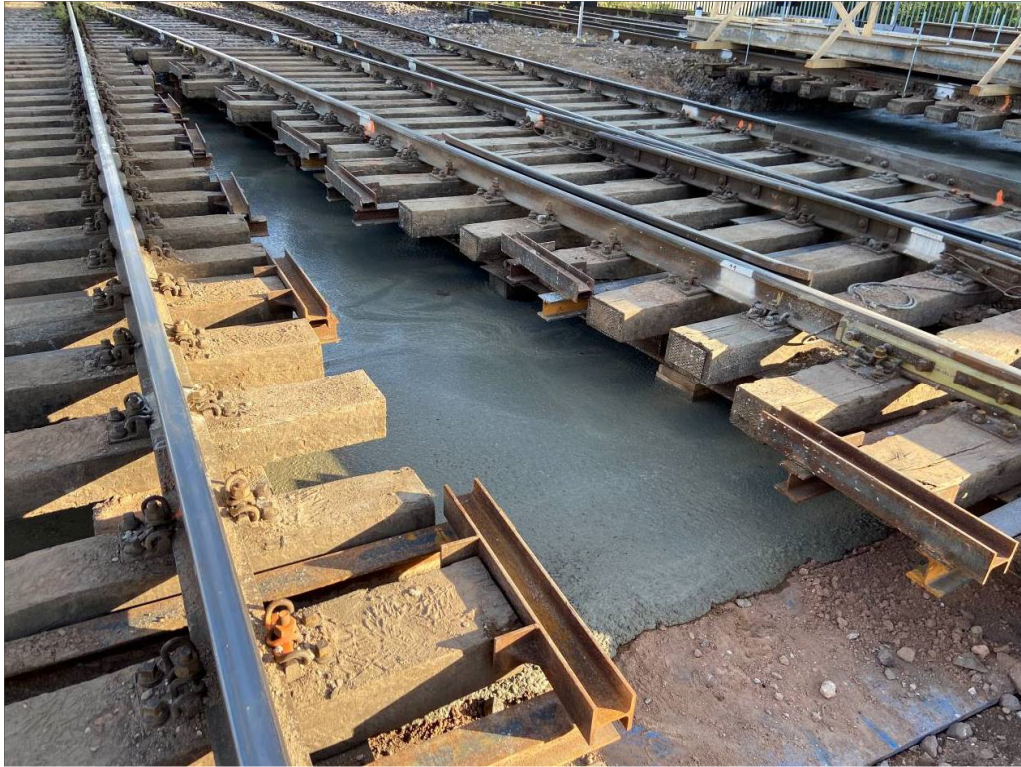
Foto 43: Tunneli pealmise osa betoon (Foto autor: Ildar Sagetdinov)
