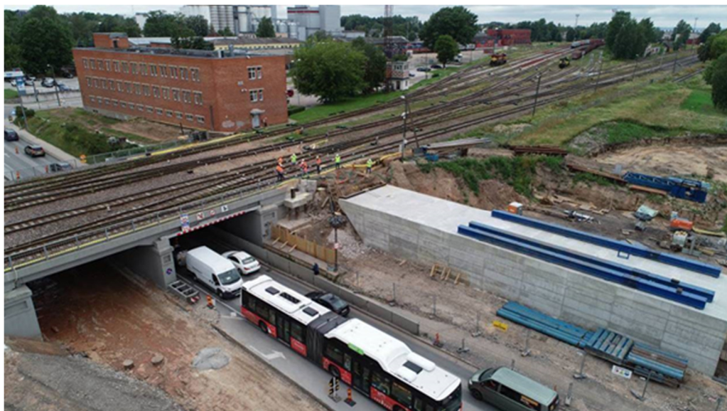
Foto 8: Tunnel T1 „North Underpass“ (põhjapoolne tunnel) [32]
