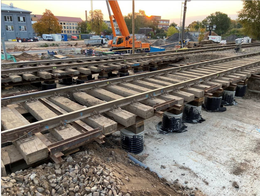
Foto 42: Betoonpostid rööbastee toetamiseks (Foto autor: Ildar Sagetdinov)
