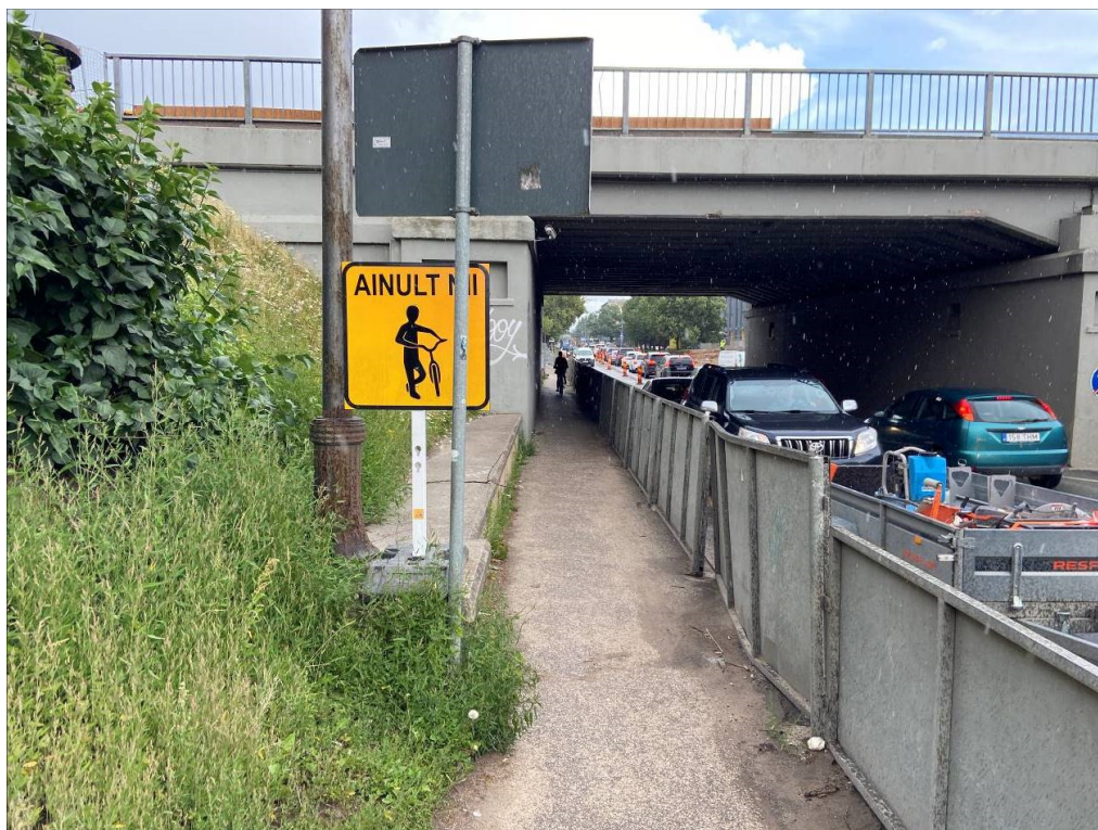
Foto 1: Riia mnt viadukti all olev kõnnitee (Foto autor: Ildar Sagetdinov)
