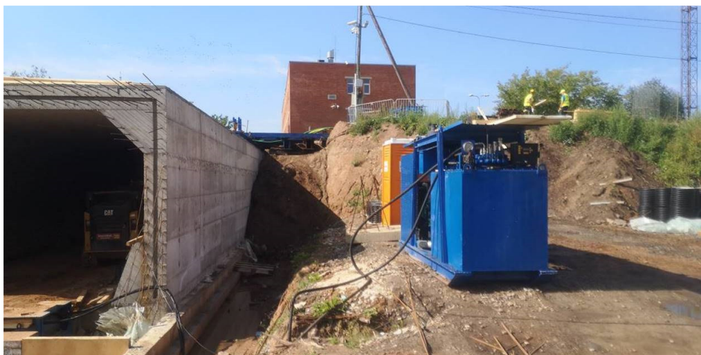
Foto 34: Toiteplokk ja hüdrauliline pump (Foto autor: Ildar Sagetdinov)
