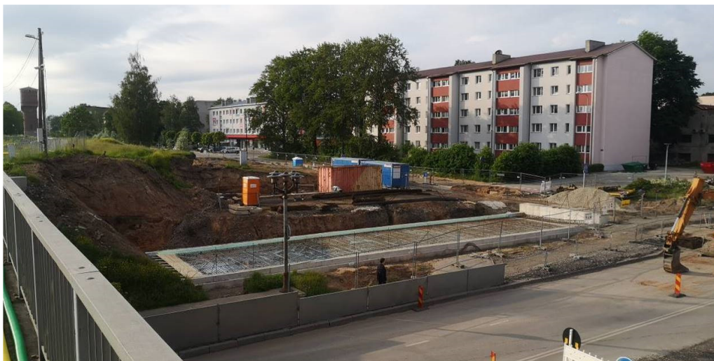
Foto 11: Tunneli alusplaat ja tõukekand (Foto autor: Ildar Sagetdinov)
