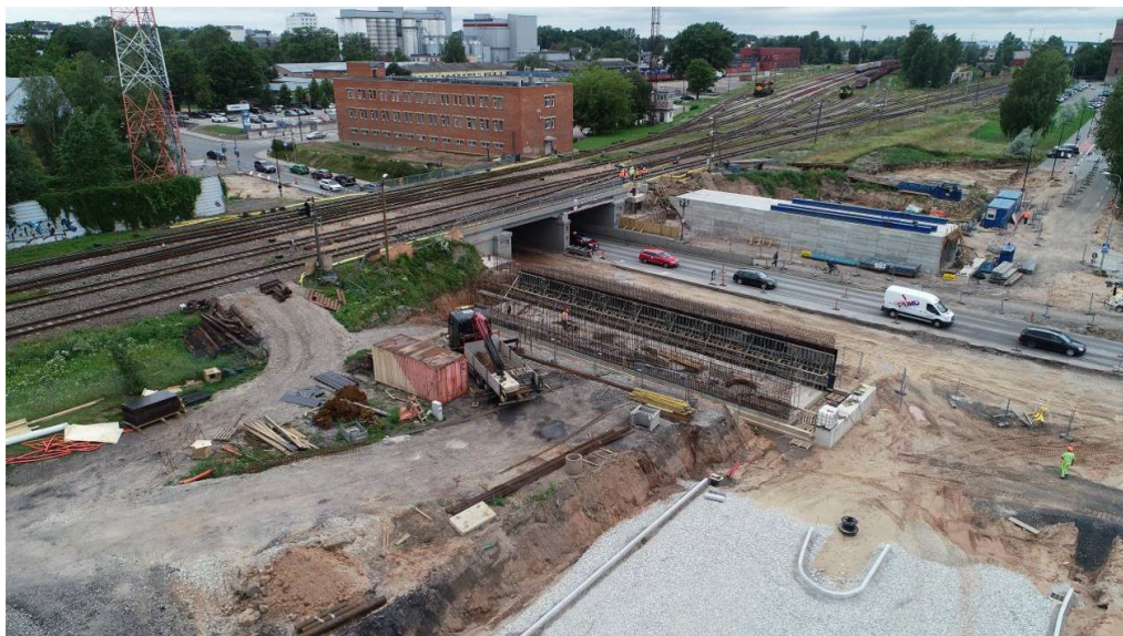
Foto 10: Tunnelite asetus raudtee muldkeha kõrval [32]
