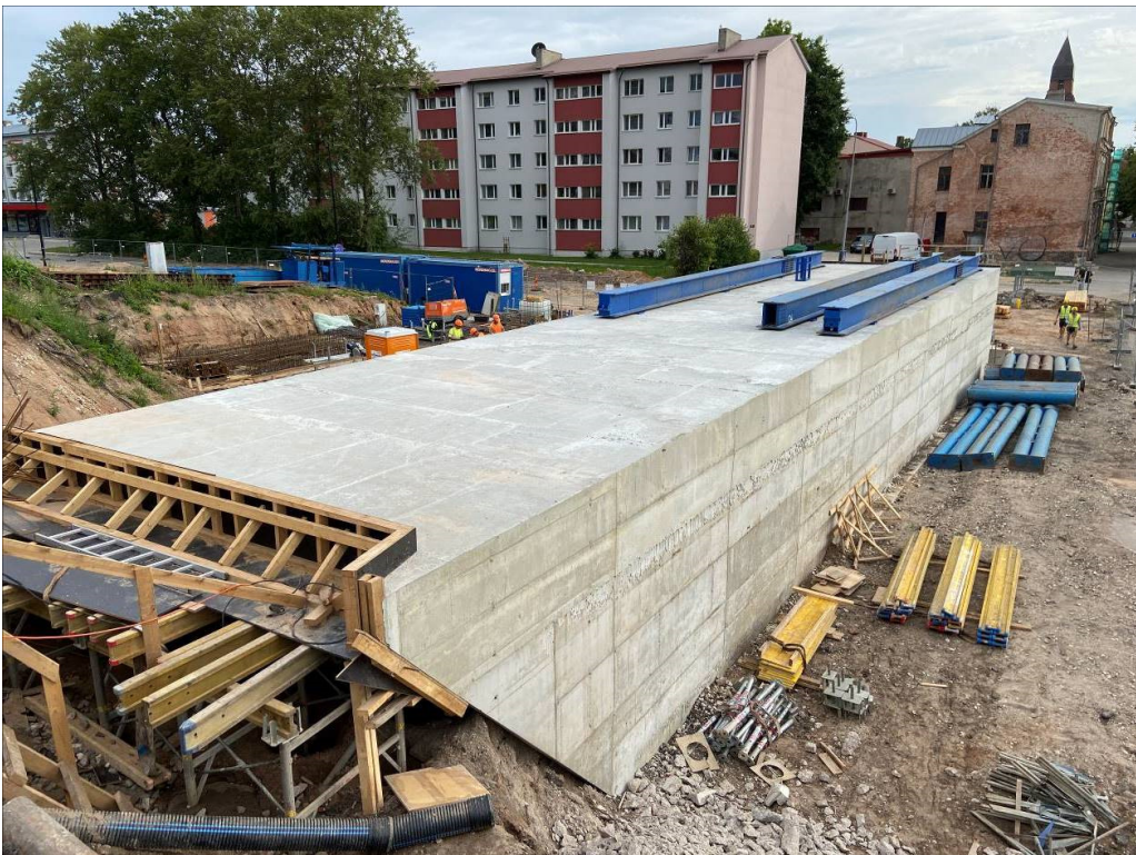
Foto 9: Lükatava tunneli esiots (Foto autor: Ildar Sagetdinov)
