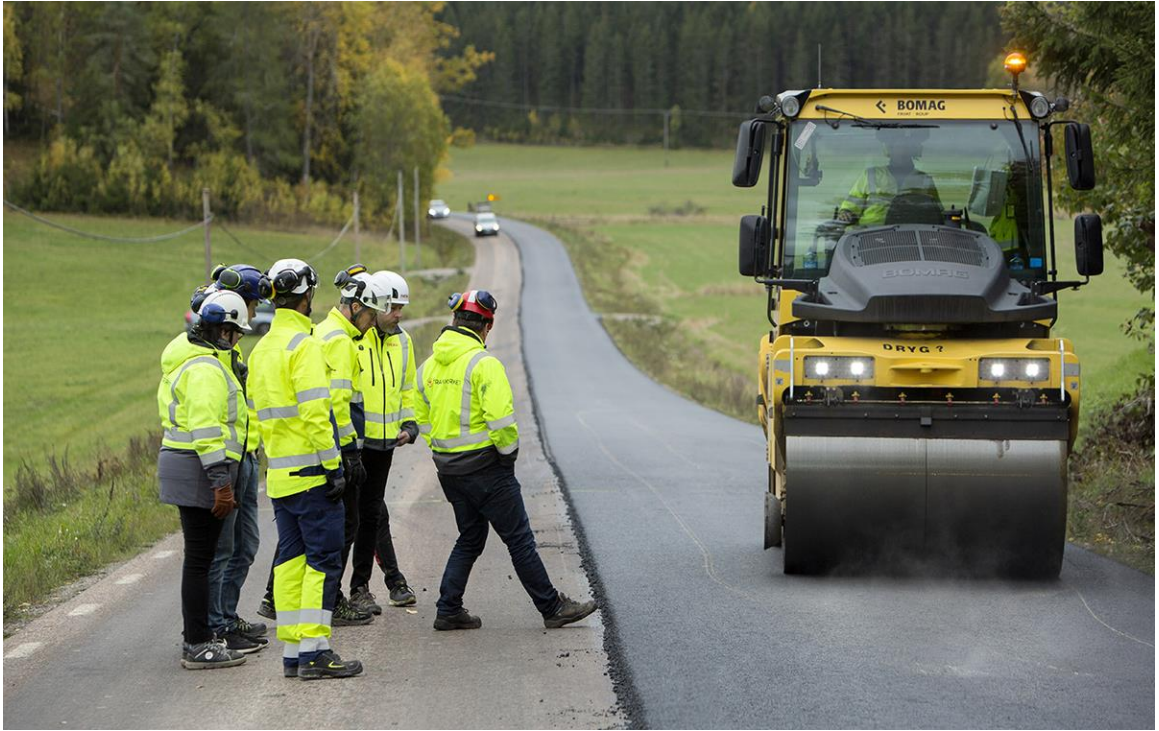
Foto 3.5 Tee 224 ligniini sisaldava asfaldi paigaldamine [Svevia]
