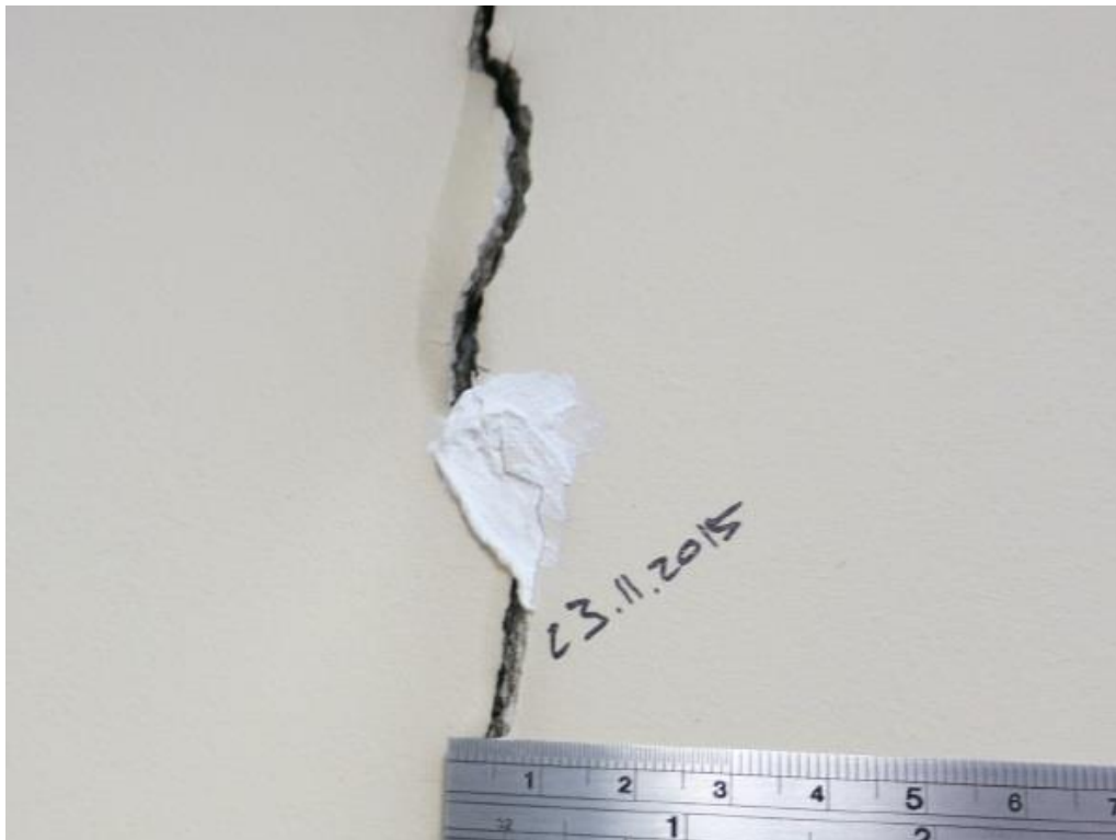
Joonis 12. Kaitseliidu Peastaabi B-korpuse 1. korruse seinal tekkinud pragu, millele paigaldati 23.11.2015. aastal kipsmajakas. Foto on tehtud 16.03.2016. aasta toimunud paikvaatlusel. Kipsmajakas on purunenud. (Kase 2016)
