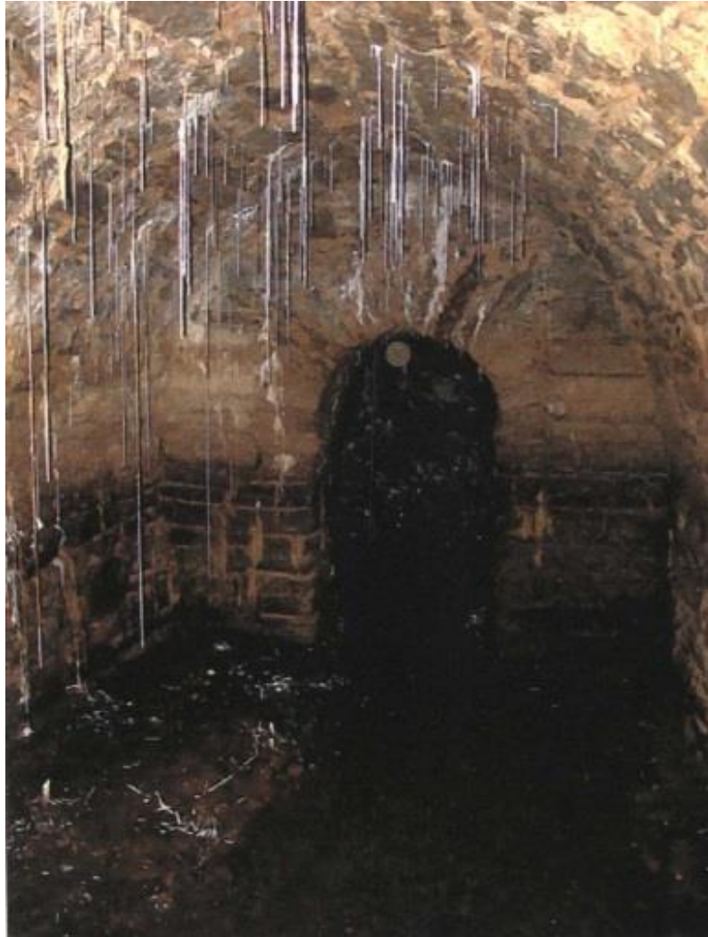
Joonis 26. Fotel on näha 2003. aastal avatud Wismari raveliini seinas tumedam vöönd, mis viitab ajutise veetaseme piirile. Lisaks on laes jälgitavad ka stalaktiidid. (Uuetalu 2003)
