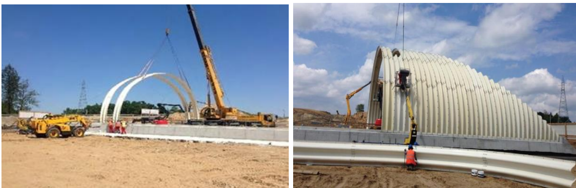
Foto. 3.9 ja 3.10 Kaks sisemist ringi vundamendil ja lõigatud otsaga konstruktsioon [14]
