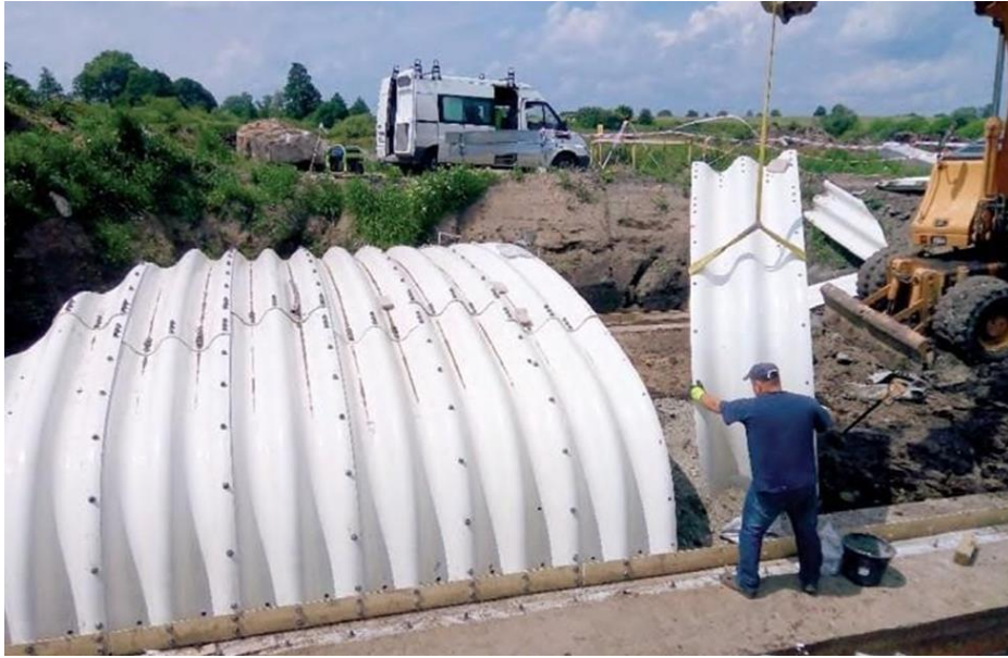
Foto 3.8. Plaadi paigaldamine vundamendile
