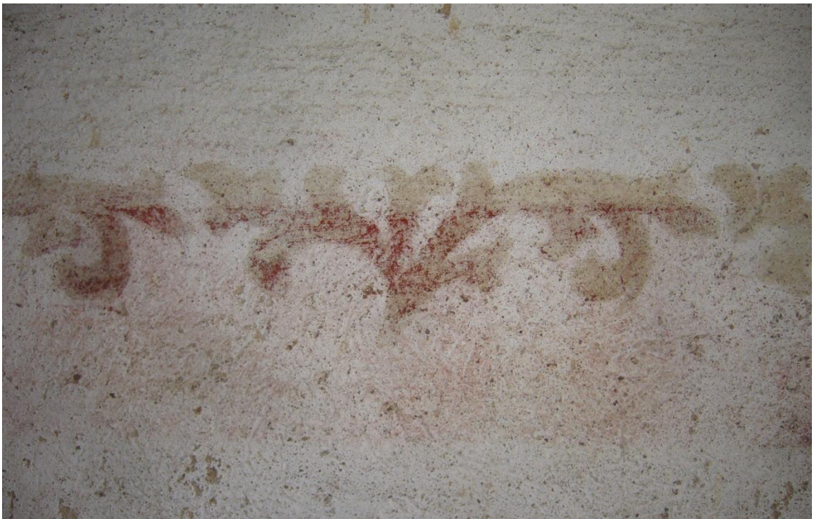
Foto 62. Kaguseinal on sinise ornamendiriba kohal säilinud jäljed, tõenäoliselt metallipuru sisaldavast õlivärvist. (Foto: autor, 13.05.2015)
