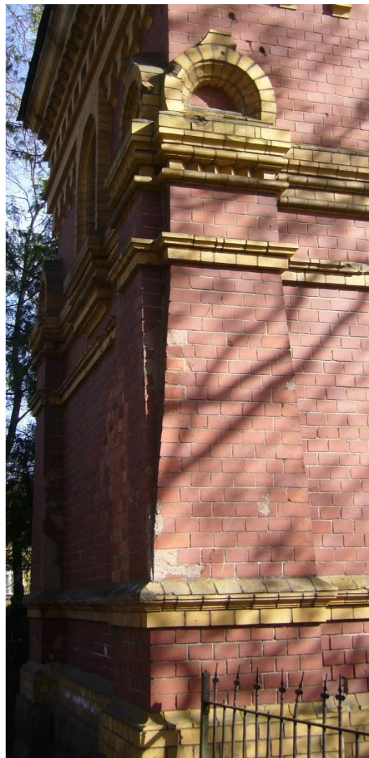
Foto 13. Põhjapoolse nurga eenduvad osad. (Foto: autor, 04.05.2015)
