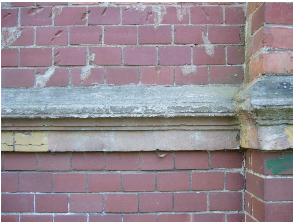
Foto 39. Pärast II maailmasõda tehtud parandused kirdepoolsel fassaadil. (Foto: autor, 04.05.2015)
