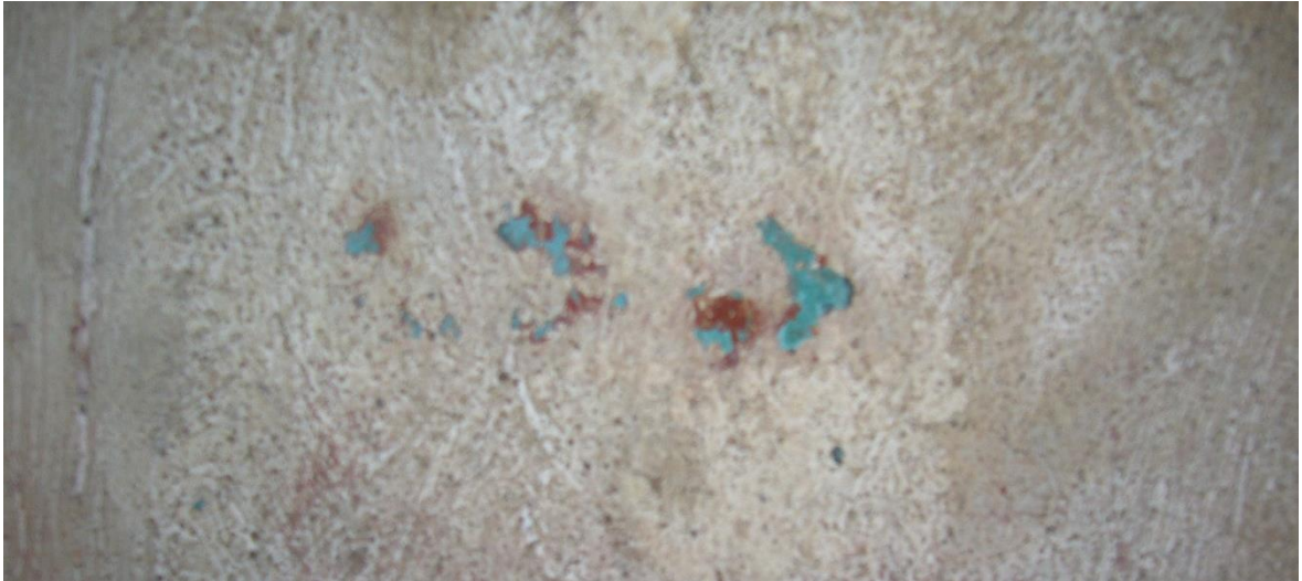
Foto 61. Edelaseinal sinise ornamendiriba kohal on jäljed, mis viitavad võimalikule metallipuru sisaldusele ornamente kaunistavas värvis. (Foto: autor, 13.05.2015)
