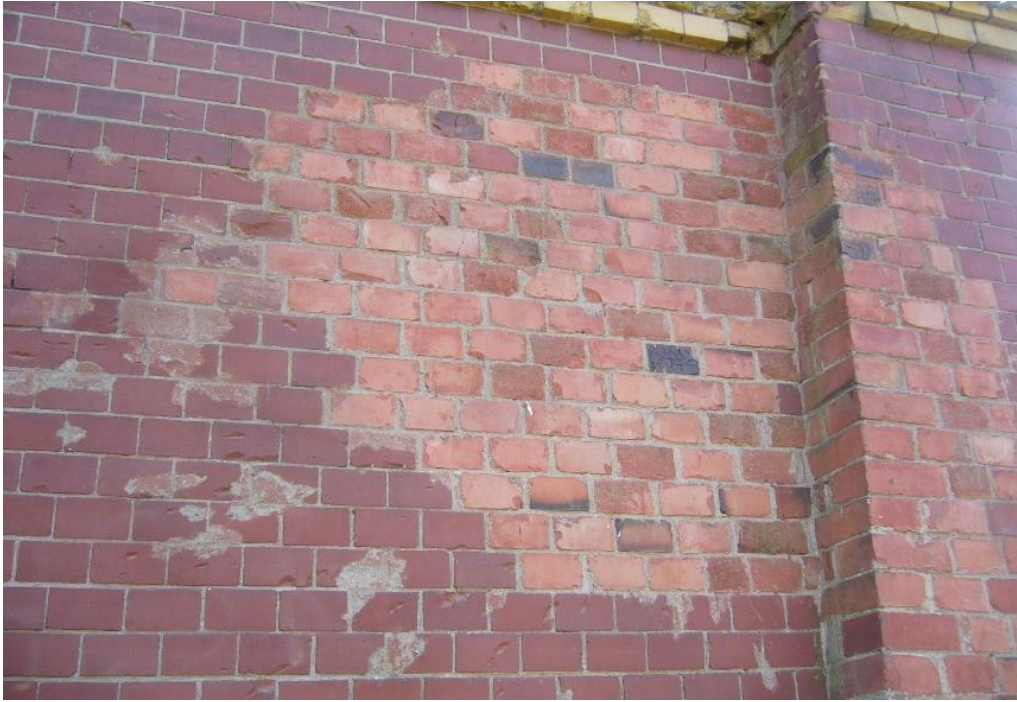
Foto 39. Pärast II maailmasõda tehtud parandused kirdepoolsel fassaadil. (Foto: autor, 04.05.2015)
