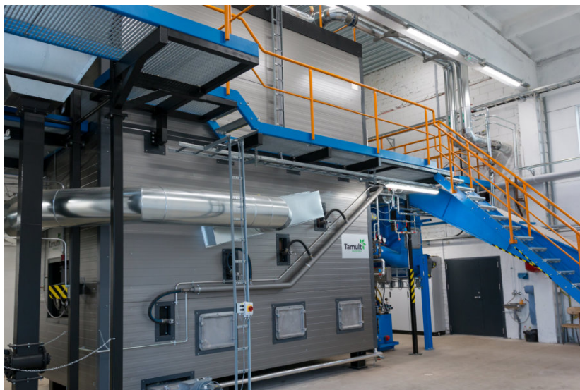
Joonis 5.7 Adven Eesti AS käitatav 2,5 MW puiduhakke katlamaja Viljandimaal. Foto: AS Rakvere Farmid
