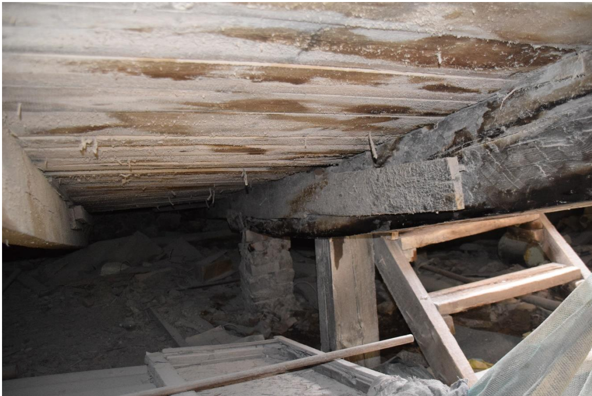
Foto 28. Purunenud ja tugevdatud sarikas vintskapi kõrval.
