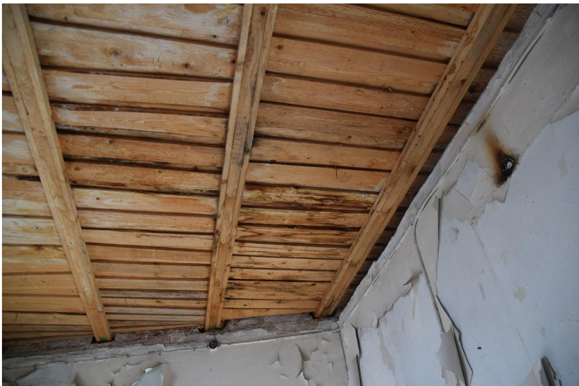
Foto 185. Ajutine uus puitvahelagi, mis on kahjustuse tunnustega.
