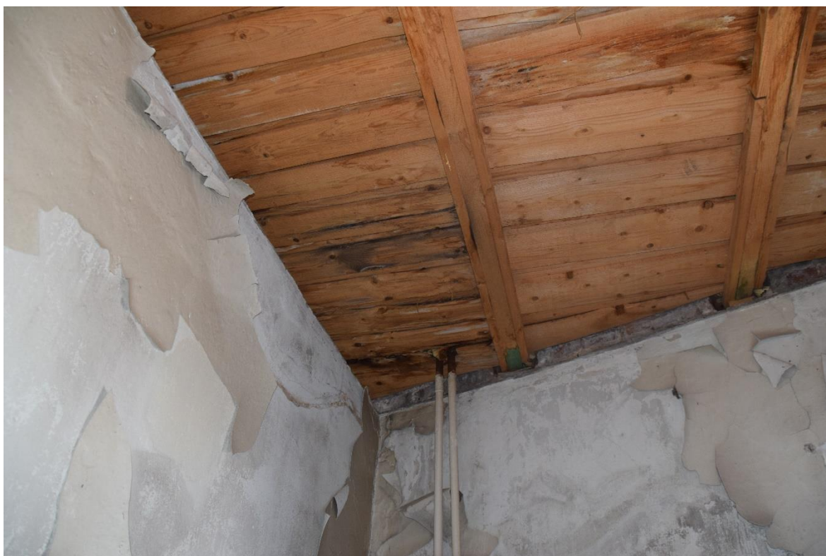
Foto 186. Ajutine uus puitvahelagi, mis on kahjustuse tunnustega.
