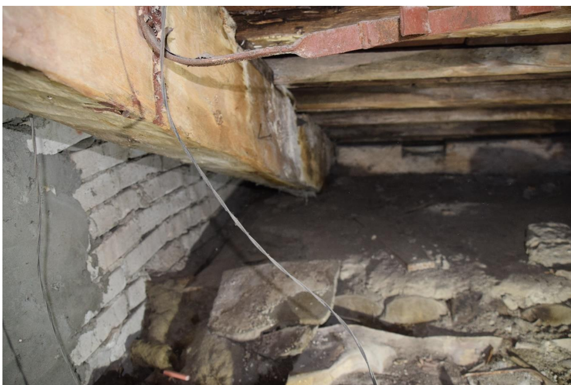
Foto 141. Sarikas trepikoja kohal. Näeb halb välja, kuid tugev. Puurimised 69K ja 70K.
