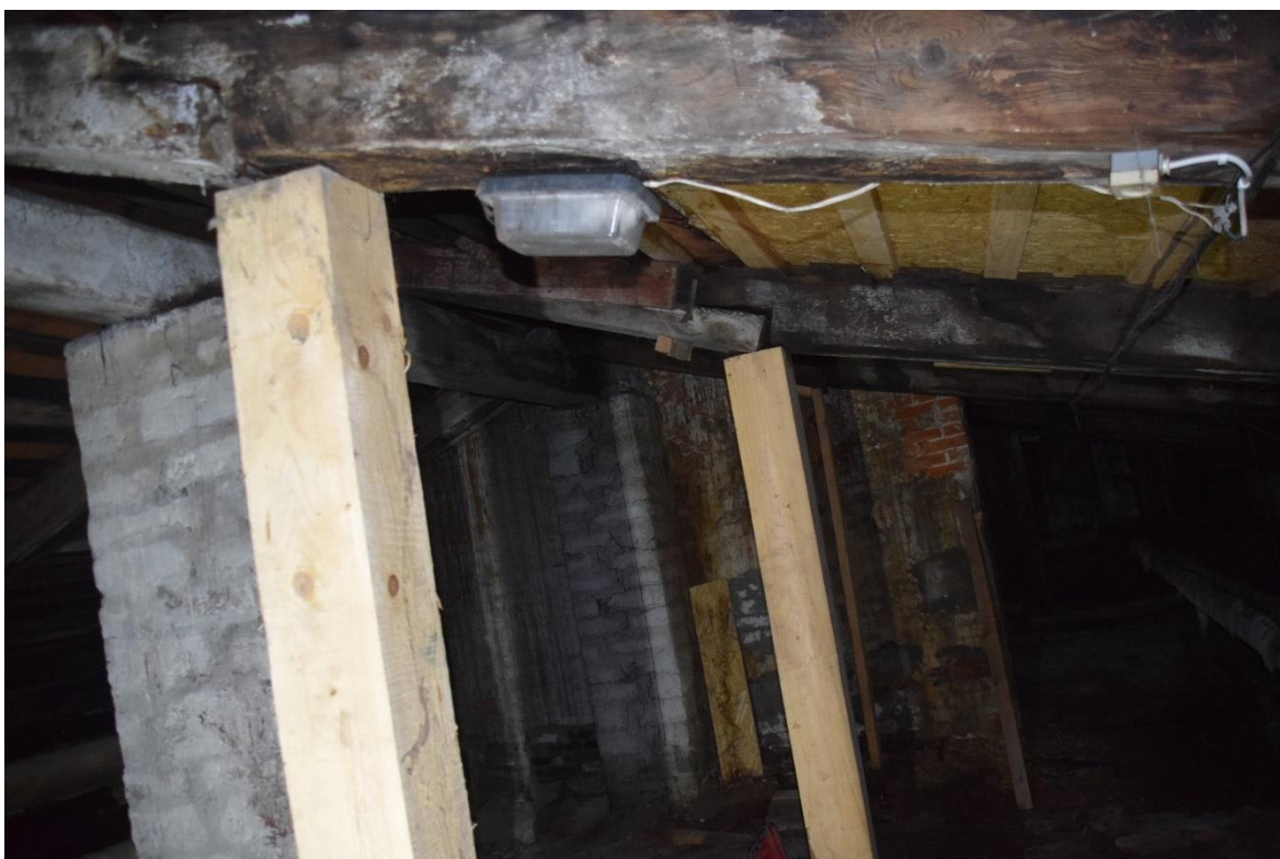
Foto 57. Toestaud sarikad ruumi 3098 kohal. Jätkukohad on deformeerunud.
