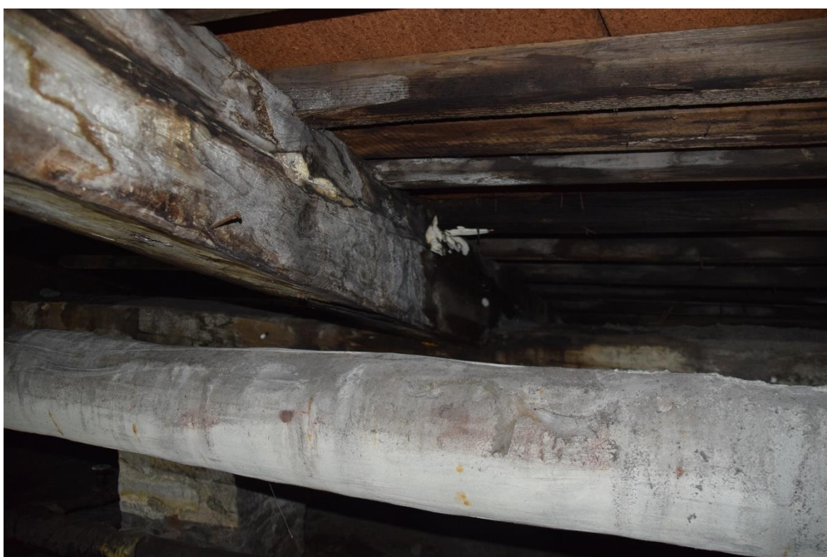
Foto 43. Tugeva seenkahjustusega sarikas. Proovi P8 võtukoht.
