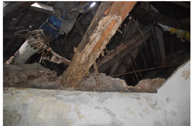
Joonis 7.2013 Proovi P35 võtukoht, majavammi kahjustusega tala (autorifoto)
