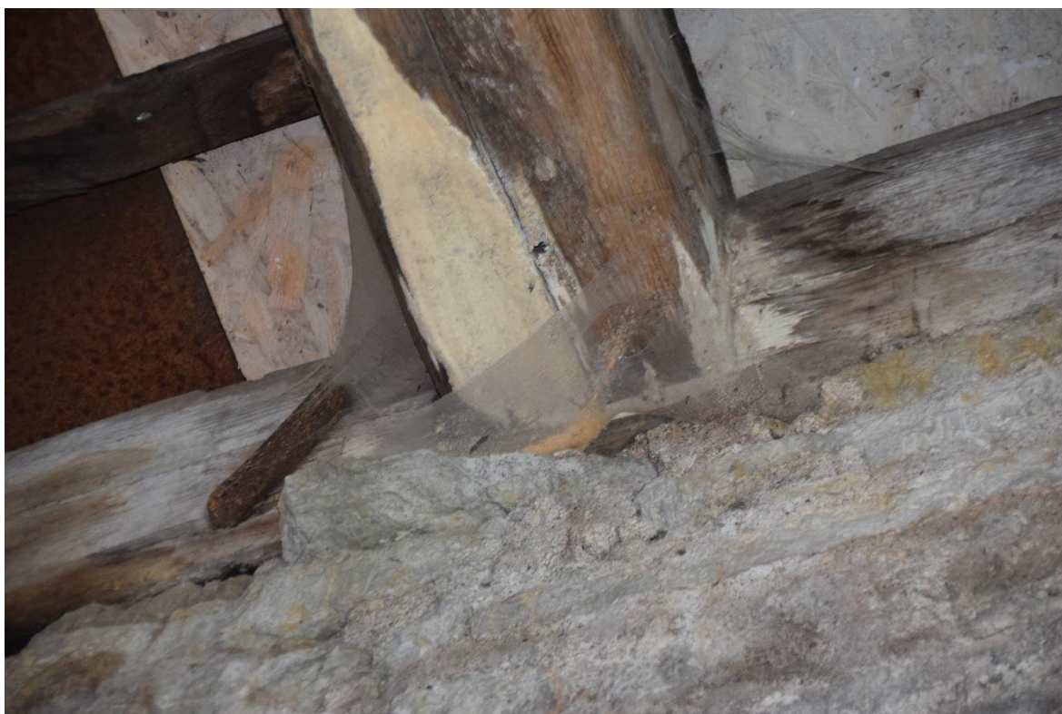
Foto 130. Tugevdatav sarikaots. Proovi P22 võtukoht ja resistograafi puurimine 57.
