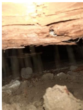
Joonis 7.15 Purunenud vahelaetala ruumi 3241 kohal (autorifoto)
