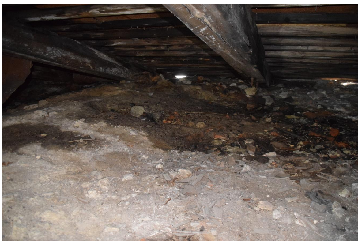
Foto 15. Kahjustatud sarikaotsad ja müürlatt ruumi 3005 kohal. Proovi P3 võtukoht.
