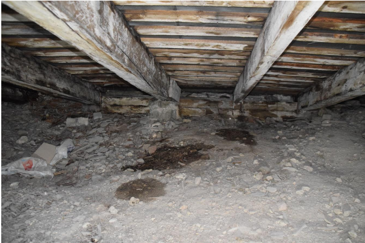
Foto 24. Märgunud piirkond ja tugevdatud sarikaotsad ruumi 3014 kohal.
