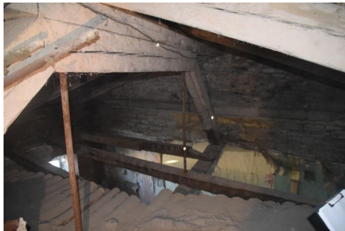
Joonis 7.11 Lünetitiibade puitsõrestik (autorifoto)
