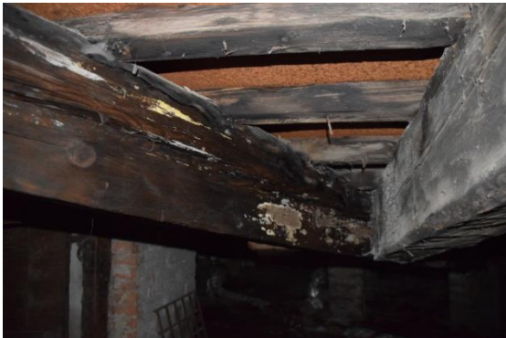
Joonis 4 Kahjustunud sarikas, proovi P5 võtukoht (autorifoto)
