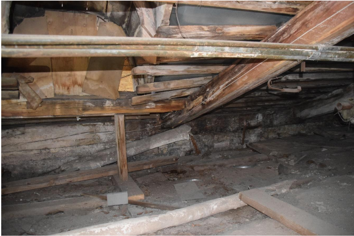
Foto 94. Asendatav sarikas uugi kõrval. Proovi P19 võtukoht ja puurimised 47 ja 48.
