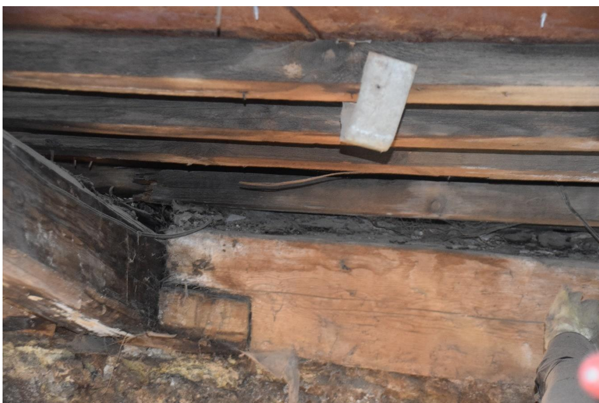
Foto 157. Proteesitav sarikaots. Resistograafi puurimine 80.
