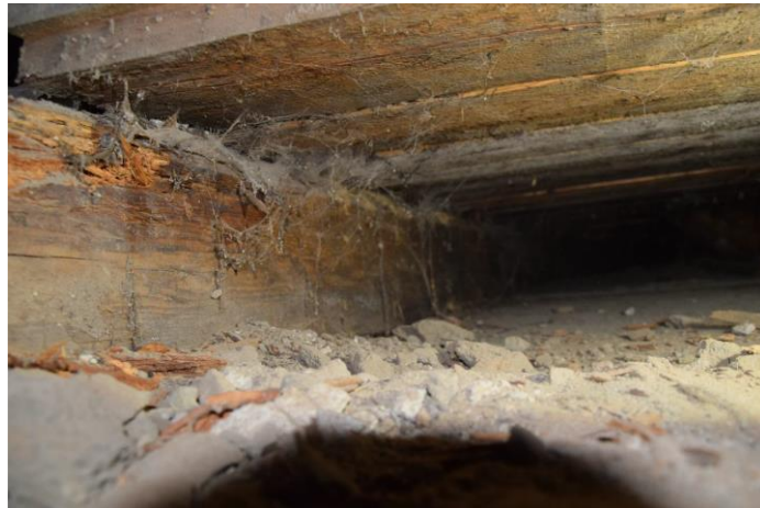
Joonis 9 Vaade vahelaekihtide vahel olevale putukakahjustusele (autorifoto)
