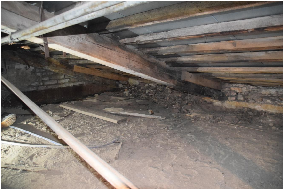
Foto 92. Sarikas ruumi 3183 kohal. Resistograafi puurimine 45.
