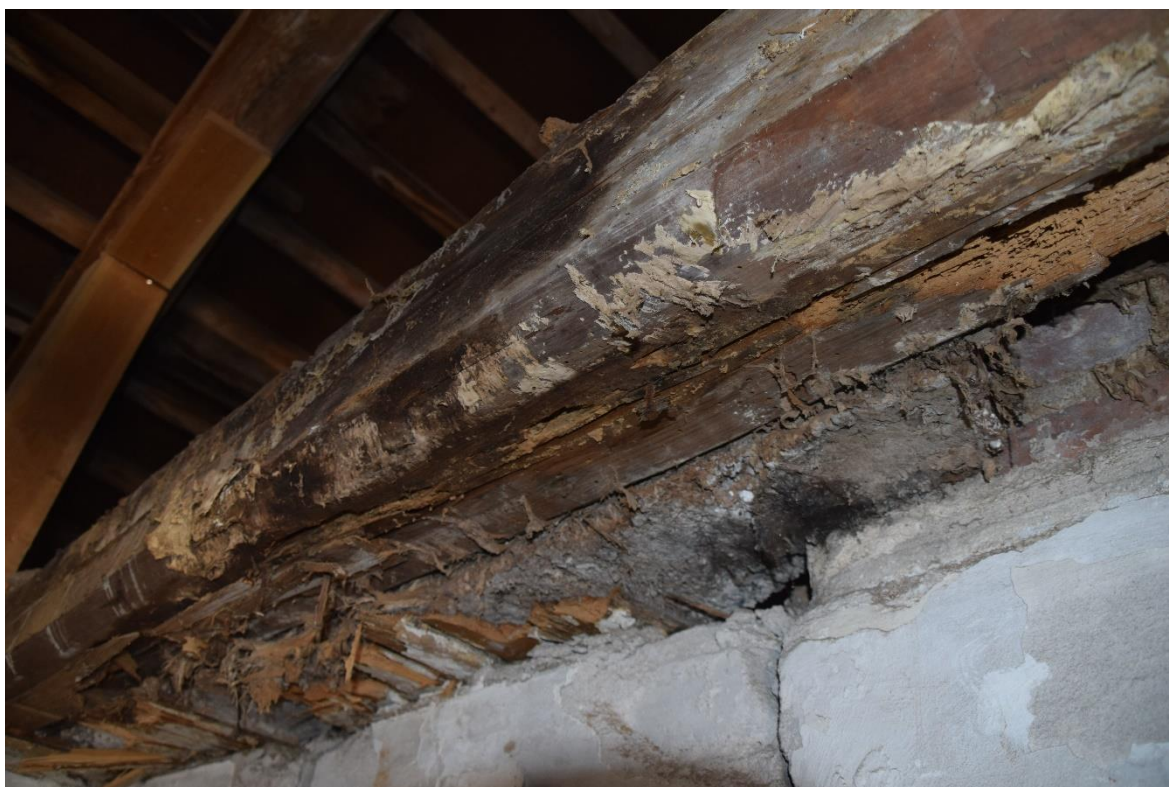
Foto 180. Eelmisel fotol toodud majavammi kahjustusega tala lähivaates. Proov P31.
