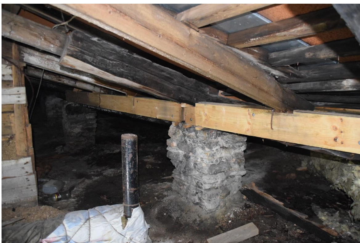
Foto 9. Asendatud sarikad ja tugevdatud toolvark ruumi 3004-3005 vaheseina kohal.
