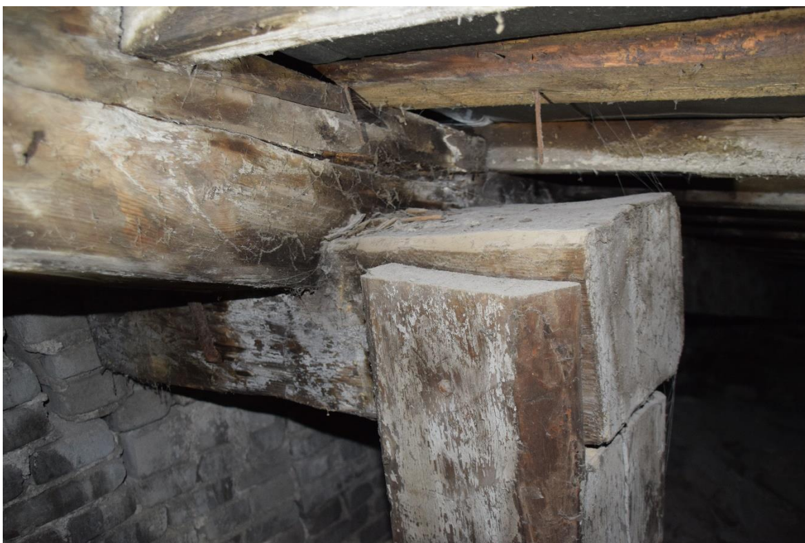
Foto 29. Kahjustatud sarikas ja toolvärgi vöö ots trepikoja kõrval.
