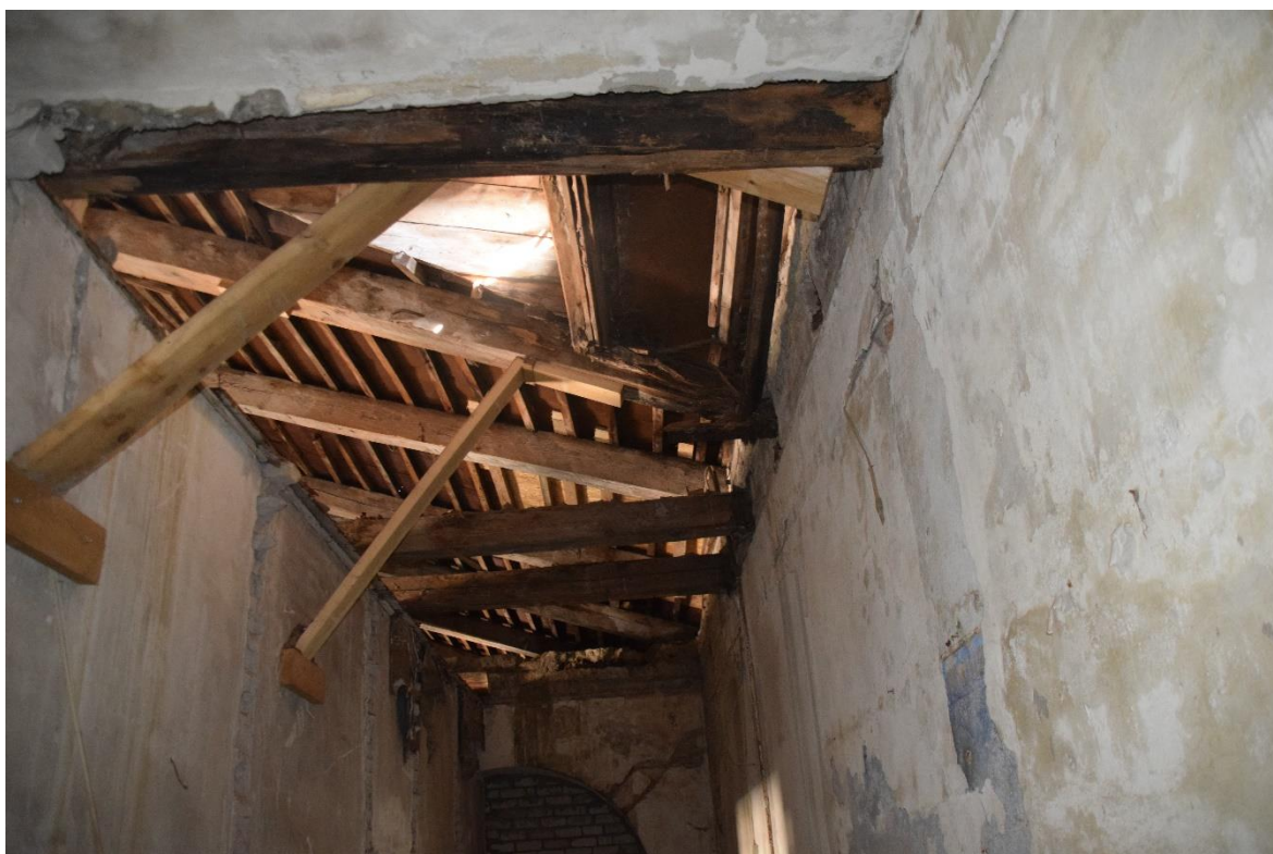
Foto 178. Purunenud ja toestatud vahelae talad ruumi 3199 kohal.
