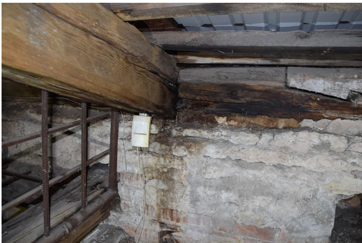
Foto 136. Proteesitav sarikaots ruumi 3227 kohal. Resistograafi puurimine 65.
