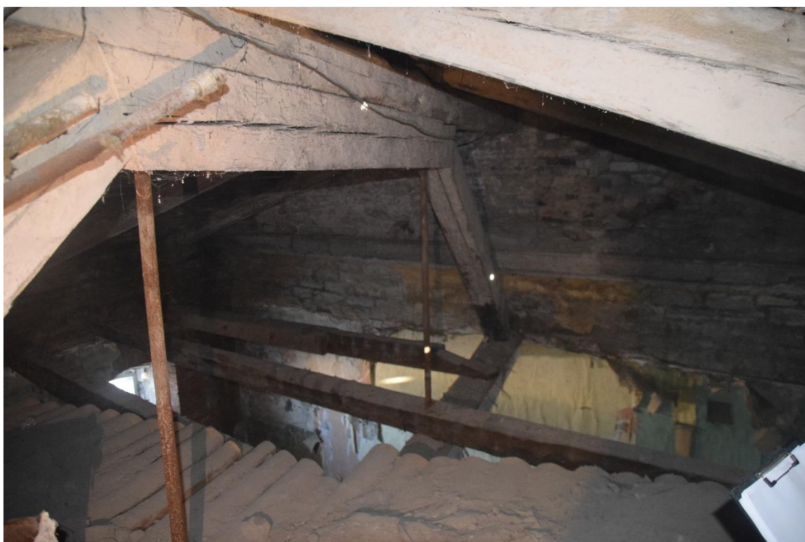
Foto 77. Katusesõrestik Lüneti tiibade katuse keskosas ruumi 3022 kohal.
