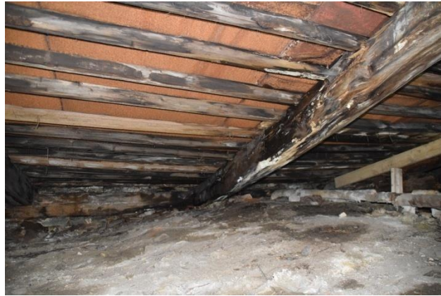
Joonis 6 Korgikute viljakeha sarikal ruumi 3085 kohal, proovi P10 võtukoht (autorifoto)
