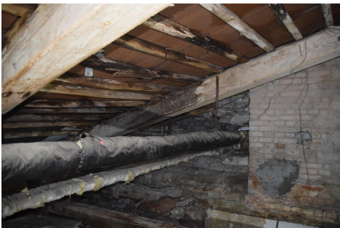
Foto 137. Proteesitav sarikas ruumi 3233 kohal. Resistograafi puurimine 68.
