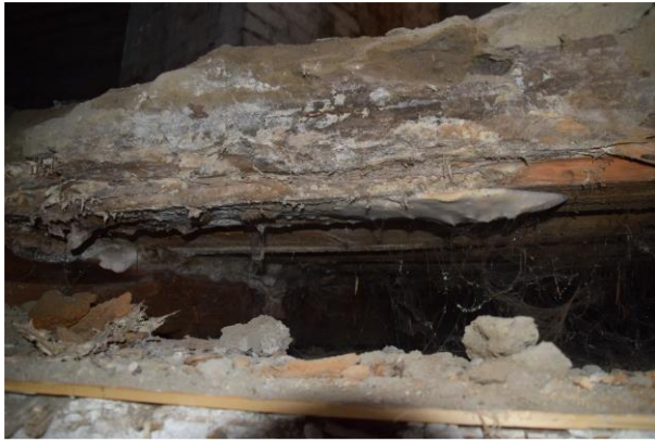
Joonis 7.17 Majvammi seeneniidistik vahelae laudisel ruumi 3023 kohal, proov P27 (autorifoto)
