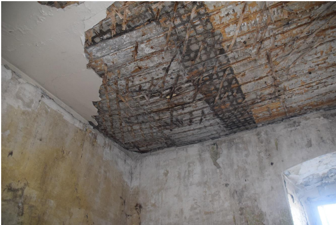
Foto 174. Korgiku kahjustusega lagi ruumis 3186. Talasid pole näha, kuid need on kahjustatud. Proovi P29 võtukoht.
