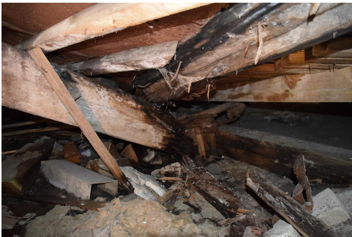
Foto 106. Purunenud ja proteesitavad sarikad uugi kõrval ruumi 3200 kohal. Proov P21.
