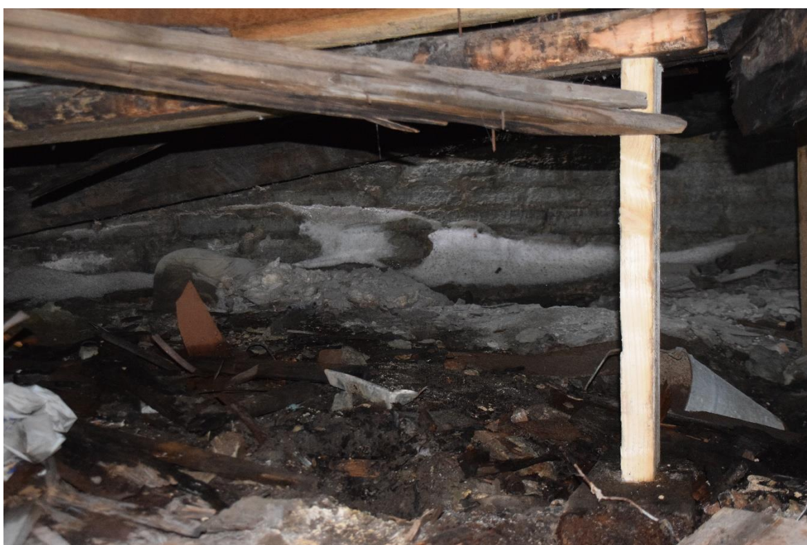
Foto 37. Lumi ja purunenud müürlatt ruumi 3066 kohal.
