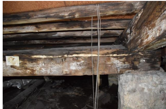
Joonis 7.5 Kahjustunud sarikas ja toolvärk, kohast võetud proov P6 (autorifoto)
