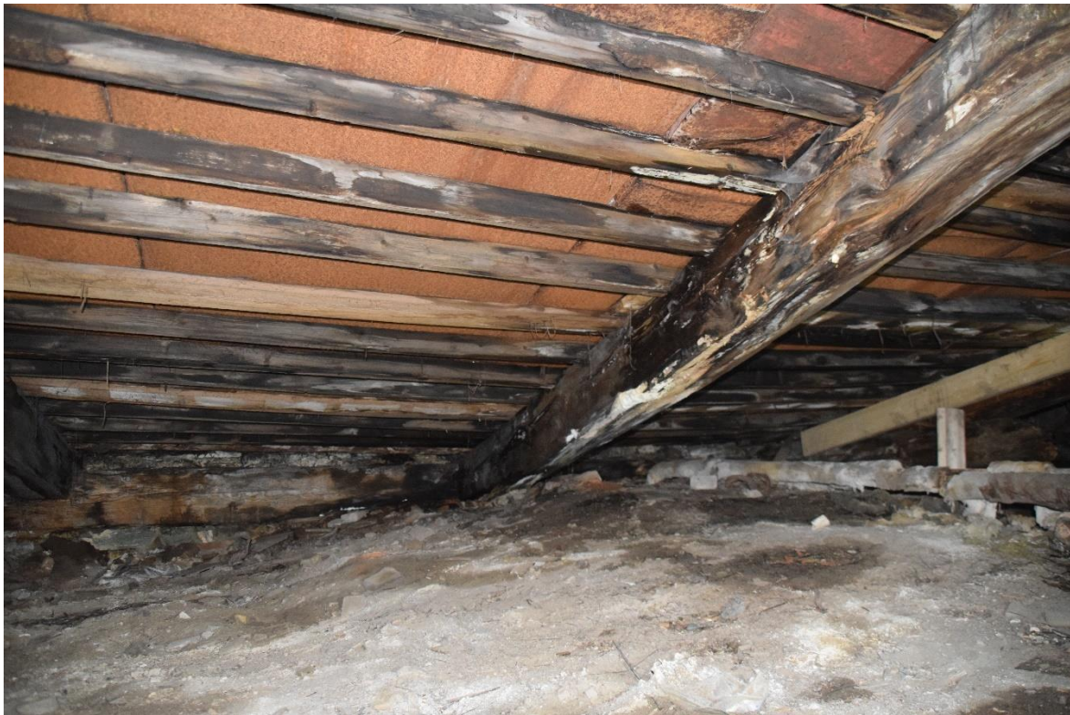
Foto 48. Tugeva kahjustusega sarikas uugi kõrval ruumi 3085 kohal. Proovi P10 võtukoht.
