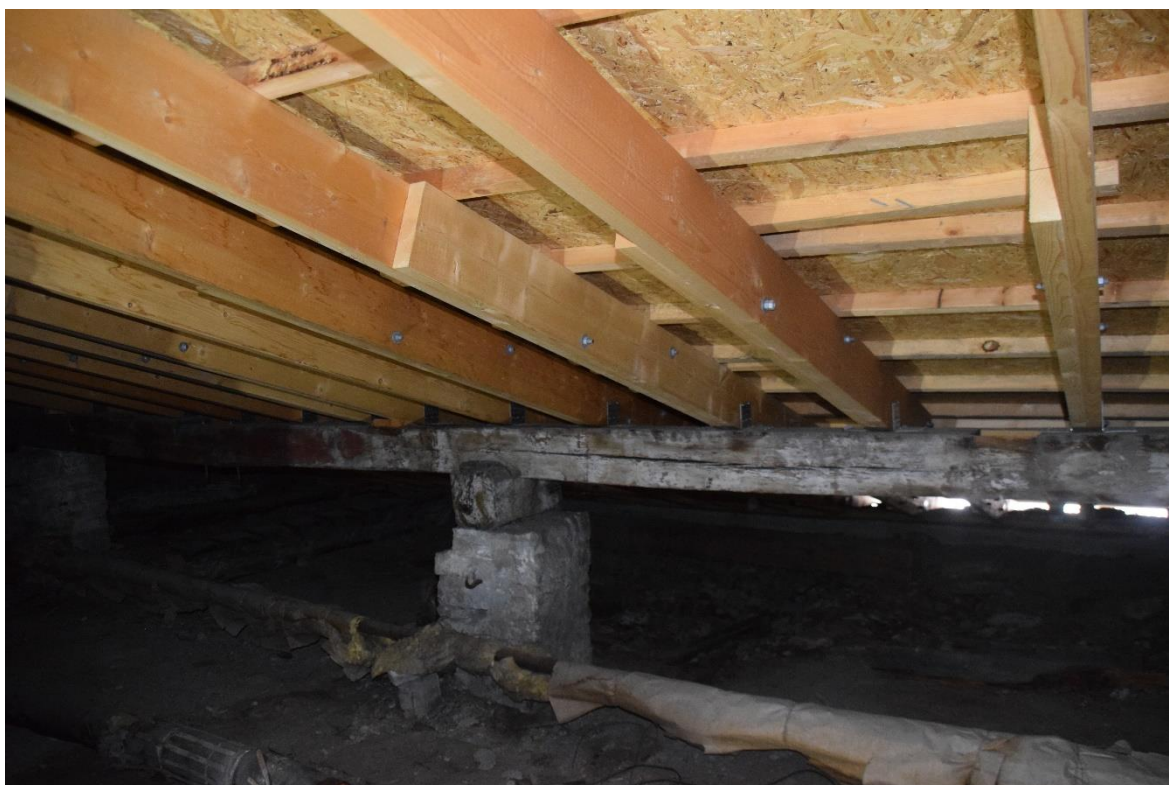
Foto 30. Asendatud katus ruumi 3048 kohal. Säilinud toolvärgi vöö.
