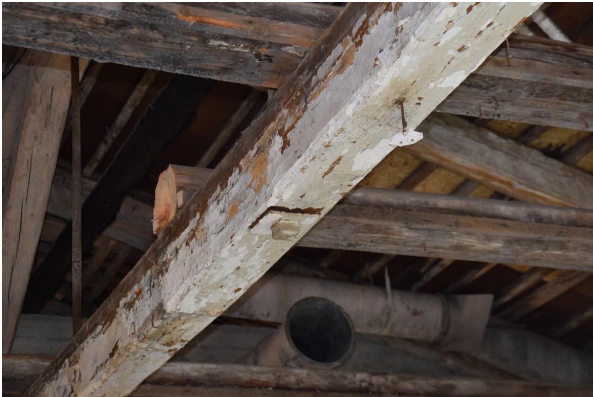
Foto 188. Piki ruumi 3220 paiknev sõrestik, mis on koormuse eemaldamisel tõusnud ülespoole.
