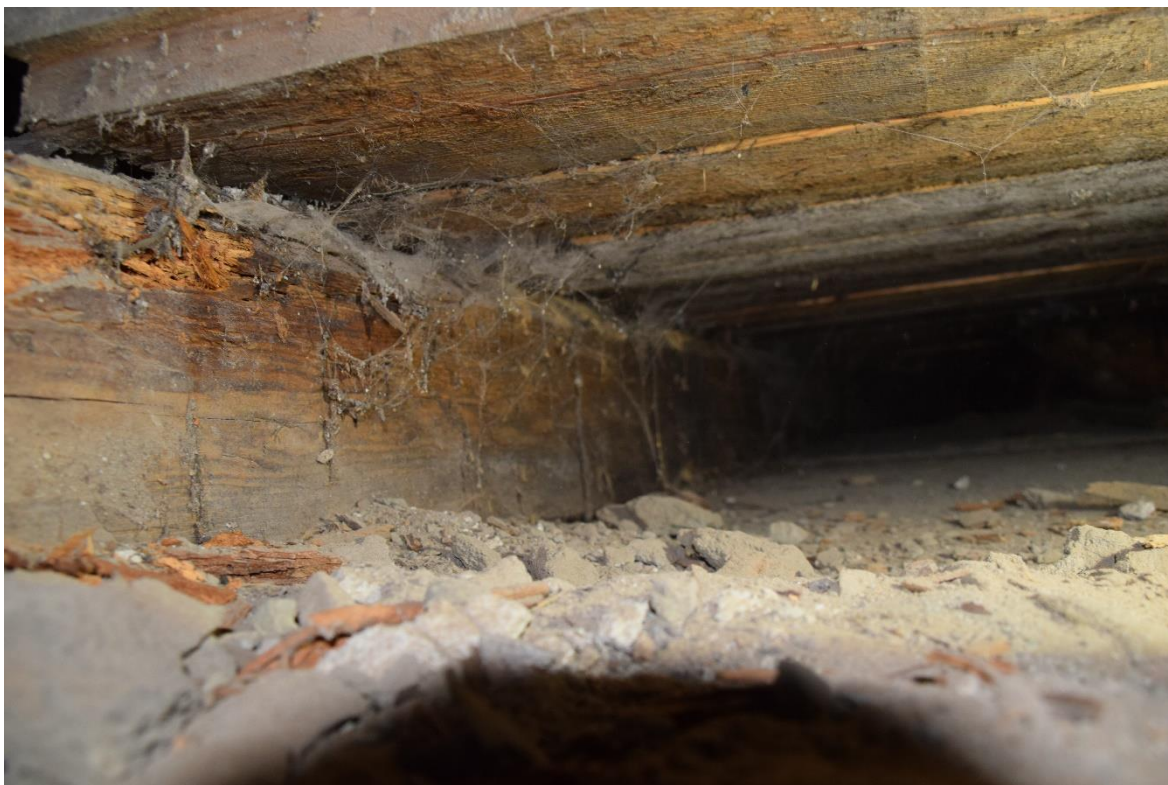
Foto 168. Vaade vahelae kihtide vahele. Näha kogu vahelae ulatuses tugevat putukakahjustust.
