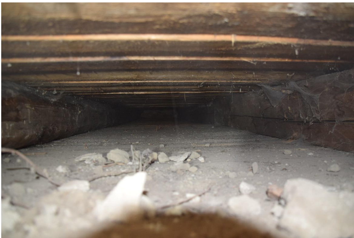
Foto 169. Vaade vahelae kihtide vahele. Putukakahjustuse tunnused.
