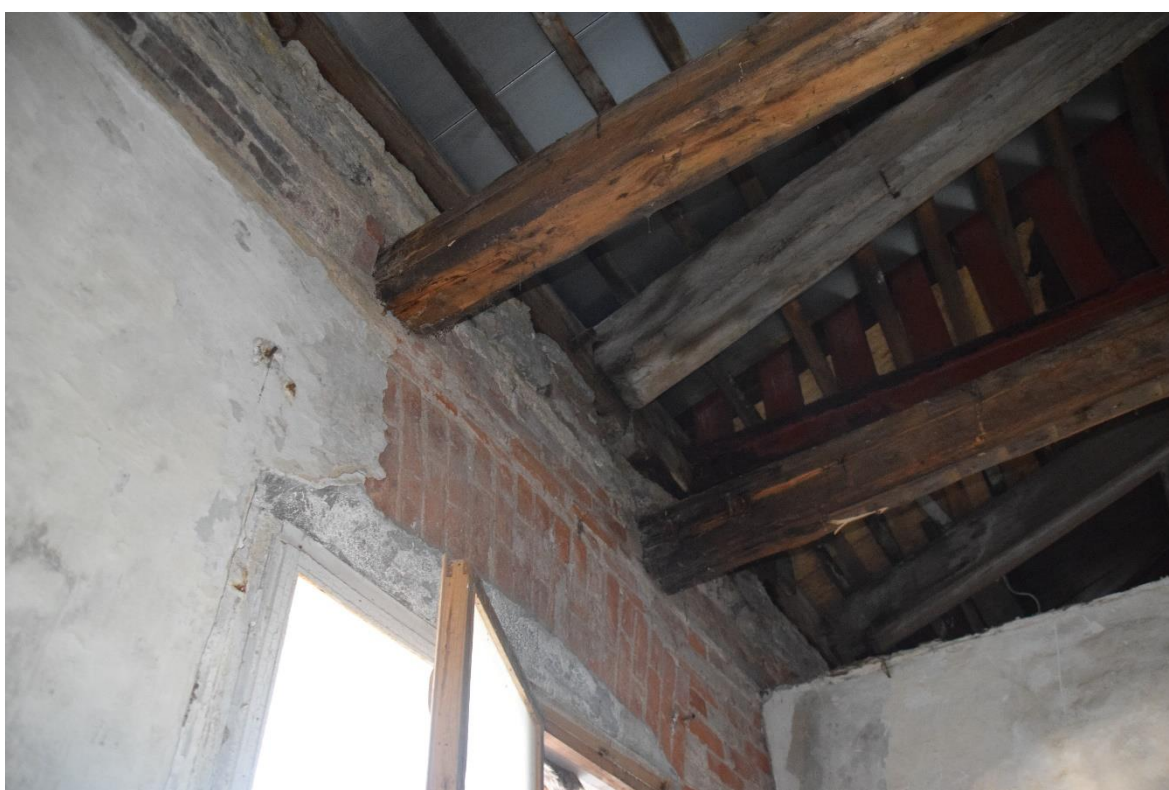
Foto 167. Tugeva kahjutusega vahelae talade otsad ruumi 3175 kohal.
