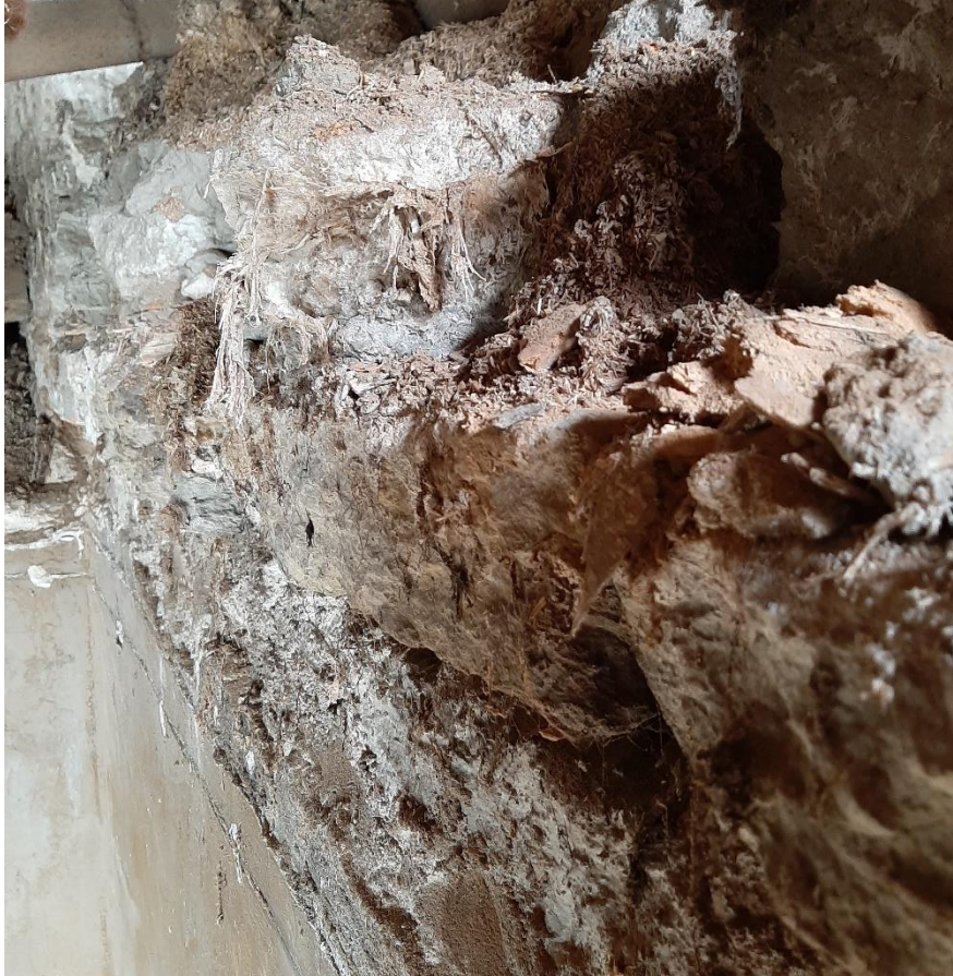
Foto 208. Vahelae peal olevas saviliiva segus olev majavammi seeneniidistik.
