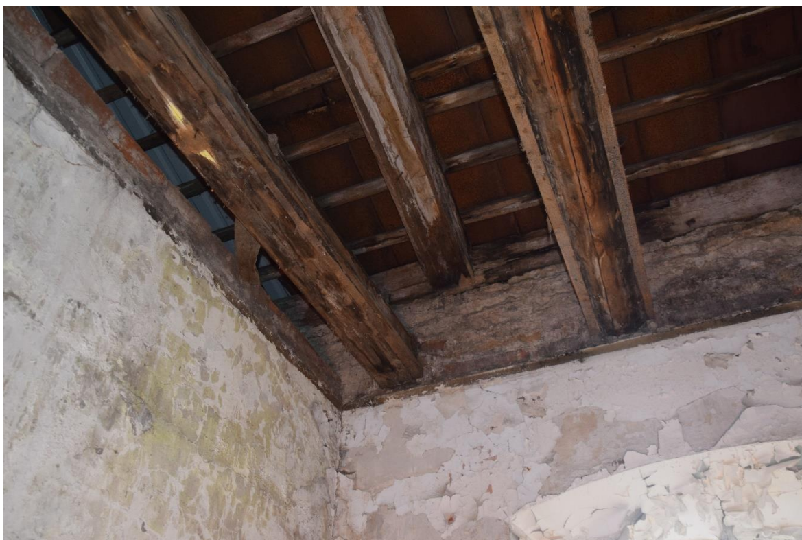
Foto 128. Sarikaotsad ruumi 3220 kohal. Resistograafi puurimised 58 ja 59.
