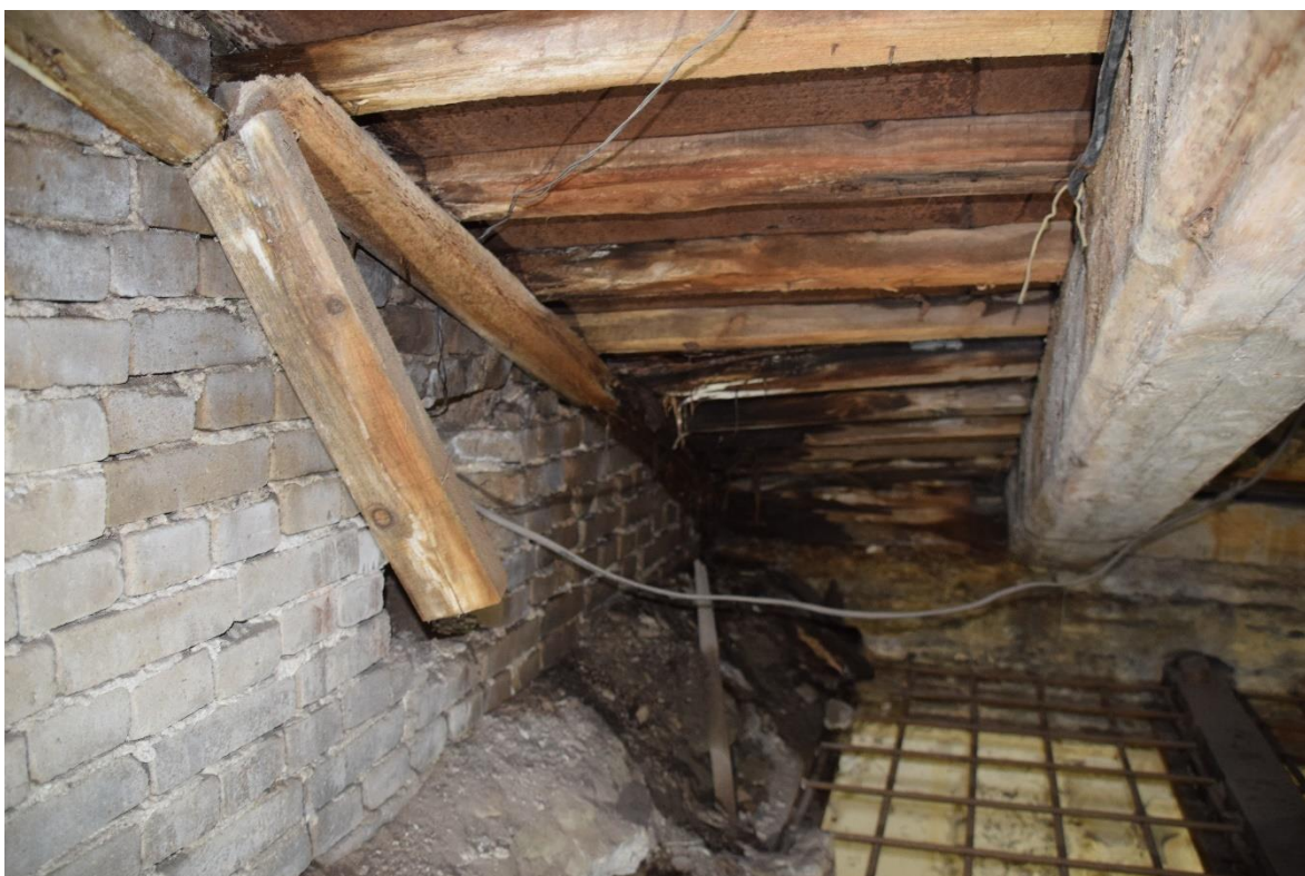
Foto 139. Märgunud piirkond vaheseina kõrval. Sarikas puudub, seda asendab liist seinal.
