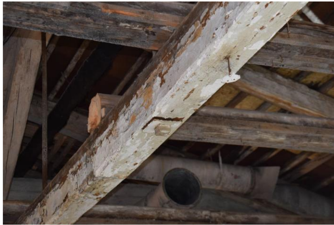
Joonis 7.14 Vahelae deformeerumise tõttu on sõrestiku alumine vöö tõusnud (autorifoto)
