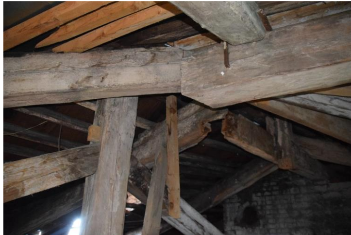
Joonis 7.12 Lünetiivade liitumiskohas olev sõlm (autorifoto)
