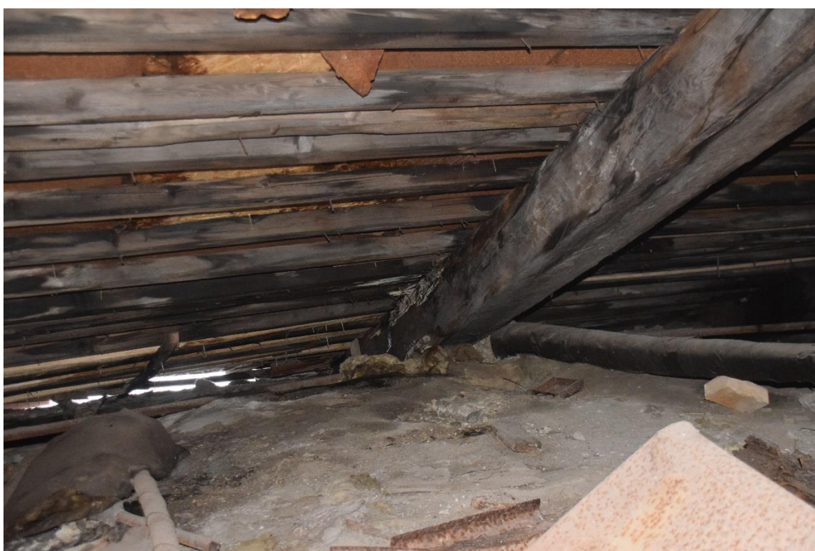
Foto 55. Seenkahjustusega sarikaots merepoolses küljes. Proovi P12 võtukoht.
