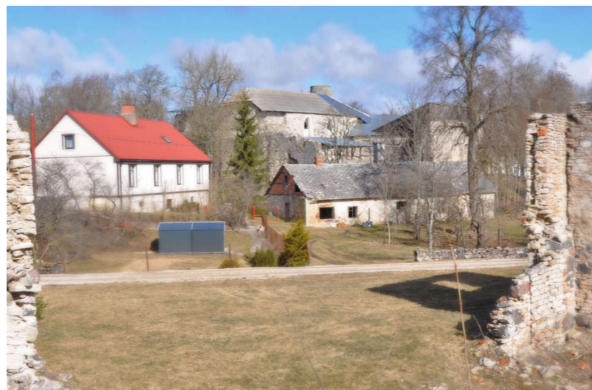
Joonis 72. Padise kloostri ja kahe mõisa-aegse kõrvalhoone vaade viinavabriku teisele tasandile loodavalt vaateplatvormilt. Allikas: autor
