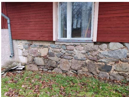
Foto 2. Sokkel hoone tagumisel küljel. Ühendus juurdeehitusega (autori foto)
