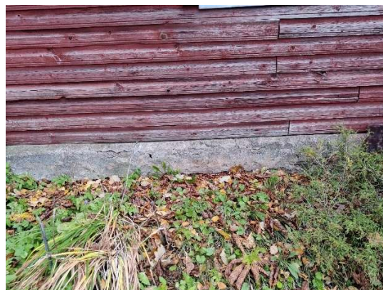
Foto 3. Hoone sokkel (autori foto)
