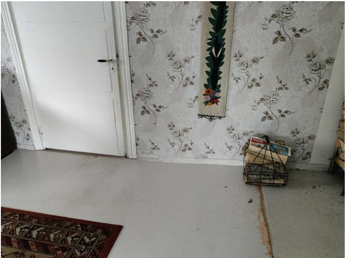
Foto 25. Toa põrand on vajunud keldriseina varisemise tõttu (autori foto)
