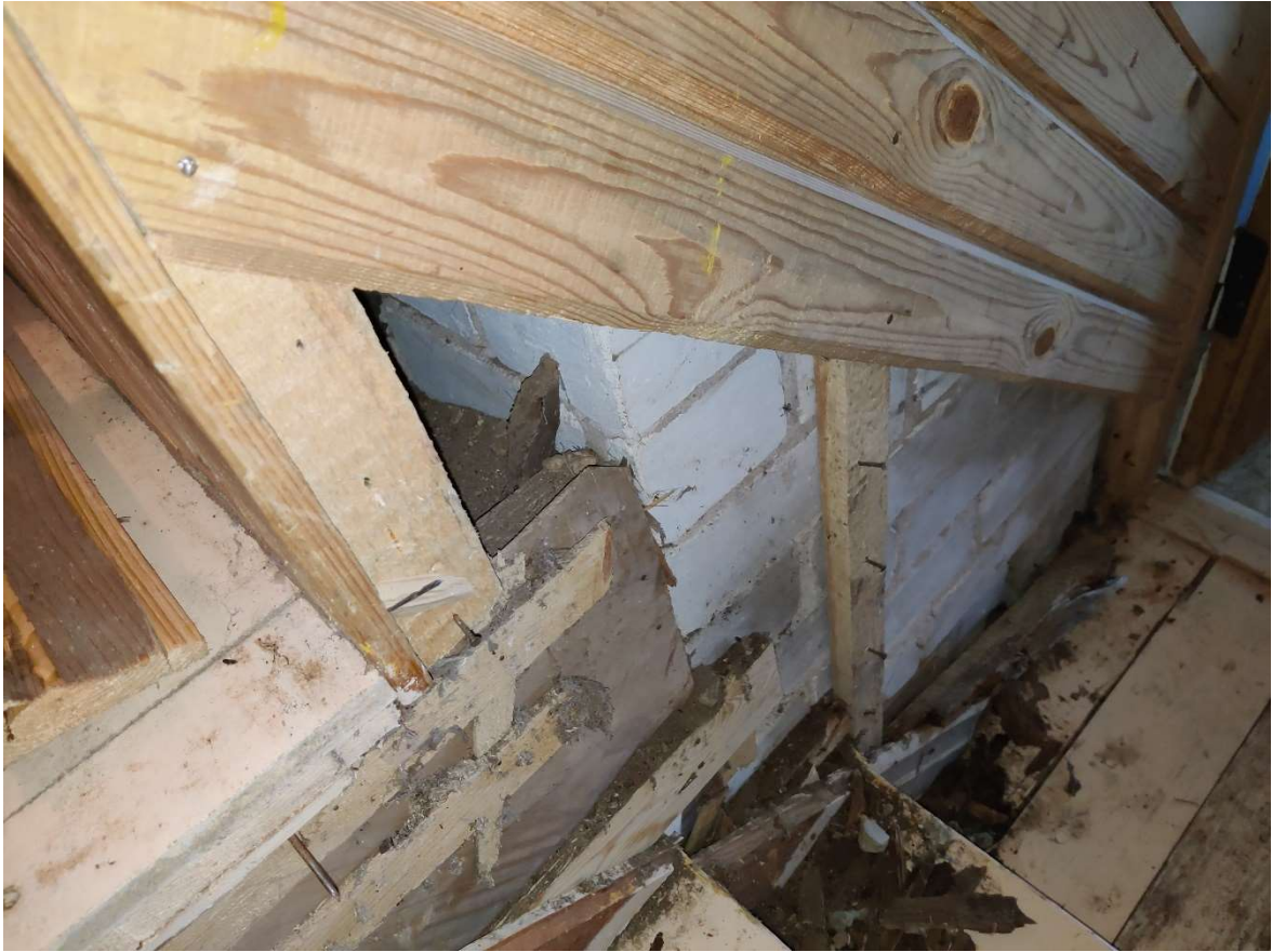
Foto 17. Ruumis 8 ukse juures tehtud avamine nr 3 (autori foto)
