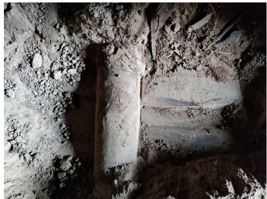
Foto 21. Vahelae talade vahel muldpõrandalauad, foto asukoha mäрге joonisel puudub (autori foto)
