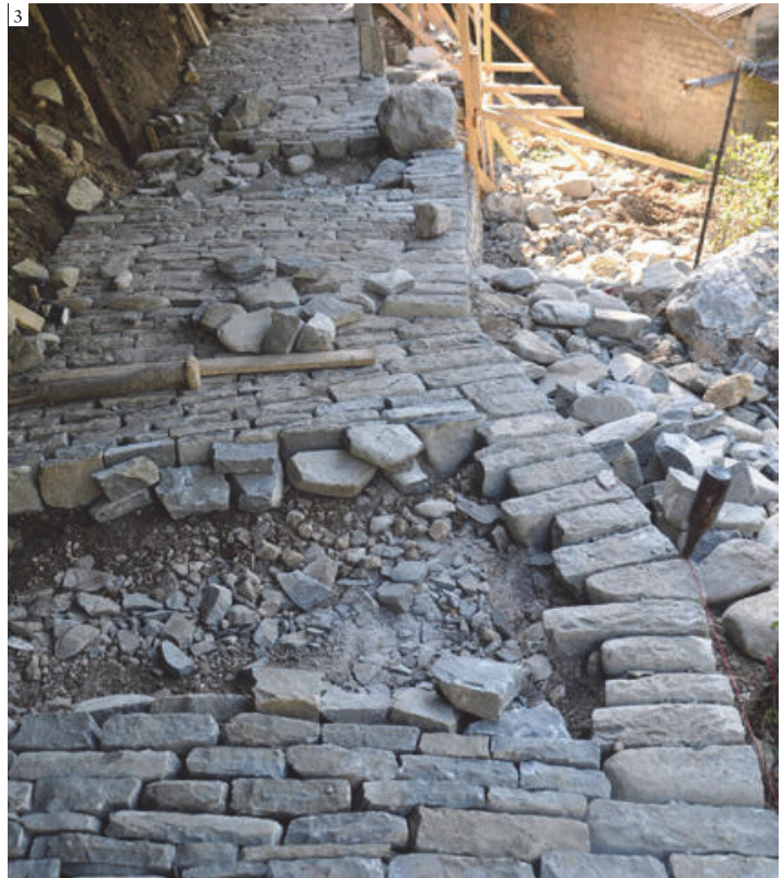
1: Handmade timber scaffolding for the dry-stone retaining wall 2: Layout of the two different types of the cobbled pathway 3: Works in progress | 1: Andamio de madeira hecho a mano para el muro de contención de piedra seca 2: Composición de los dos tipos diferentes de camino empedrado 3: Obras en curso | 1: Andamio em madeira feito a mão para o muro de contensão de pedra solta 2: Composição dos dois tipos diferentes de caminho empedrado 3: Obras em curso (1: Anna Lagaria 2: Grigoris Koutropoulos, BLK 3: Pietro Radin, George Zoilis)
