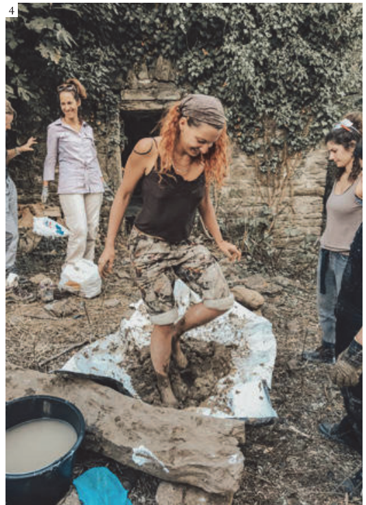
1, 2 and 4: Making traditional mortars during the 12-day workshop | 1, 2 y 4: Fabricación de morteros tradicionales durante el taller de 12 días de duración | 1, 2 e 4: Fabricação de argamassas tradicionais durante o atelier de 12 dias de duração | 3: Participantes a trabalhar no caminho (1, 2, 4: Athena Apostolou | 3: Pietro Radin, George Zoilis)
