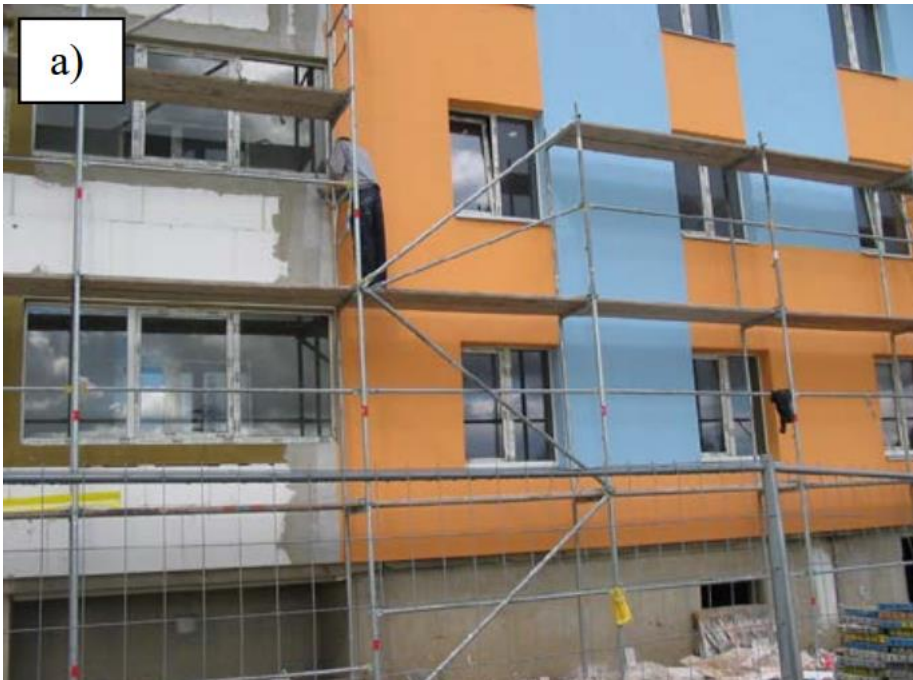
Joonis 11. ETICS süsteemi paigaldusprotsess avatud tellingutel
