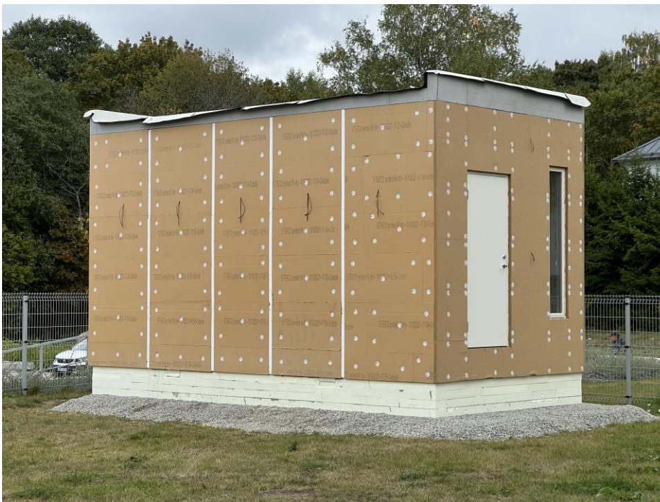
Joonis 17. Mäepealse 3 platsile paigaldatud CLT-testmaja enne krohvimistööd.
