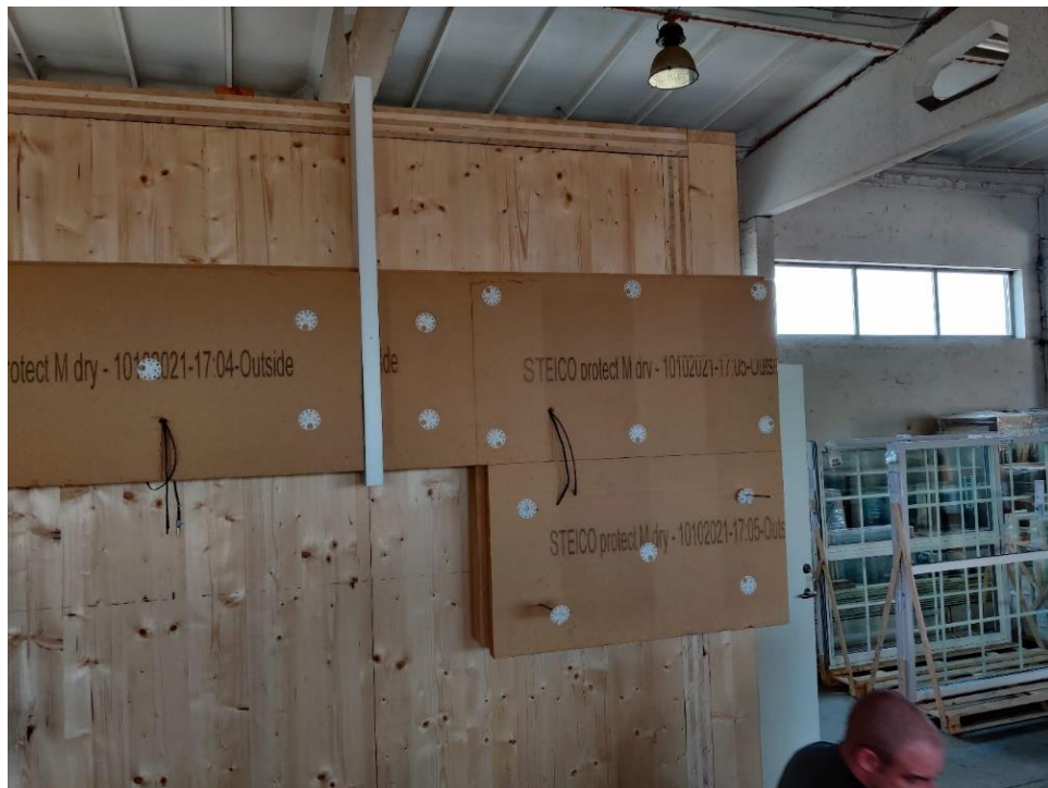
Joonis 15. EPS- ribadega eraldatud seinasektsioonid.
