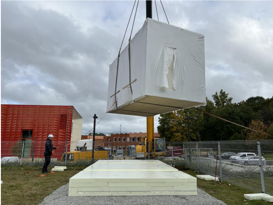
Joonis 16. Testmaja paika tõstmine.
