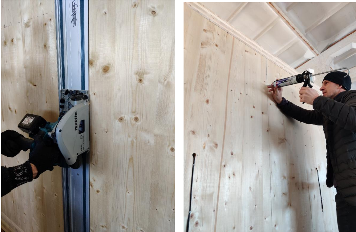
Joonis 14. Seinalõikude eraldamine freesitud soontega ning soone täitmine mastiksiga.
