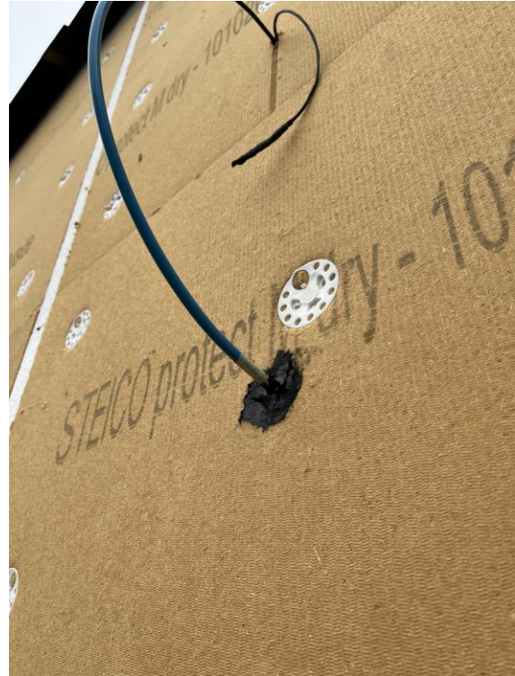
Joonis 35. Veetoru paiknemine paneeli ja ristkihtliimpuitpaneeli vahel ning mastiksiga isoleeritud veetoru soojustuse pinnal. (Saare, 2023)
