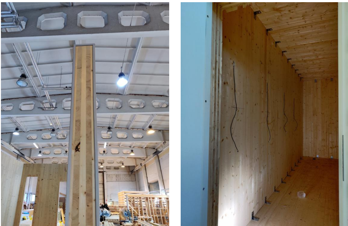
Joonis 13. Elemendi tihendatud servad ja elemente fikseerivad nurgikud.
