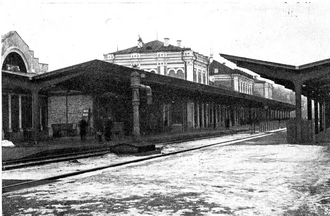
Kaunase raudteejaam. Uued perroonid katusealustega.
