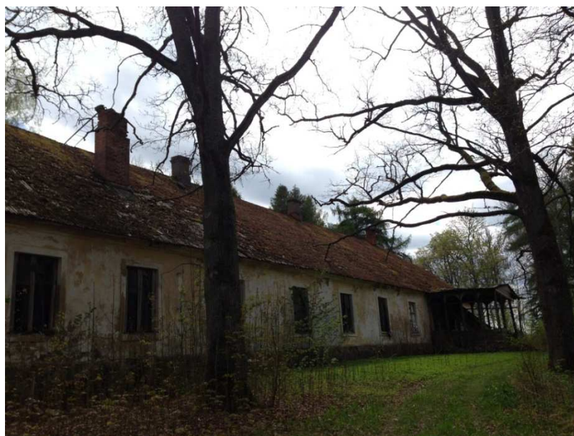
Joonis 2.4. Hoone loodefassaad ja korstnapitsid
