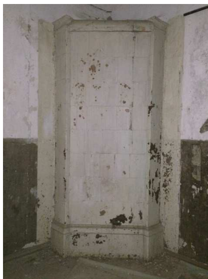
Joonis 2.21. Valgetest glasuorpottidest ahi (AHI 10) Ruumis 20
