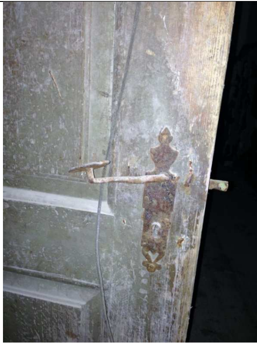
Joonis 2.20. Ruumide 24 ja 25 vahelise siseukse SU31 link ja karplukk
