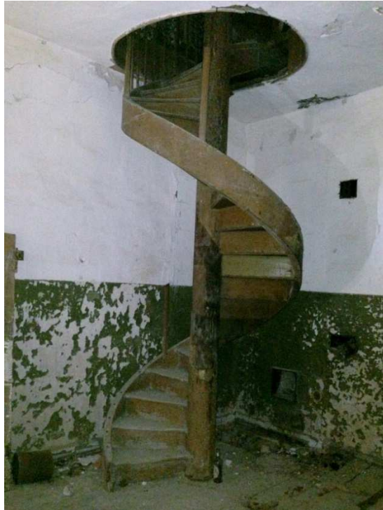
Joonis 2.18. Puidust keerdtrepp (TR3) Ruumis 5
