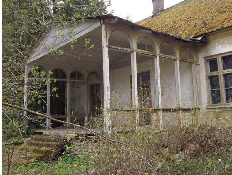
Joonis 2.11. Veranda hoone kagufassaadil
