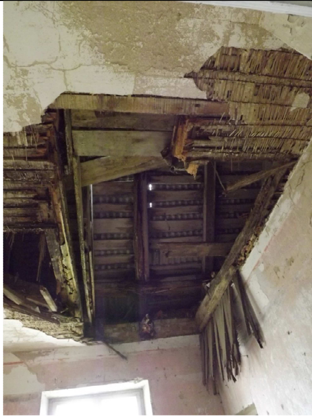
Joonis 2.13. Varisenud lagi Ruumis 21
