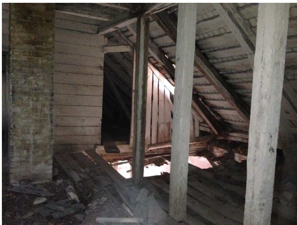
Joonis 2.12. Varisenud vahelagi hoone uuemas osas Ruumi 21 kohal
