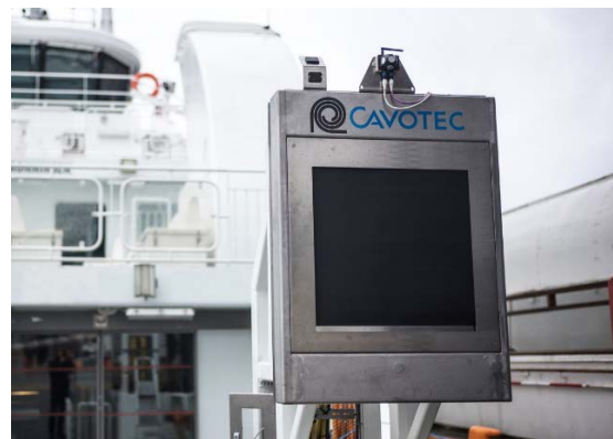
Joonis 1.3 a) FerryCHARGER laadija Stemmann-Technik tootjalt [35] ning b) Cavotec -i pistikupesa praamil [36]
