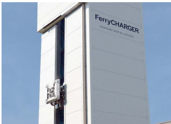
Joonis 1.3 a) FerryCHARGER laadija Stemmann-Technik tootjalt [35] ning b) Cavotec -i pistikupesa praamil [36]
