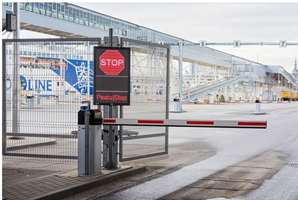
Joonis 1.2 Tallinna D-Terminali automaatse liikluse juhtimise süsteem Allikas: Hansab AS Koduleht
