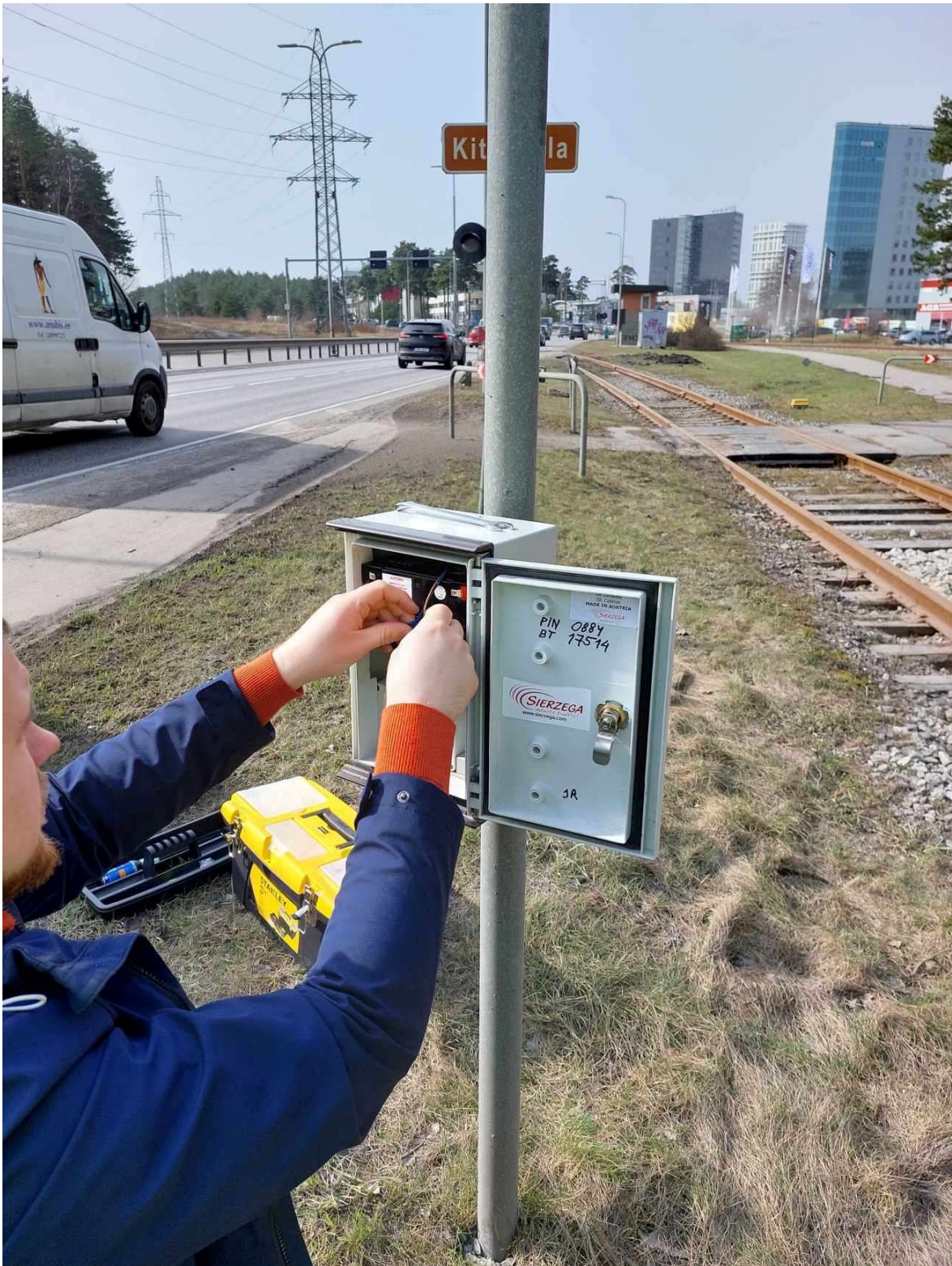
Joonis 2.14 Loendusseadme paigaldamine Järvevana teel, linna siseneval suunal
