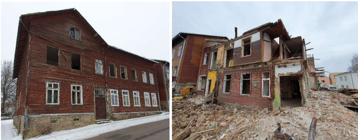
Joonis 2. Fotod E. Enno 18 hoonest enne lammutamist ja lammutamise protsessist
