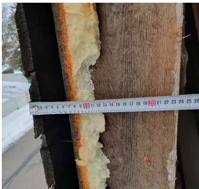
Joonis 11. Foto välisseina kihistusest demonteeritud avatäite kohast
