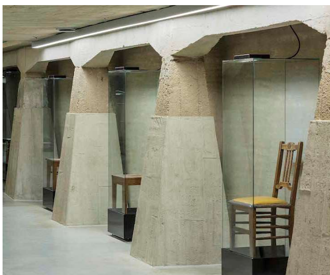
Joonis 6. Eksponeeritud püramiidjad betoonpostid [26]
