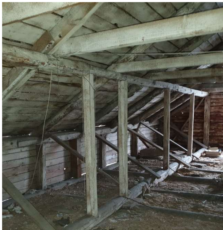
Joonis 13. Foto pööningult. Pildil on näha ümaraid sarikaid ja prusse katuse konstruktsioonina
