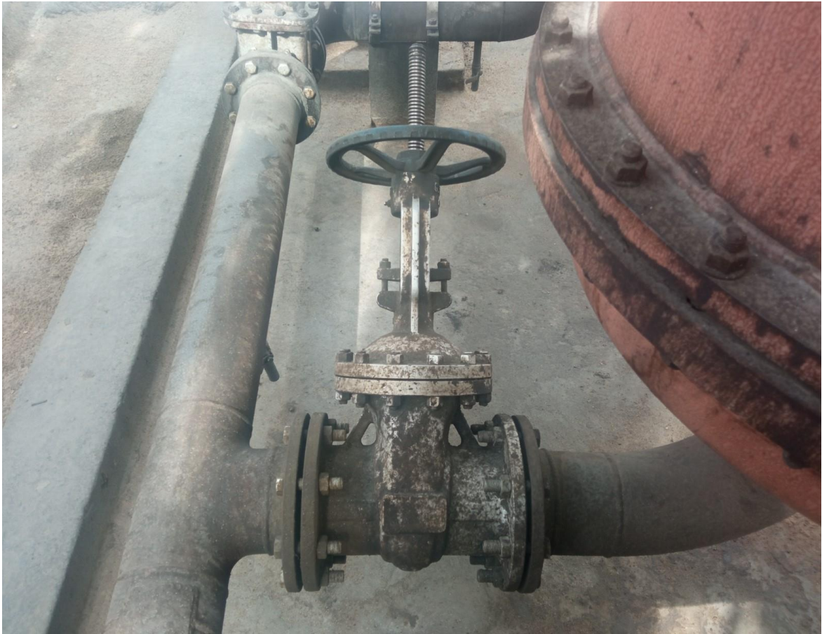
Joonis. 1.1 Siiberventiiil.
