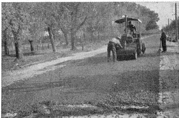
Asfaltkate kinnirullimine Riia maanteel Pärnus (1936. a.)
