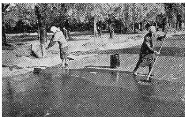
Asfaltkate pealispindamine asfalt-emulsiooniga Pärnus (1936. a.)
