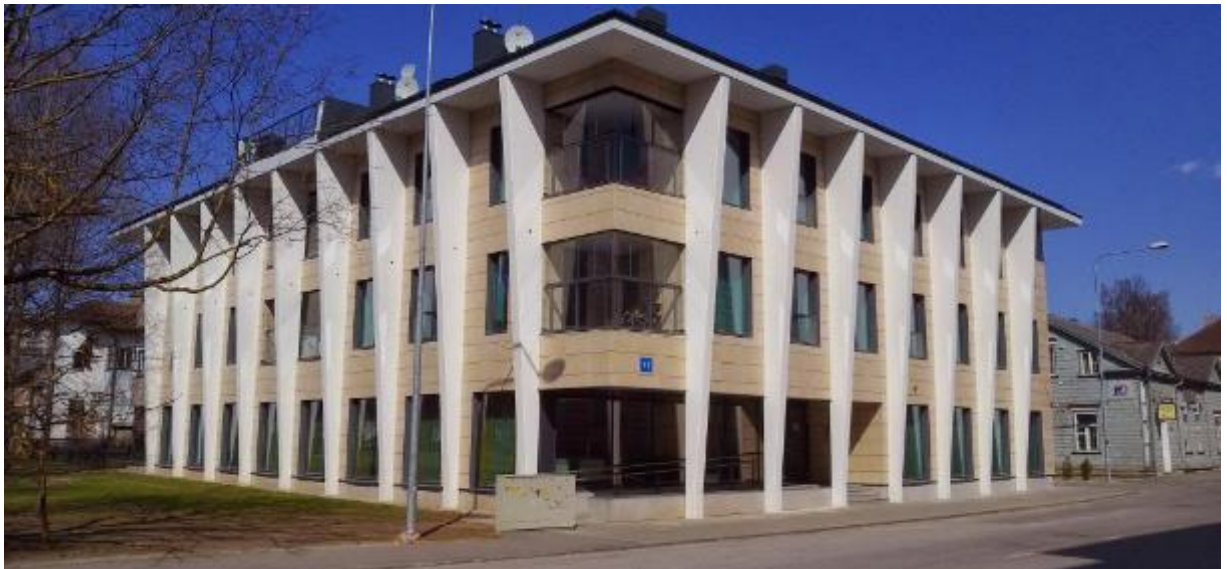
Pilt 23. Sammastesse peidetud sademeveetorud, maa-alune kogumissüsteem. Tartu, Vanemuise tn (allikas:SkyScaperCity)
