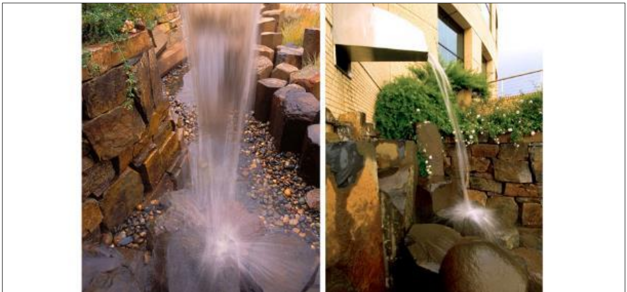
Pilt 24. Sademevee väljavool Oregoni Messikeskuse katuselt (allikas:ASLA)
