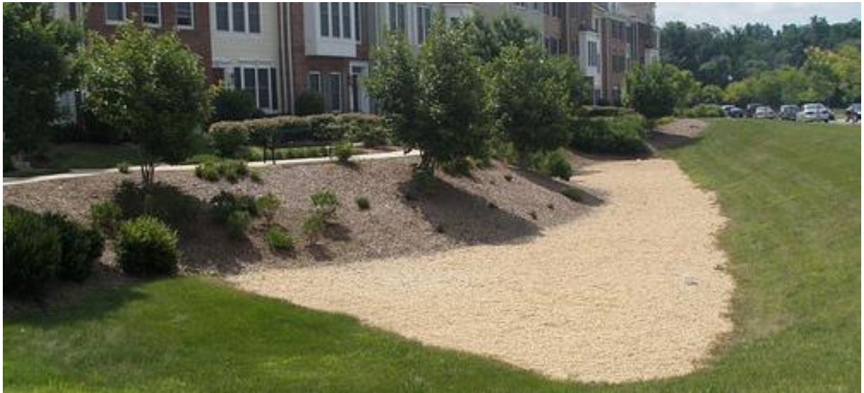
Pilt 5. Maapealne liivafilter. New York, Seneca (allikas: Montgomery County Environment Protection)
