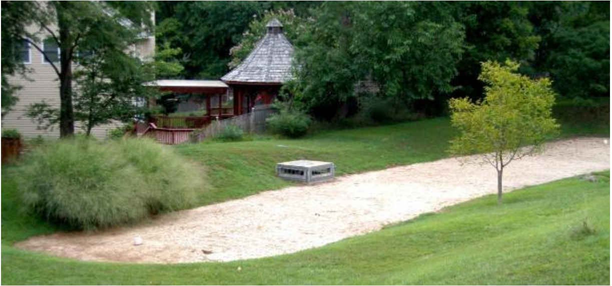
Pilt 6. Maapealne liivafilter, Maryland, Rockville (allikas: Montgomery County Environment Protection)
