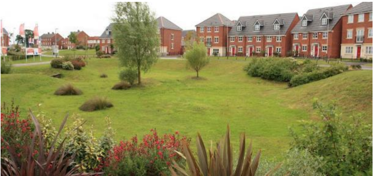
Pilt 2. Kuivtiik elamupiirkonnas. Suurbritannia, Leicester (allikas:Susdrain)
