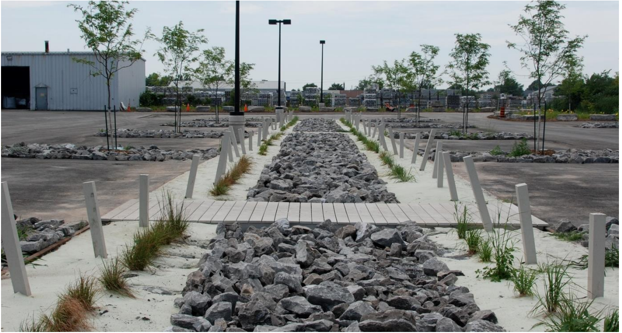
Pilt 9. Imbkraav. Kanada, Niagara Falls (allikas: theAgritect)
