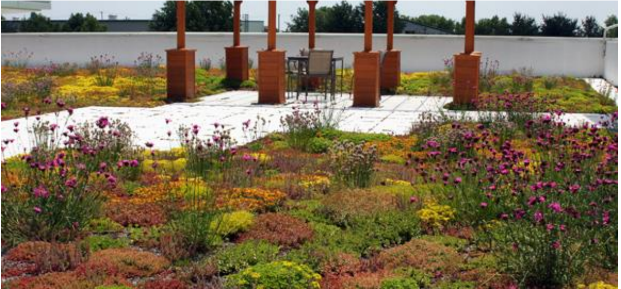
Pilt 19. Ekstensiivne haljaskatus Pensilvaania, West Grove (allikas: Green Roof Plants)
