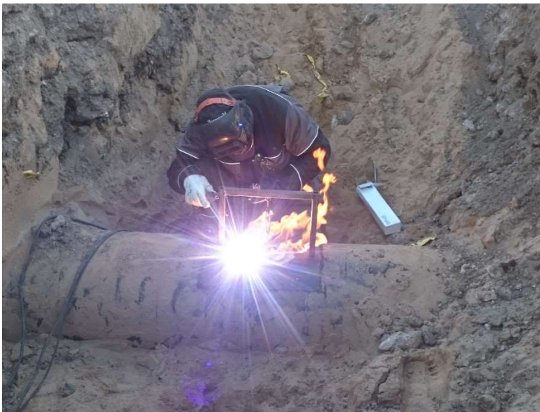
Joonis nr 25. D-kategooria maagaasi toru sulgurpalli akna keevitamine maagaasi/õhu piiril 2016. a. Foto: Autori erakogu.
