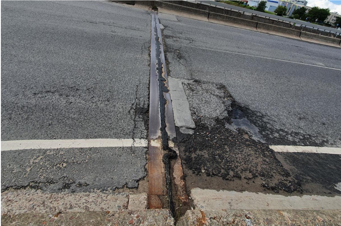
Joonis 3.8 Võidujooksu viadukti vuuk
