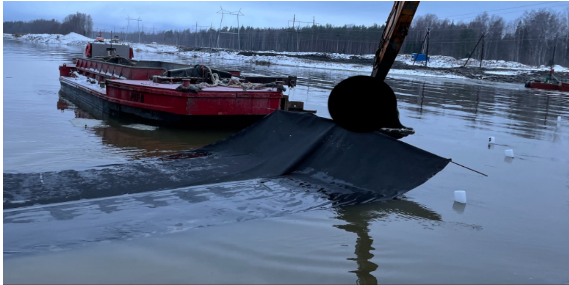
Foto 5.3 Geotekstiili paigaldamine kasutades ekskavaatori abi, erakogu.
