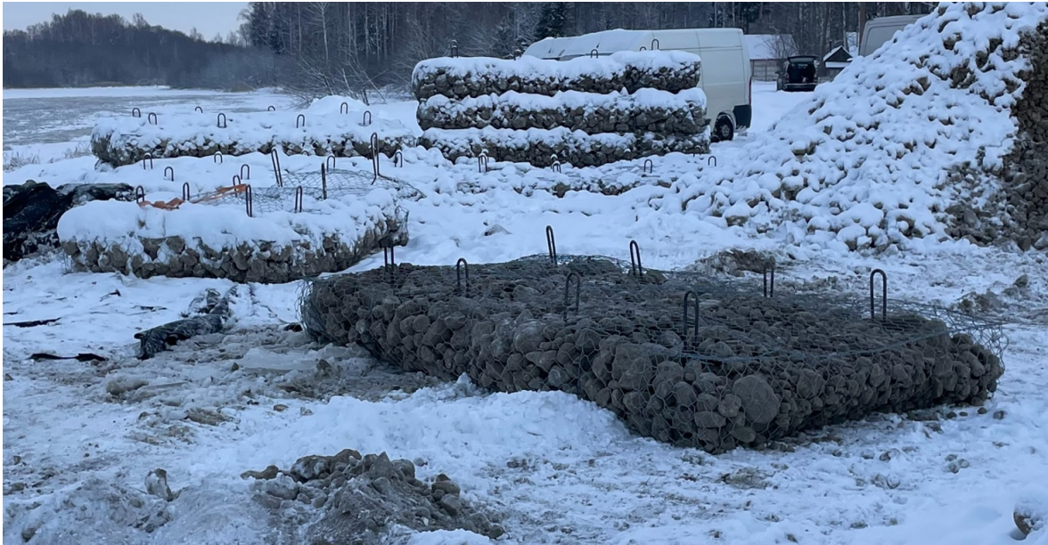
Foto 2.2 Fraktsiooniga 90...300 mm aherainega täidetud gabioonkorvid, erakogu
