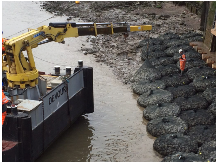
Foto 3.2 Kivikottide paigaldamine ühe kihina [10]
