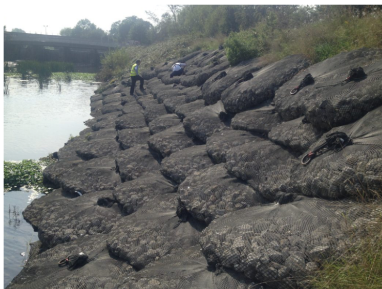
Foto 3.3 Kivikottide paigaldamine astmeliselt [10]
