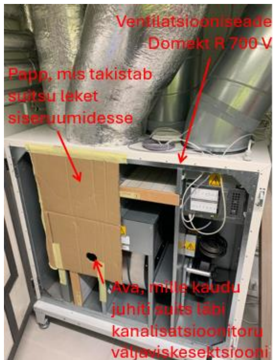
Joonis 2.14 Ventilatsiooniseadme ettevalmistus
