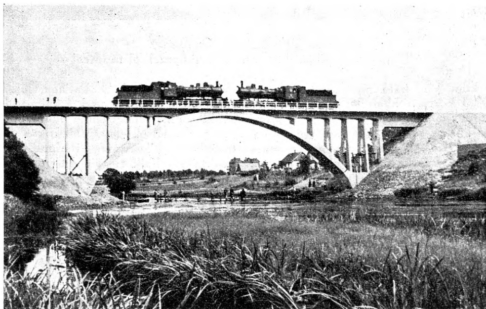
Uus raudbetoonsild üle Salace jõe Mazsalace jaama juures. Pikkus 82 m, kõrgus üle veepinna 16 m.
