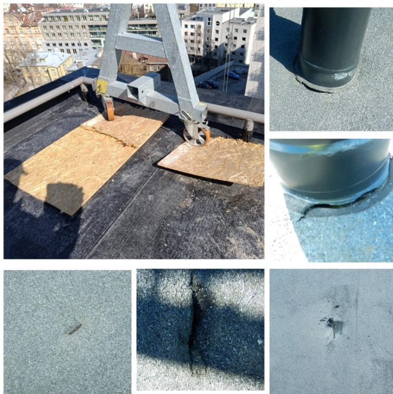
Joonis 3.3 Mehaanilised kahjustused, praktiline osa
