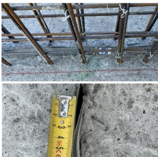
Joonis 3.15 Lühike või liiga pikk ülekate, praktiline osa
