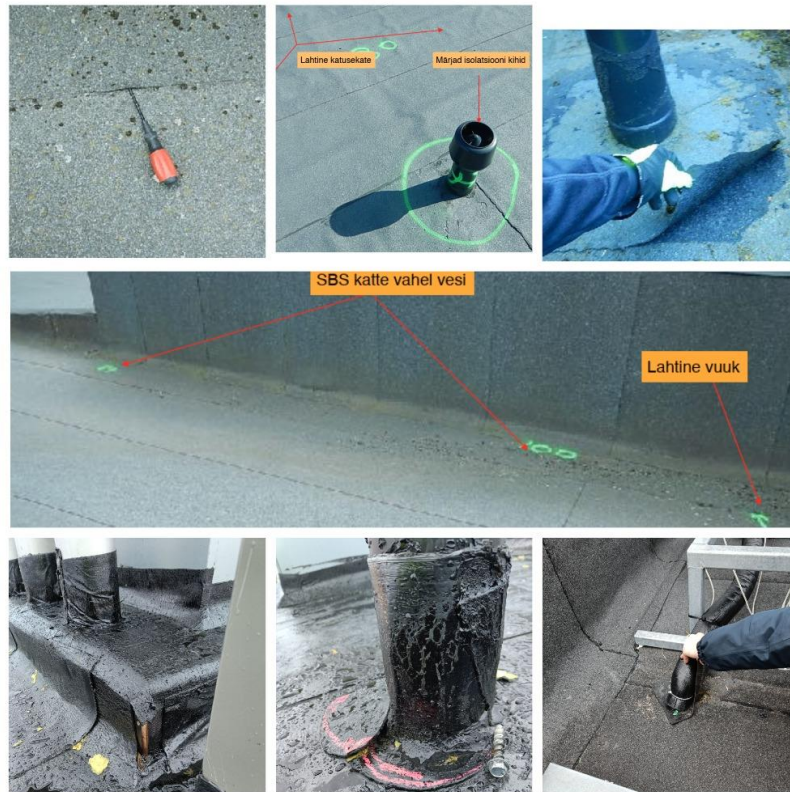
Joonis 3.5 Keevitamata SBS, praktiline osa
