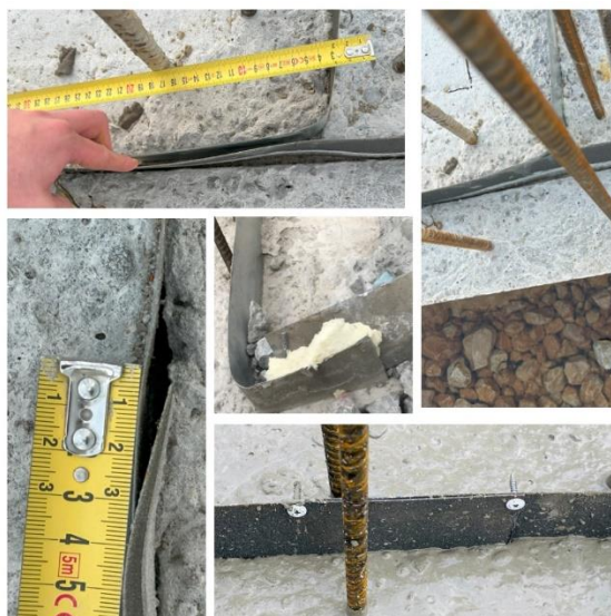
Joonis 3.16 Valed kinnitustarvikud, praktiline osa
