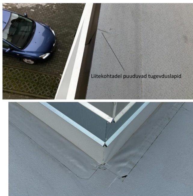
Joonis 3.8 Tugevduseta sisemised ja välisnurgad, praktiline osa
