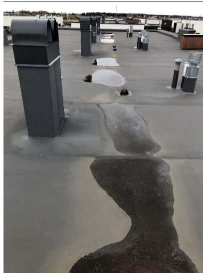
Joonis 3.11 Lohud katusemembraanil, praktiline osa
