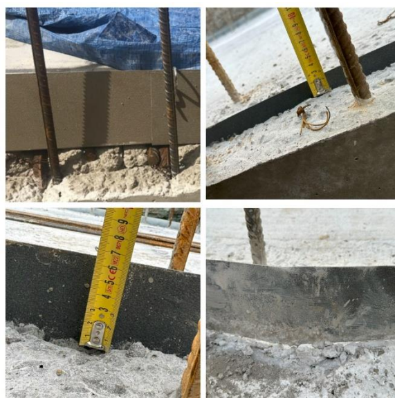
Joonis 3.17 Profiili vale paigalduskõrgus, praktiline osa
