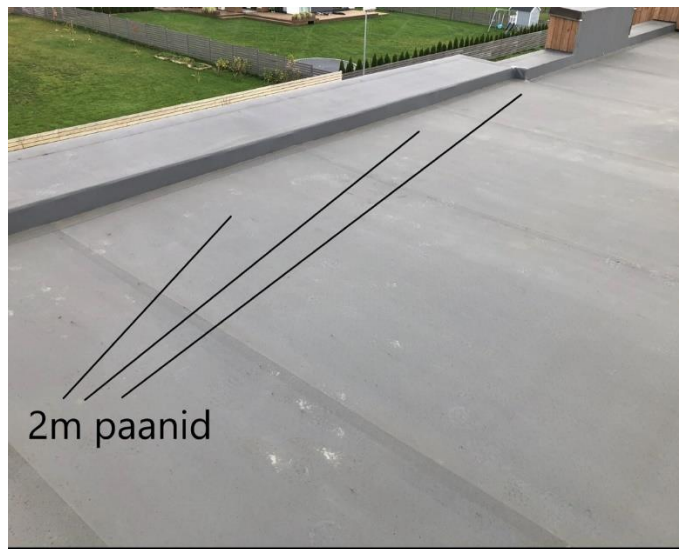
Joonis 3.9 Vale laiusega paanid, praktiline osa
