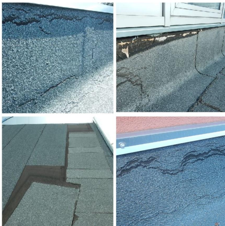
Joonis 3.4 Puistekihi valgumine, praktiline osa
