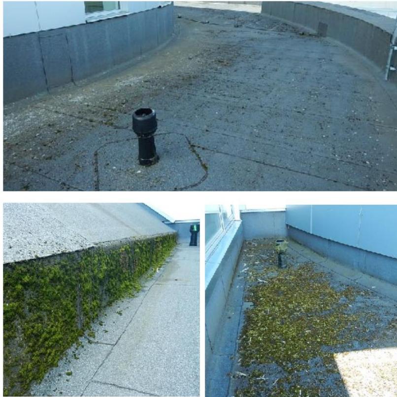
Joonis 3.2 Sammal ja orgaanilised reained, praktiline osa
