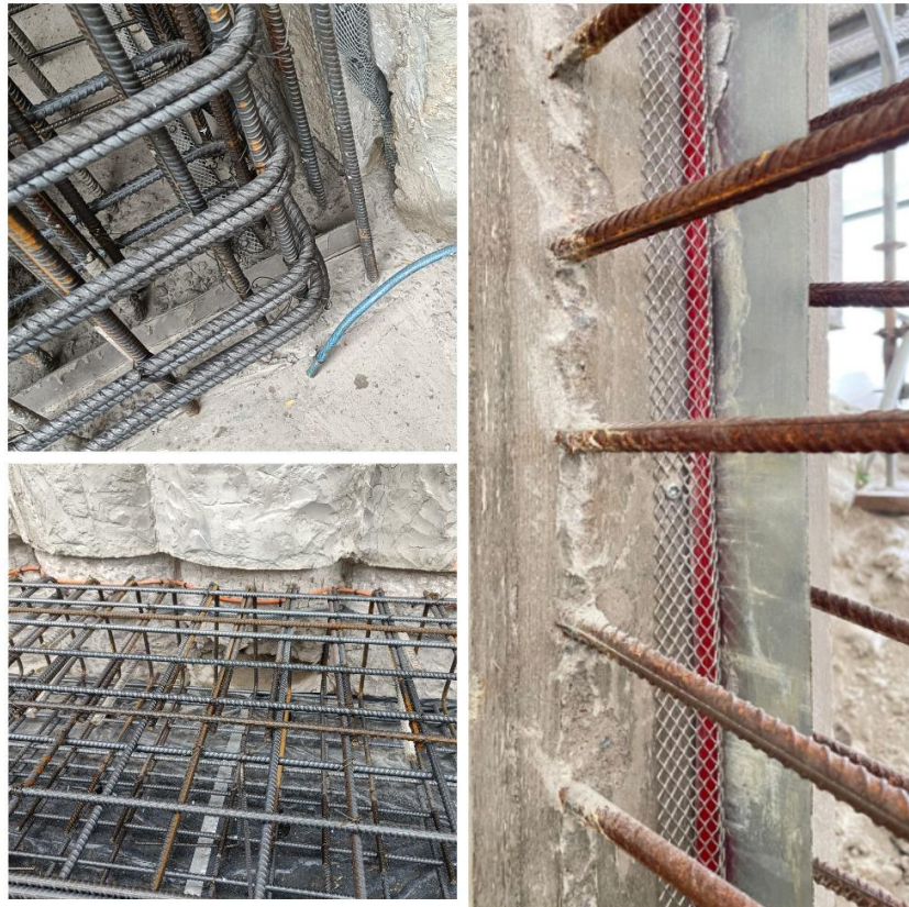
Joonis 3.22 Injekteerimisvooliku paigaldusprotsessi näide, praktiline osa
