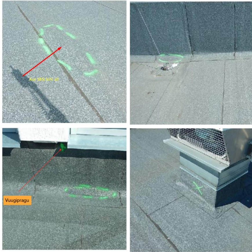
Joonis 3.1 Aurukottide kahjustused, praktiline osa
