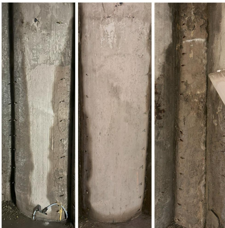
Joonis 3.23 Punktinjekteerimise näide, praktiline osa
