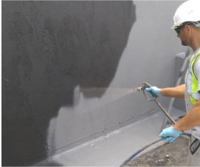
Joonis 3.24 Täiendava hüdroisolatsioonikihi peale kandmine konstruktsiooni veepidavuse saavutamiseks, praktiline osa
