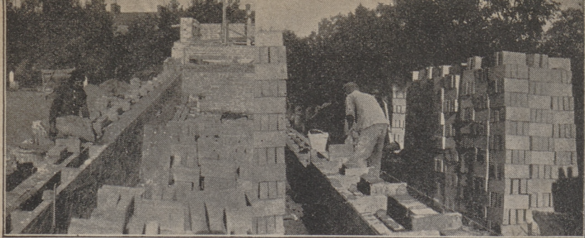
Joon. 29. Nopsa-seina ehitamine. Vasakul naistöoline täidab siselõõri saepuru ja põlevkivituha seguga; paremal tööline laob seina.
