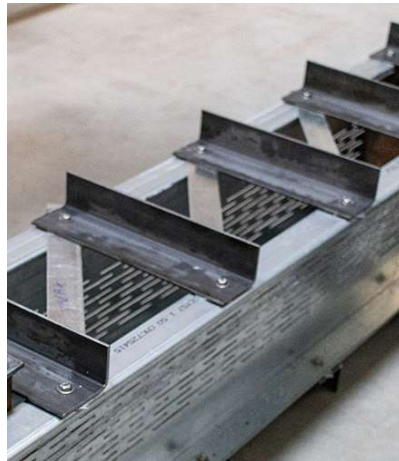
Joonis 3.3 Nurkraud on kinnitatud roovide külge koos diagonaalidega
