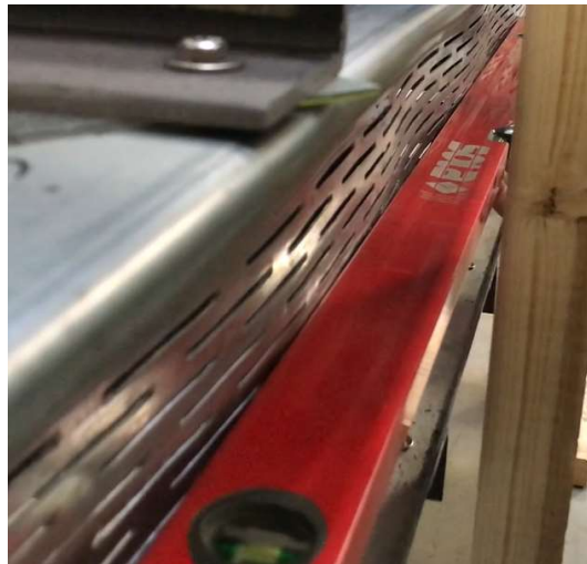
Joonis 4.12 Seinä välja mõlkumise lainesügavus
