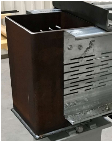
Joonis 3.5 Ühendusdetailid ja profiili ühendus suurkruviga
