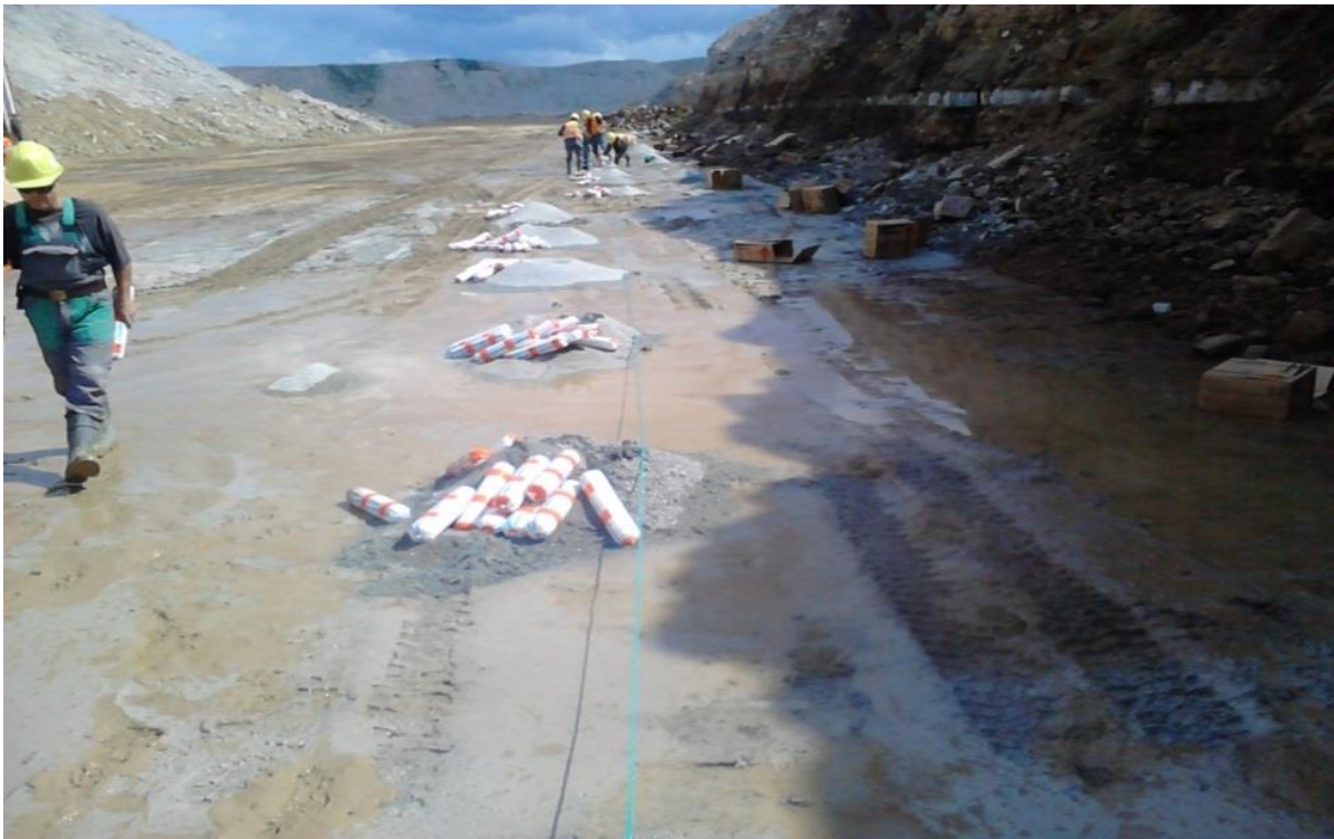
Foto 2. Veekõrvalduskraavi laadimine (autori foto) ( DSC_0120.jpg )
