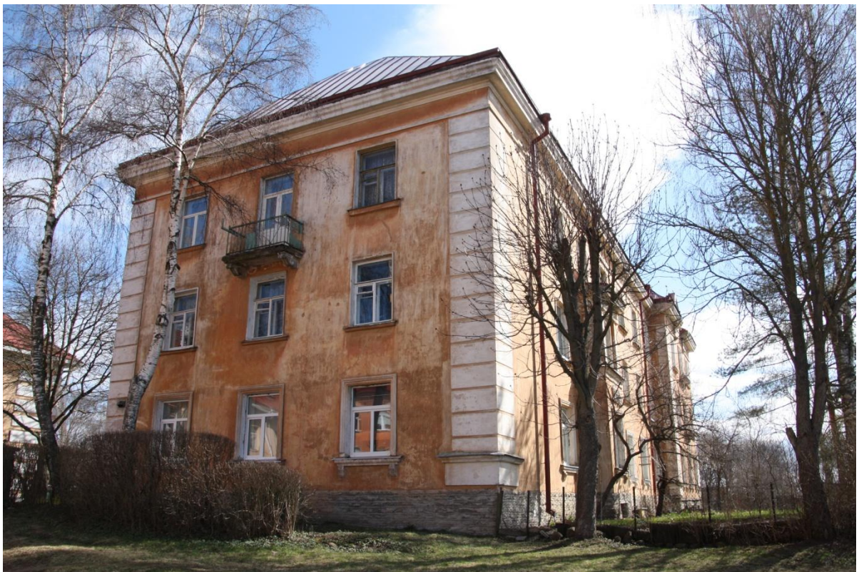
Joonis L1.4 Vaade hoonele läänest
