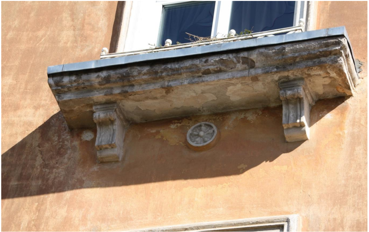
Joonis L1.10 Lillekastikonsooliga aken ning selle alune stukkdetail
