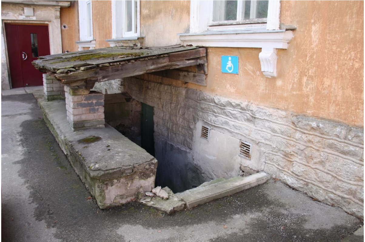
Joonis L1.19 Keldri sissepääsu lagunenud varikatus
