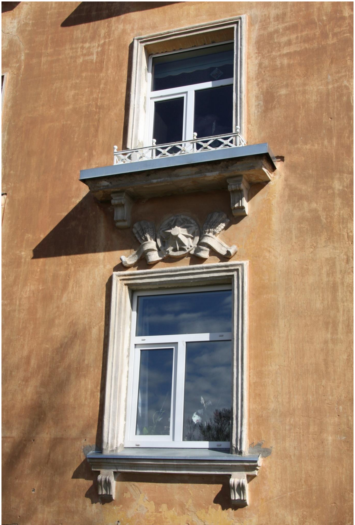
Joonis L1.9 I korruse aken, viisnurgaga stukkdetail ning lillekastikonsooliga II korruse aken
