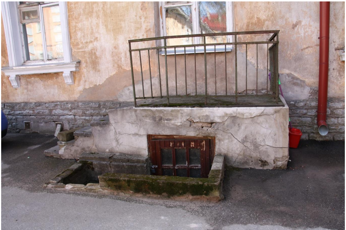
Joonis L1.20 Kaupluse laoruumide endine sissepääs, ukseava kinni laotud aknaks
