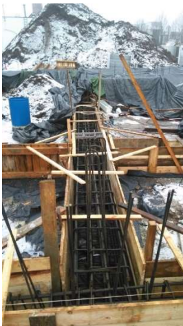
Joonis 6.6. Laudisest raketise ehitamine [28]
