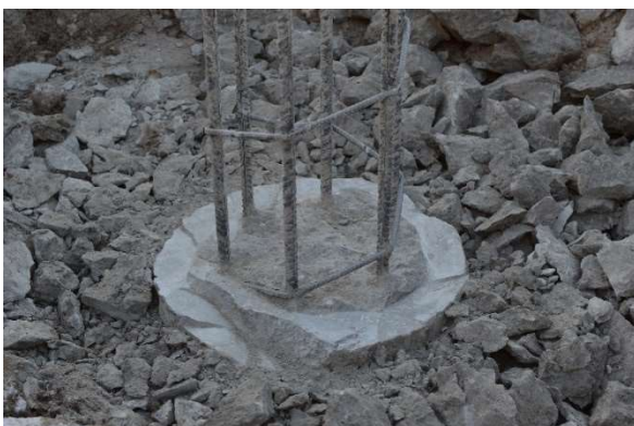
Joonis 6.4 Korrektselt teostatud vaia lõikamise- ja piikamise töö [28]
