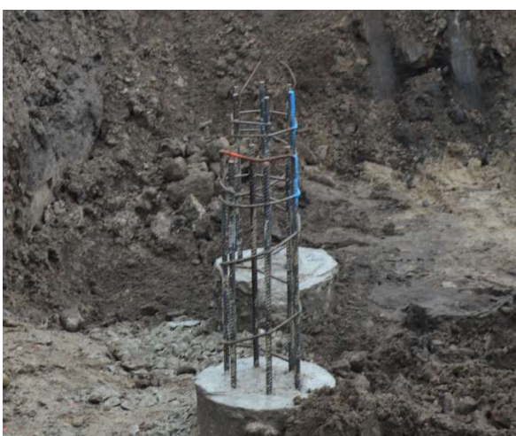
Joonis 6.4 Korrektselt teostatud vaia lõikamise- ja piikamise töö [28]
