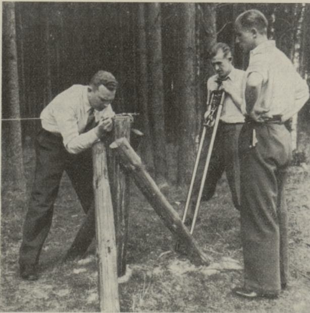
Joon. 4. Lugem traadilt; näha ka pingutusstatiiv.
