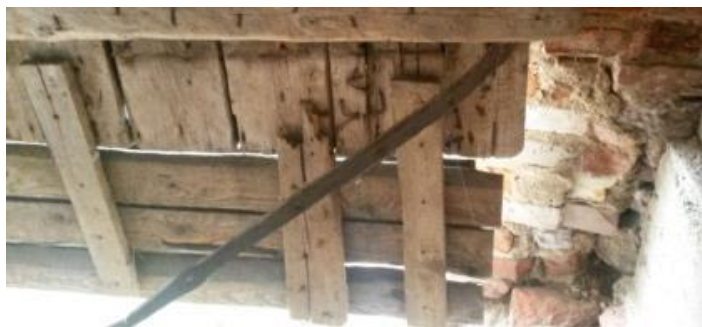
Foto 61. Tallivärava VU4 vasakpoolne alumine sepishing DS13. (Foto: autor, mai 2014)
