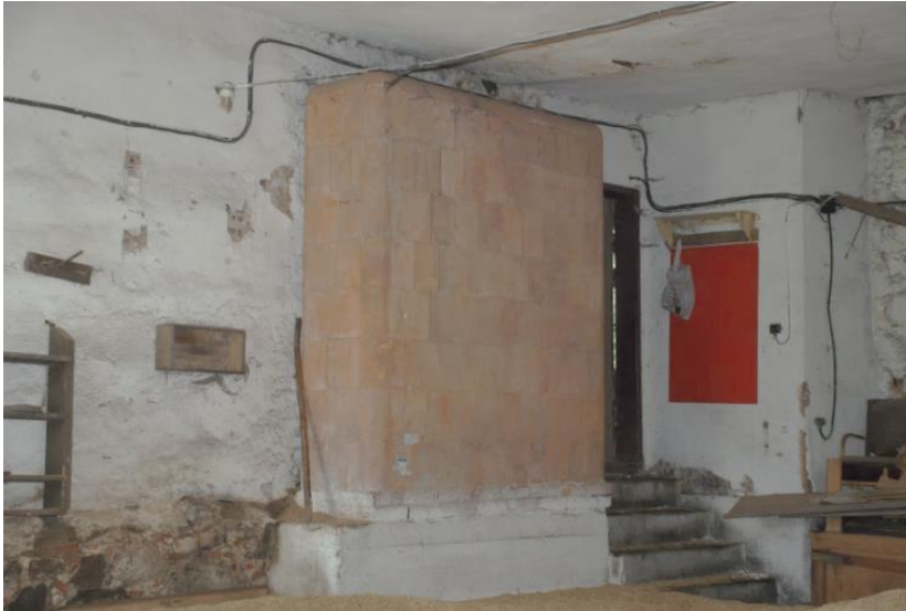
Foto 83. Ruumi 16 massiivse ahju tagakülg. (Foto: autor, mai 2014)
