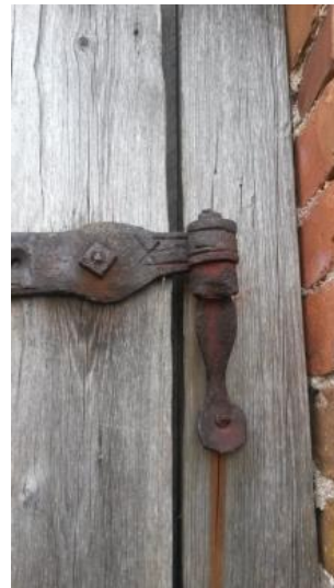
Foto 40. Ukse VU3 sepiostatud hinge detail DV11. (Foto: autor, mai 2014)
