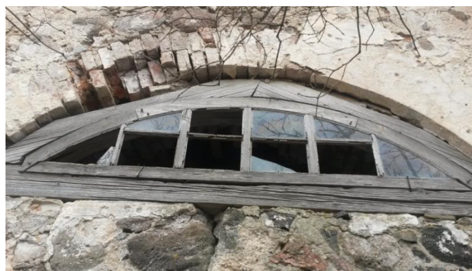
Foto 36. Tiheda ruudujaotusega termaken A14, millel on laia krohviraamistusega ja lukukivi motiiviga aknapiire DV7. (Foto: autor, jaanuar 2014)
