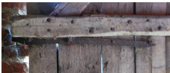
Foto 61. Tallivärava VU4 vasakpoolne alumine sepishing DS13. (Foto: autor, mai 2014)
