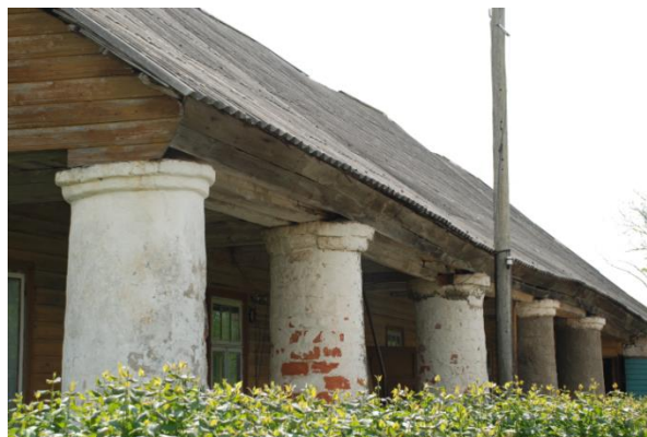
Foto 34. Hoone esifassaadi viis jämedat dooria sammast DV5. (Foto: autor, mai 2014)
