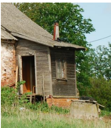
Foto 19. Tagafassaadi tuulekoda. (Foto: autor, mai 2014)
