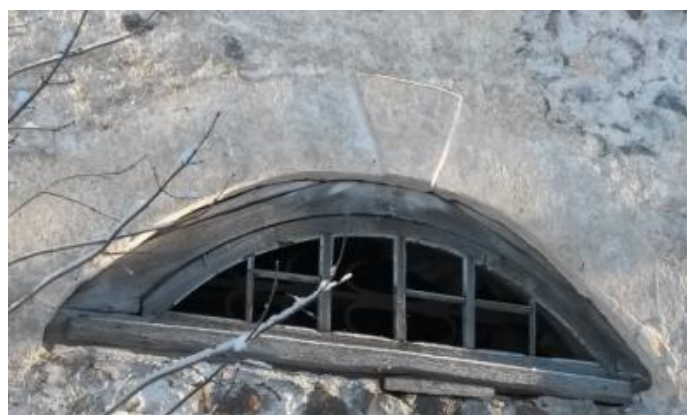
Foto 35. Tiheda ruudujaotusega termaken A15, millel on laia krohviraamistusega ja lukukivi motiiviga aknapiire DV6. (Foto: autor, jaanuar 2014)
