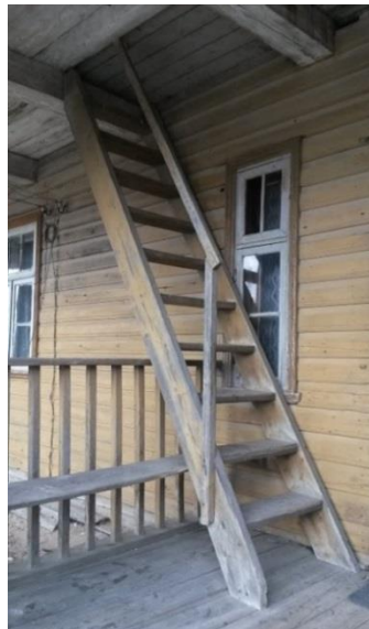
Foto 45. Verandale DV9 jääv pööningutrepp DV13. (Foto: autor, mai 2014)
