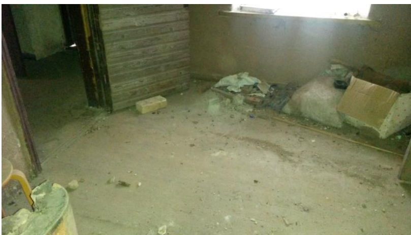
Foto 85. Ruumi 15 põrand. (Foto: autor, mai 2014)
