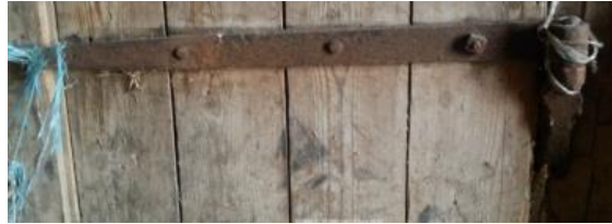
Foto 69. Latriukse SU27 parempoolne alumine uksehing DS23. (Foto: autor, mai 2014)
