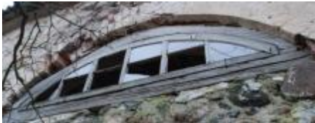
Foto 7. Esifassaadi tiheda ruudujaotusega termaken. (Foto: autor, mai 2014)
