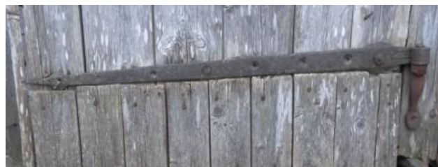
Foto 42. Tagafassaadi ukse VU3 sepiostatud alumine hing DV11'. (Foto: autor, mai 2014)
