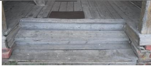
Foto 44. Esifassaadil oleva veranda DV9 puidust peatrepp DV12. (Foto: autor, mai 2014)
