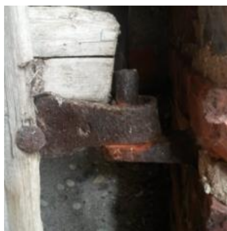
Foto 64. Tallivärava VU4 väravahing DS17. (Foto: autor, mai 2014)
