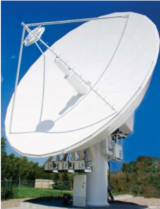
Sele 1.2 13-meetrise reflektori diameetriga parabool antenn
