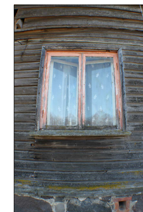
UUED AKNAD ON TÖSTETUD KAKS PALGIRIDA KÕRGEMALE UUED AKNAD ASENDADA VANADE AKENDE KOOPIATEGA JA PAIGALDADA VANALE KÕRGUSELE.
