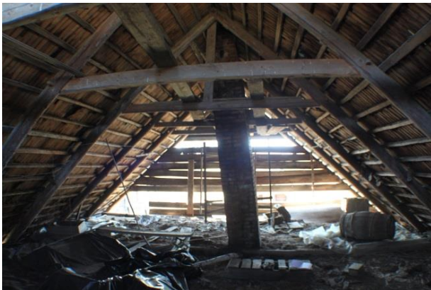
Foto nr 13. Katusekonstruktsioon ja viltu laotud korsten
