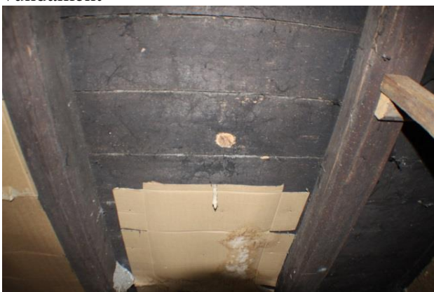
Foto nr 21. Sisse vajunud põrand, talad ja vundament
