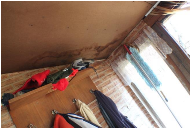
Foto nr 31. Juurdeehitise laes on näha niiskuskahjustusi
