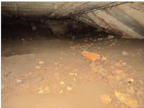
Foto nr 19. Põranda konstruktsioon. Paremalt on näha sisse vajunud põrand
