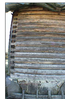
ALUMISED 4 PALGIRIDA ON PEHKINUD PALGID ASENDADA
