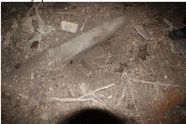
Foto nr. 17. Vahelaetalad, mille vahele on löödud must laudis, mis on omakorda kaetud, sambla ja liivaga
