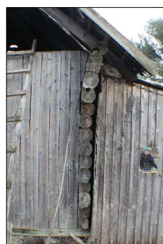
SEINAD ON VAJUNUD SEINADELE PAIGUTADA SIRUTUSPUUD
