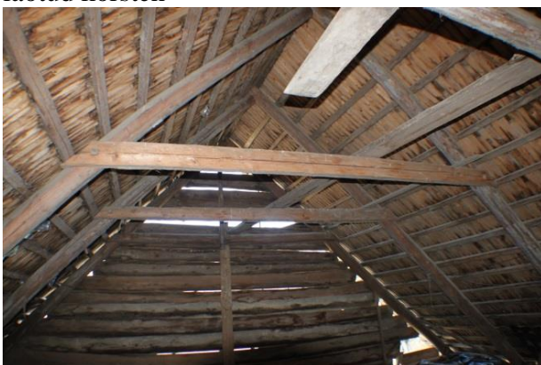
Foto nr. 15. Katusekonstruktsioonid – sarikad ja pennid
