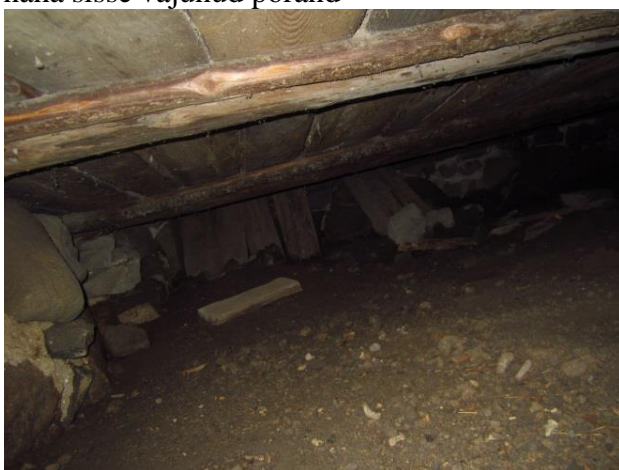
Foto nr 21. Sisse vajunud põrand, talad ja vundament
