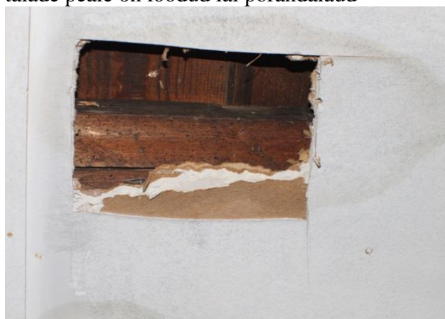
Foto nr 22. Vahelae konstruktsioon, mis on kaetud kipsplaatidega
