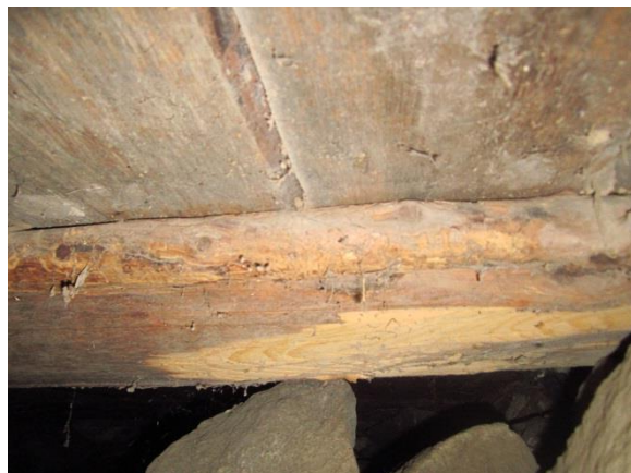
Foto nr 20. Põrandatalad on toetatud kividele ja talade peale on löödud lai põrandalaud
