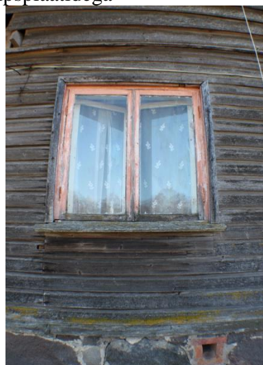
Foto nr 24. Uued aknad, akna all on näha vanade akende paiknemist- 2 palgirida all pool
