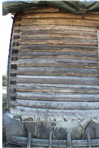
Foto nr 8. Avatud palksein, neli alumist palgirida on pehkinud
