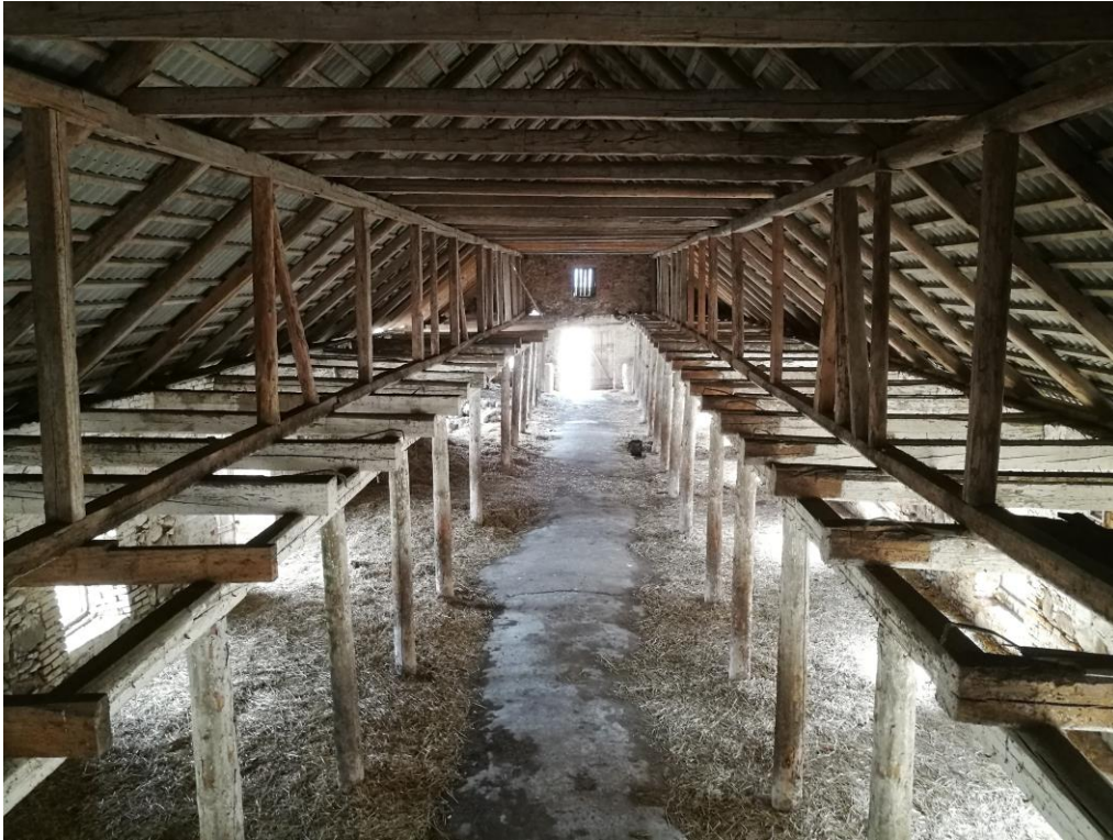
Foto 6. Vaade katusekonstruktsioonile (Foto: autor, aprill 2017)
