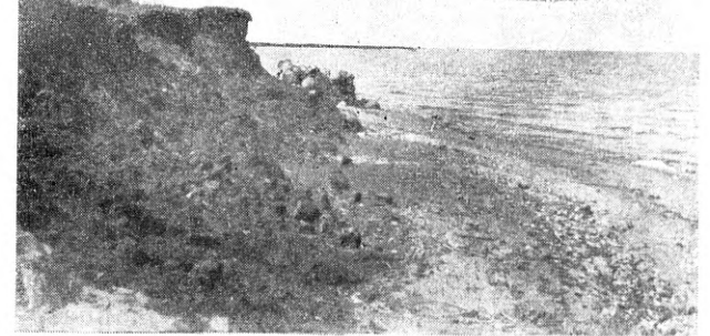
Joon. 14. Vidovitši küla. Vaade kindlustatud kaldu kõrval asuvast uhitud mitte kindlustatud kaldast.
