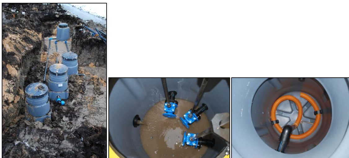
Joonis 10 Filtersüsteemi ehitus (Fotod: Argo Kuusik).
