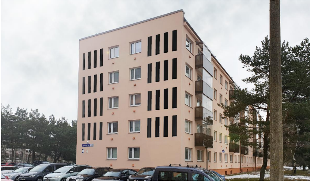
Joonis 1. Arhitekti visualiseering Sõpruse pst 246 hoone näitel energiaactiveeritud krahvisüsteemiga renoveeritava hoone otsaseinast. Tumedad vertikaalsed päikesepaneelid moodustavad koos tumedate rõdu klaaspiiretega harmoonilise terviku. Paneelide vahele peaksid jääma tavalise krahvisüsteemiga alad, võimaldamaks efektiivsemat niiskuse välja kuivamist. (Kertsmik, 2021)
