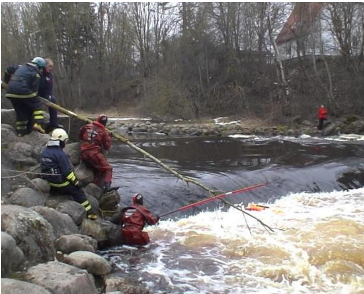
JOONIS 27-6 Vabapinnaga voolamine jõesängis. Pirita jõe Nehatu lõigule suurvee vooluhulk Q_{10\%} = 121 m 3 .s -1 . (Foto: Postimees, 2010)
