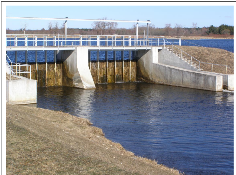
JOONIS 9-1 Paisu regulaatorsõlm varjadega avadel, Põltsamaa. (Foto: Ülar Jõesaar, 2014)
