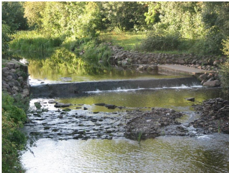
JOONIS 27-4 Vabapinnaga voolamine jõesängis (Nehatu pais, Pirita jõgi, 2010.a. suvi). Pirita jõe nõ Nehatu lõigule sanitaarvooluhulk Q_{95\%} = 3,3 m 3 .s -1 .
