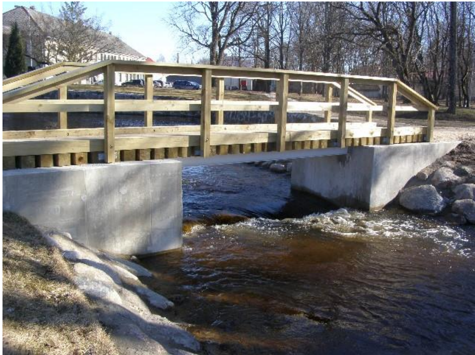
JOONIS 8-1 Sillakonstruktsioonid avasängi külgkitsendusena, Põltsamaa. (Foto: Ülar Jõesaar, 2014)
