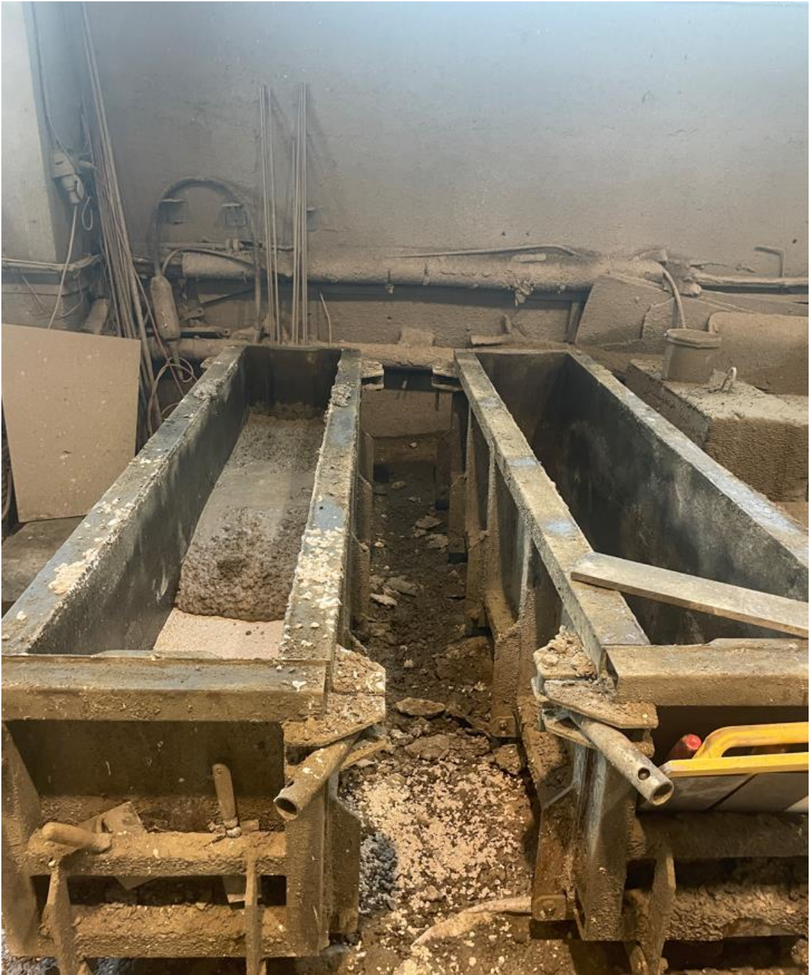
Pilt 21. Vundamendiploki/vastukaalu raketis
