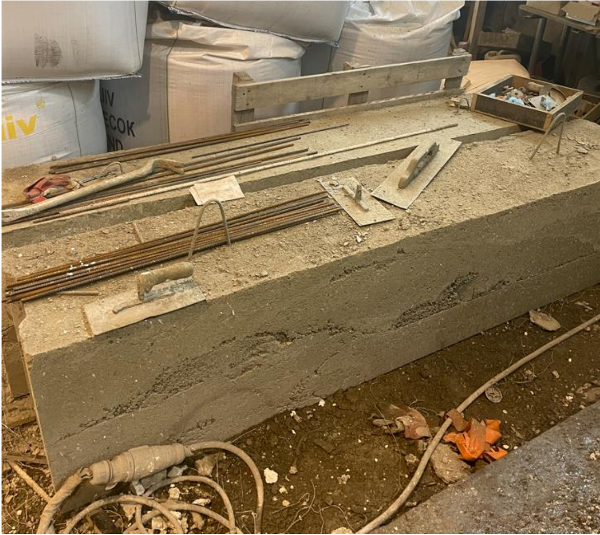
Pilt 22. Valmis vundamendiplokk/vastukaal
