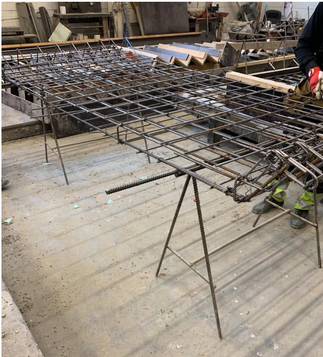
Pilt 5. Armatuurkarkassi sidumine pukkidel
