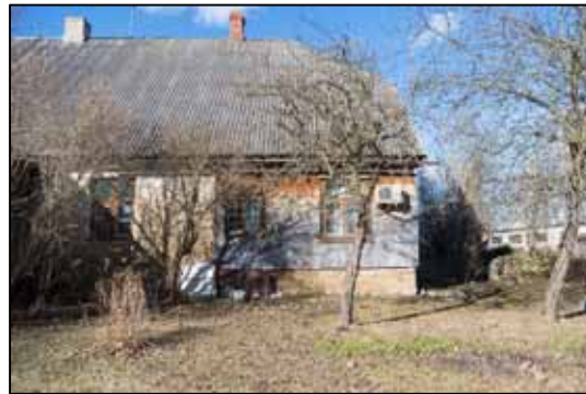
Foto 42. Hoone lõunapoolse fassaadi idapoolne ots. Pildil näha ka lõunapoolse veranda kõrval kasvav taimestik. (Foto: autor, aprill 2015)
