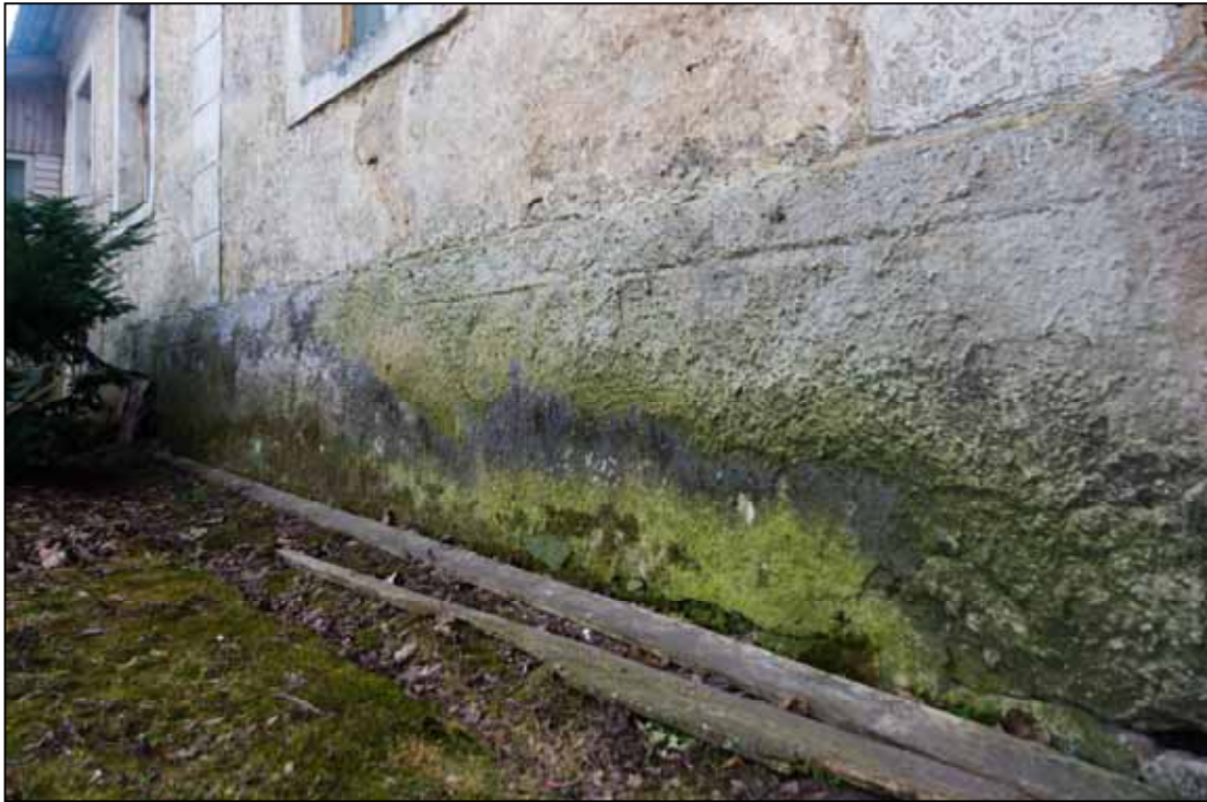
Foto 8. Vetikad hoone soklil põhjapoolses küljes. Taamal paistavad puitplaadid, mis katavad soklisse raiutud auke. (Foto: autor, aprill 2015)
