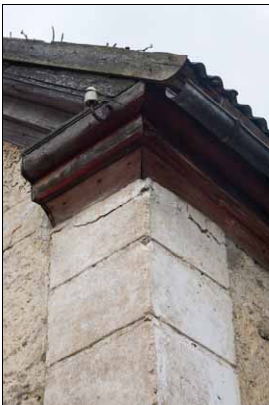
Foto 10. Säilinud puidust karniis ning praod hoone edela nurgas asuva liseeni ülemises servas. (Foto: autor, aprill 2015)
