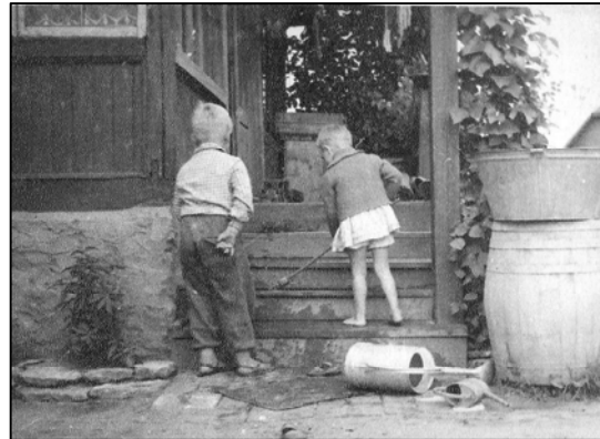
Foto 35. Vaade lõunapoolsele puitverandale. (Foto: Ester Tartlan, 1964) 134
