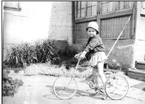
Foto 34. Vaade lõunapoolsele puitverandale. (Foto: Ester Tartlan, 1964). 133
