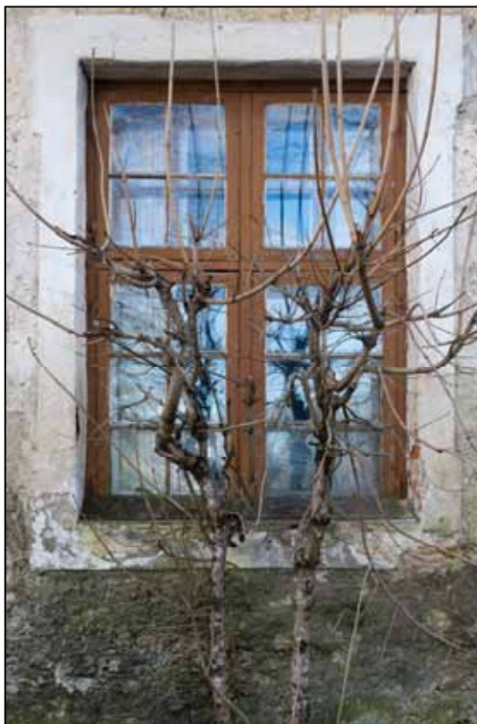
Foto 13. Algupärase tiheda ruudujaotusega aken (A02) kivist hooneosa põhjaküljel (Foto: autor, aprill 2015)
