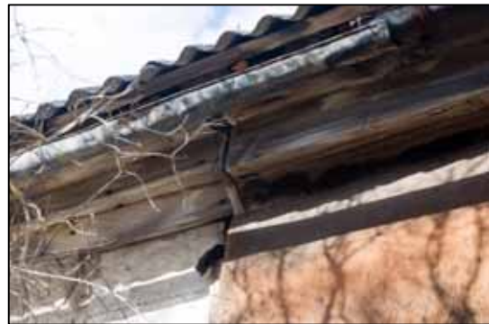
Foto 45. Lihtsama profiiliga karniis puidust hooneosa lõunaküljel. (Foto: auto, aprill, 2015)
