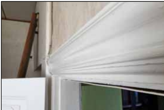
Foto 56. Siseukse SU09 ukseliistu profileering.. (Foto: autor, aprill 2015)
