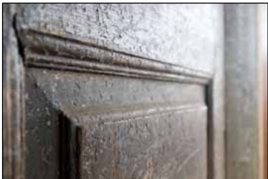
Foto 38. Detail välisukse VU02 tahveldisest. (Foto: autor, aprill 2015).
