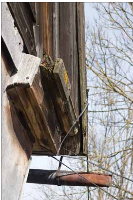
Foto 15. Halvas seisus puidust karniis ning vihmaveerenni ots hoone kirdenurgas. (Foto: autor, mai 2015)
