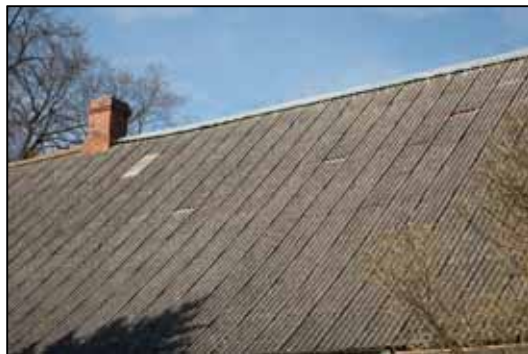
Foto 39. Vaade hoone katusekattele ning läänepoolsele korstnapitsile. (Foto: autor, aprill 2015).
