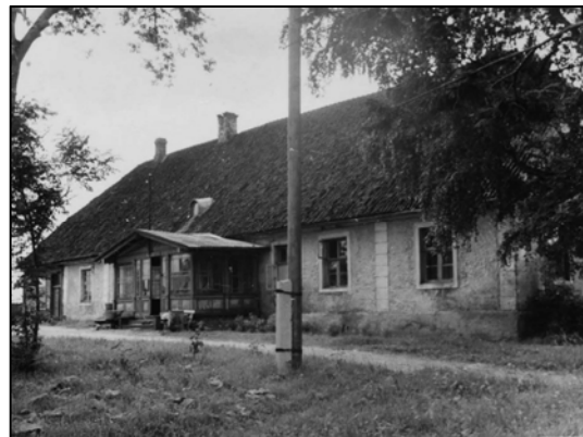
Foto 29. Vaade Lüganeuse pastoraadihoonele loodet. Pildil näha ka põhjapoolne puidust veranda. (Foto: V.Ranniku, 1969) 128
