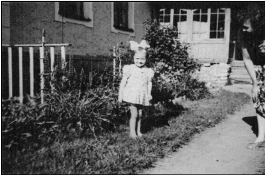
Foto 32. Vaade lõunapoolsele verandale. Pildil on näha sokli kahjustused. Foto 1960-ndatest. 131
