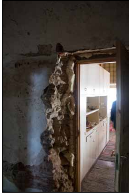
Foto 61. Köögi (Ruum 8) ja koridori (Ruum 9) vahelisse seinä raiutud ukseava. (Foto: autor, aprill 2015).
