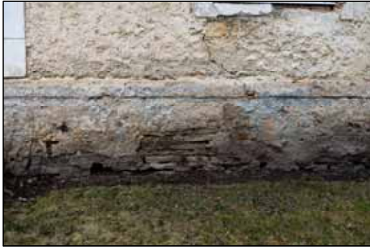
Foto 40. Praod soklis ja seinas hoone lõunafassaadil. (Foto: autor, aprill 2015)
