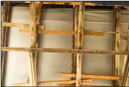
Foto 54. Põhjapoolse veranda katusekonstruktsioon.. (Foto: autor, aprill 2015)
