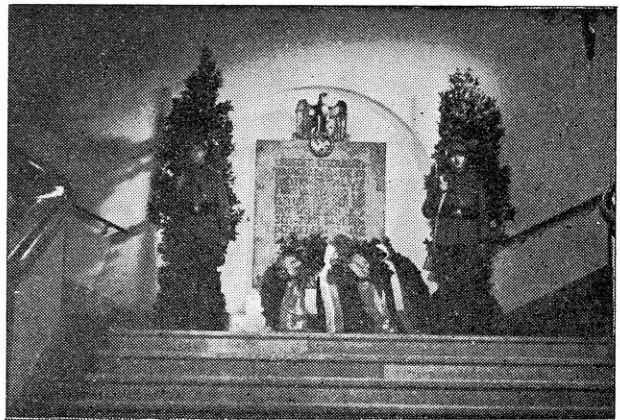
Mälestustahvel maailmasõjas langenud raudteelastele Nürnbergi raudteedirektsiooni hoones.
