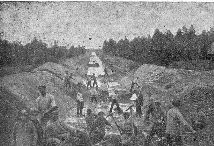
Pilt nr. 1. Uue-Lõve-Haeska magistraalkanal Saaremaal. Kaevamisel. Pärast kaevamistööde läbiviimist.
