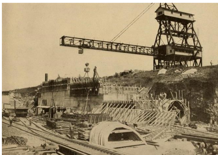
Joonis 2. Betooni käitlemine kraanaga lüüside ehitamisel
