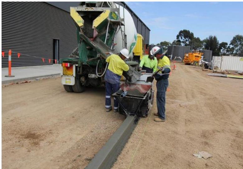
Joonis 3.8 Ekstruuder meetodil äärekivide paigaldamine väikese laoturiga Austraalias [37]
