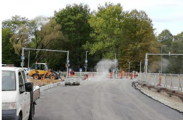
Joonis 1.2 Äärekivide lõikamine Reidi teel, autor Liivar Laks
