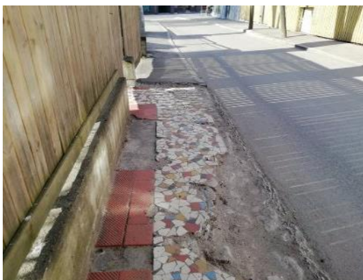
Joonis 1.1 Paekivikillustikust äärekivi Tallinnas Loode tänaval, autor Liivar Laks
