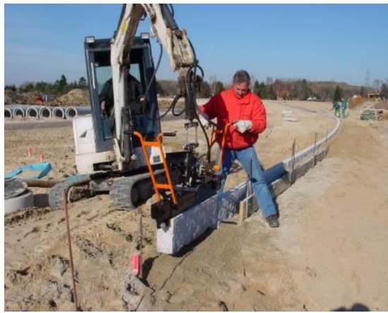
Joonis 3.14 Hüdraulilise haaratsi abil äärekivide paigaldamine [49]
