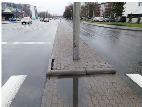
Joonis 2.6 Liimitavad betoonäärekivid Tammsaare teel, autor Liivar Laks
