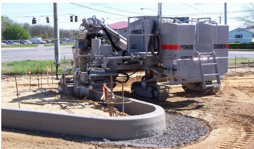
Joonis 3.7 Ekstruuder meetodil suure laoturiga äärekivide paigaldamine USA-s [35]
