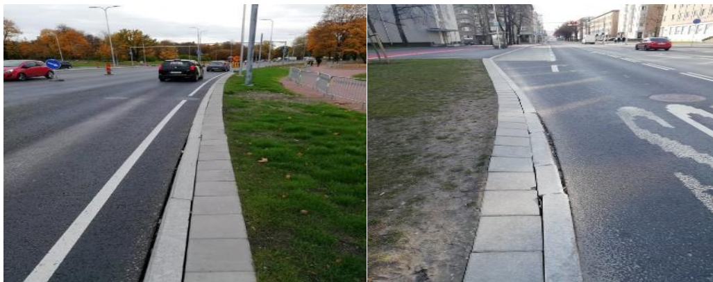
Joonis 1.4 Ära sõidetud äärekivid Reidi teel ja Gonsiori tänaval, autor Liivar Laks
