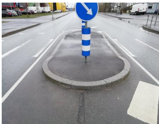
Joonis 2.4 Loodusäärekivid Männiku teel, autor Liivar Laks
