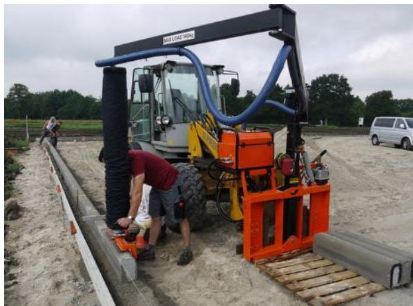
Joonis 3.15 Vaakumpumba abil äärekivide paigaldamine [50]
