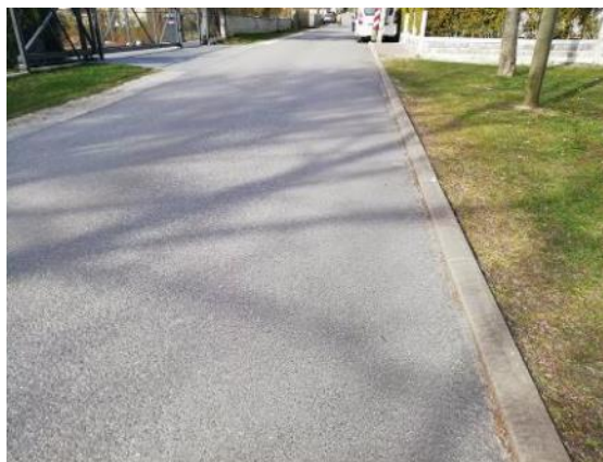
Joonis 3.6 Ekstruuder meetodil paigaldatud monoliit betoonäärekivi Aia teel Meriväljal, autor Liivar Laks
