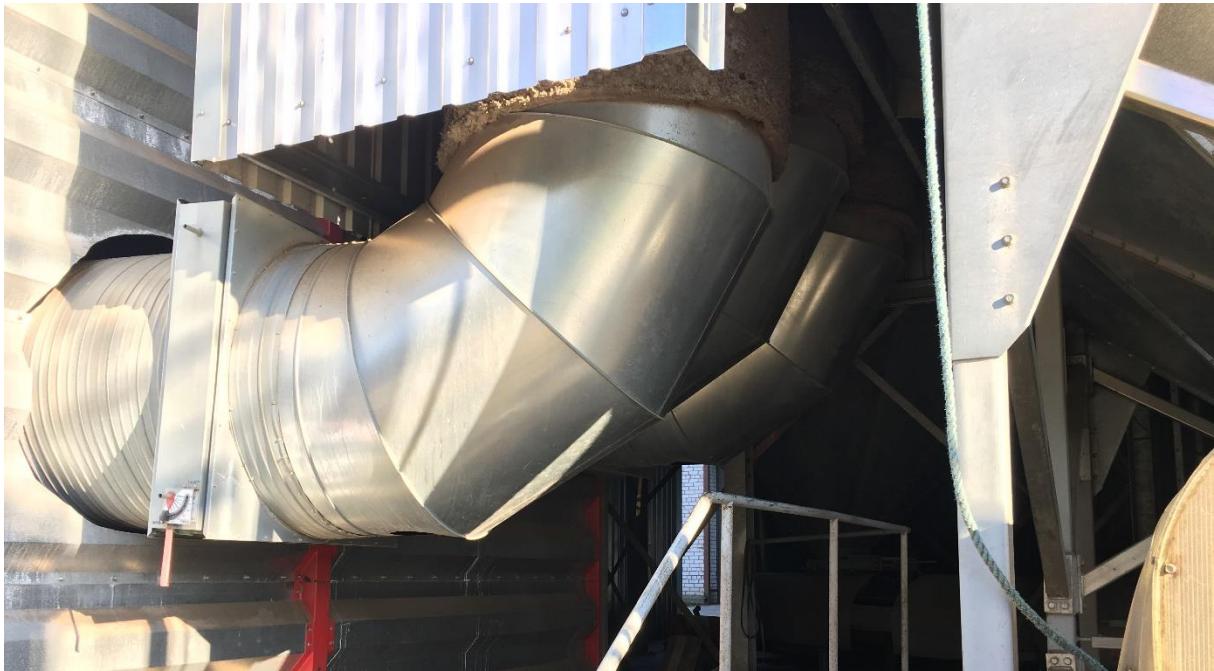
Joonis 2.6 Puudulik isolatsioon kuivati õhutorustikul
