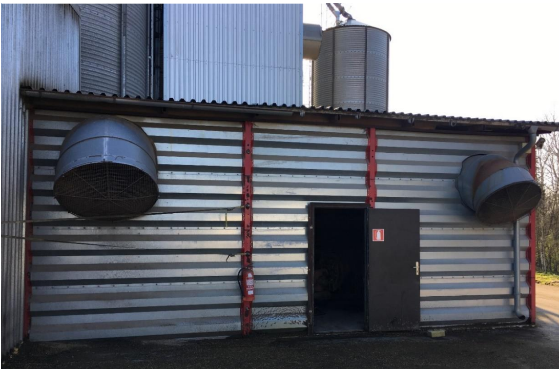
Joonis 1.8 Suure kuivati katlamaja soojusvõimsusega 1,8 MW eraldi hoones
