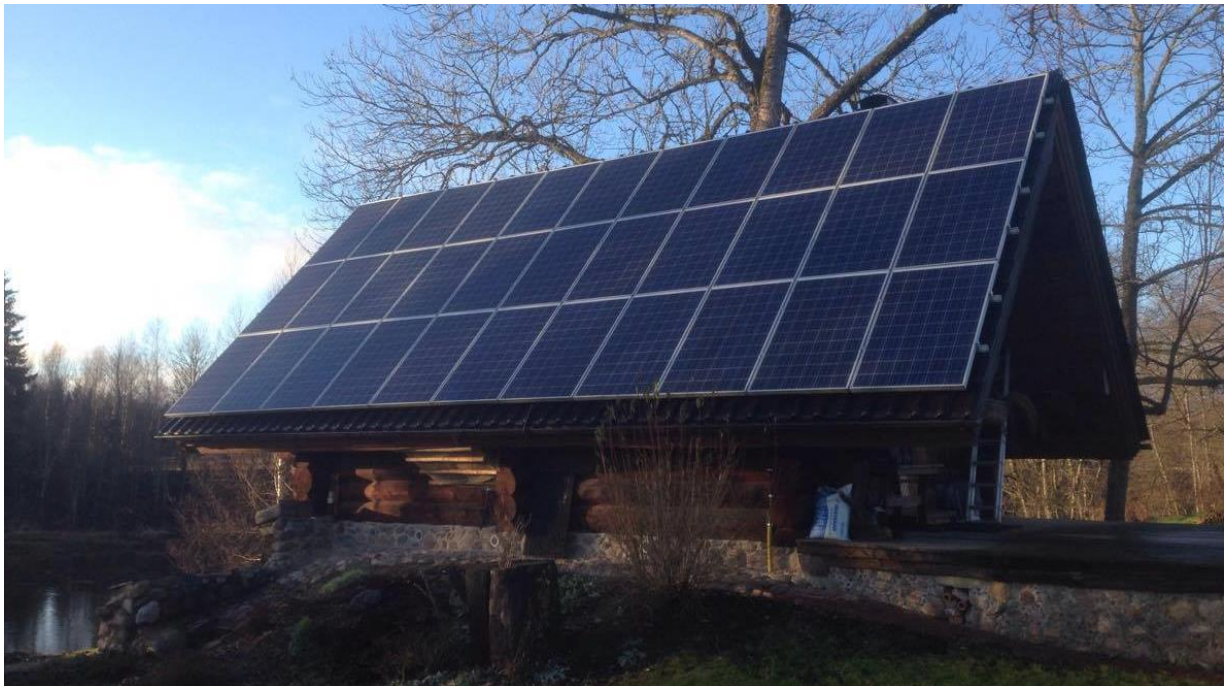
Joonis 3.4 9 kW nimivõimsusega päikesejaam Pärnumaal, Tasase talus
